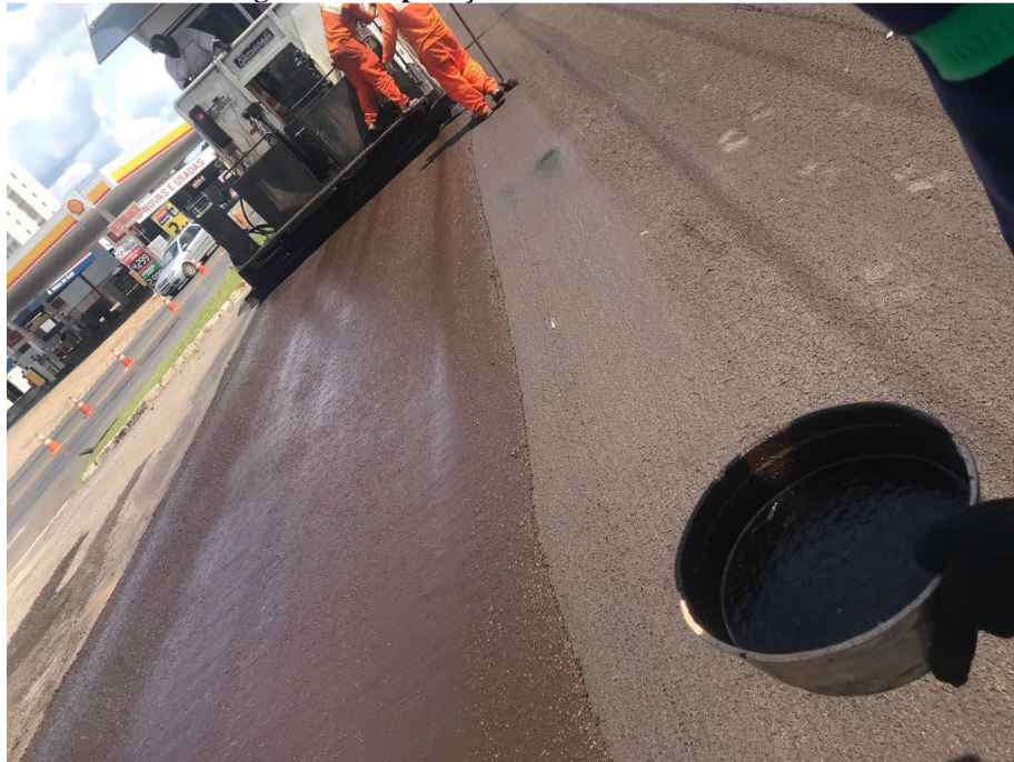
Figura 18 – Aplicação do microrrevestimento
