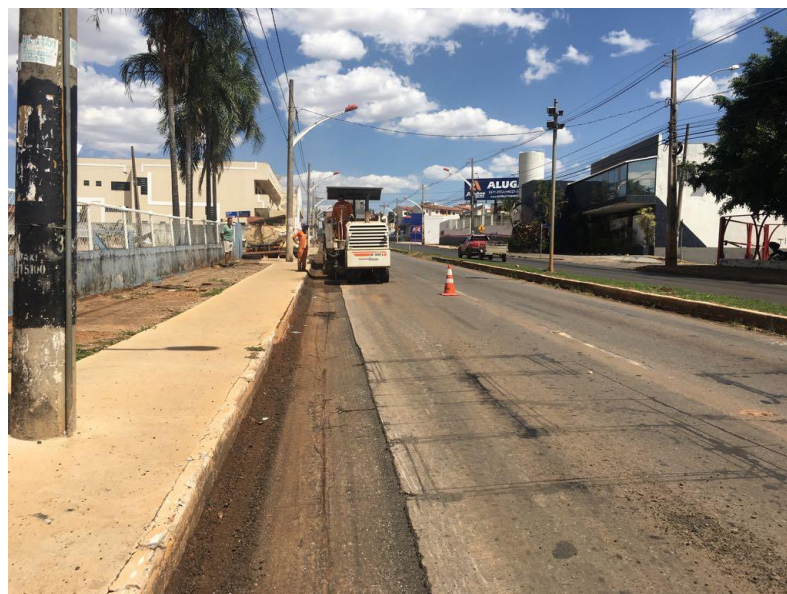
Figura 13 – Fresagem do pavimento
