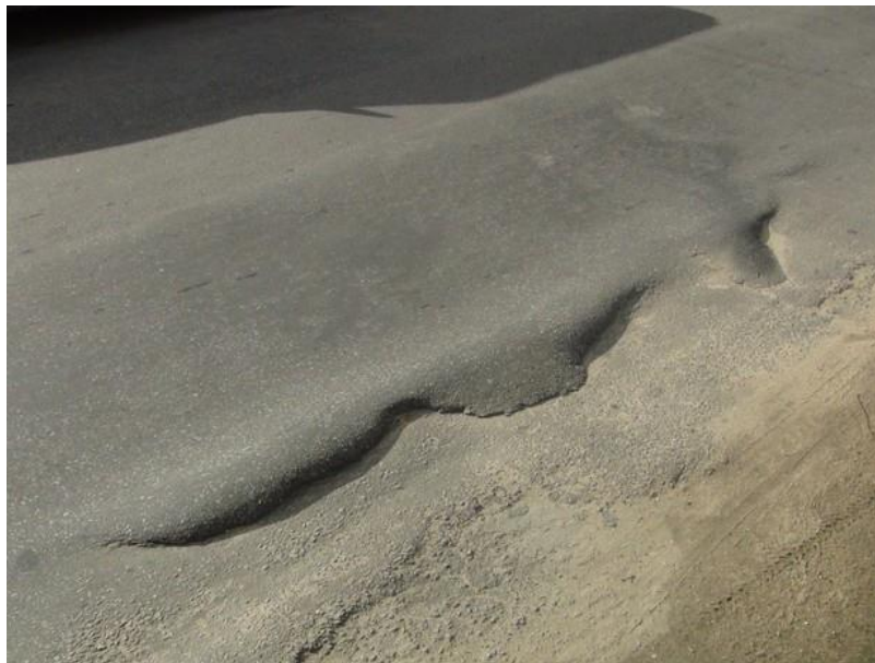
Figura 3 – Afundamento plástico na trilha da roda
