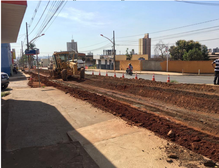
Figura 14 – Reciclagem da base
