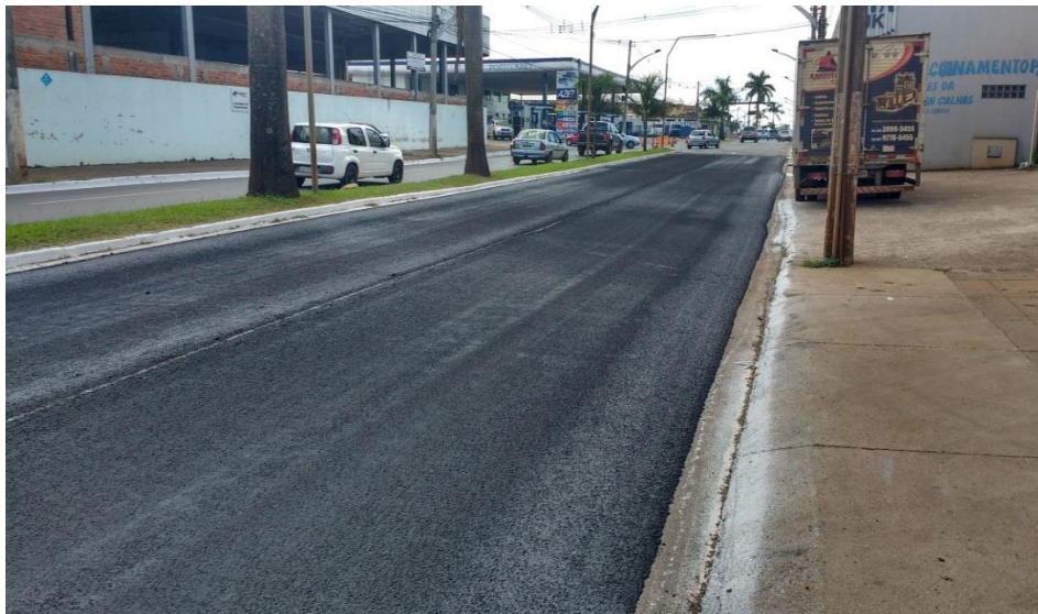
Figura 19 – Camadas do microrrevestimento finalizadas
