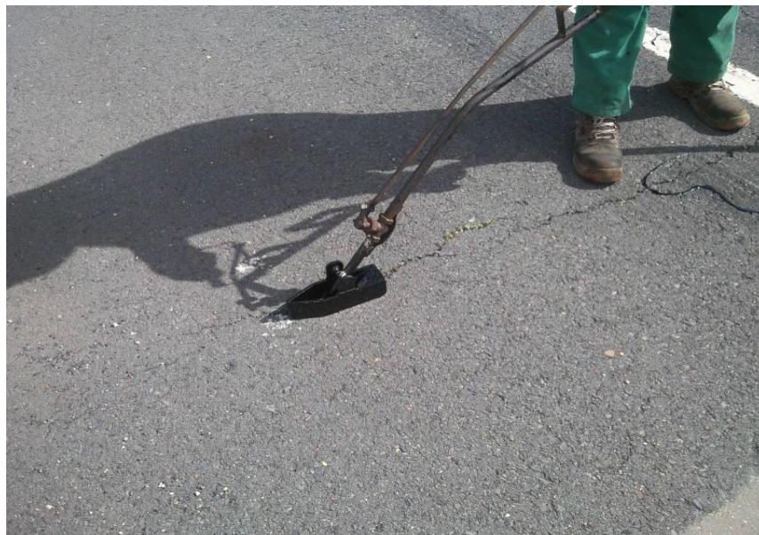
Figura 5 – Selagem de fissuras
