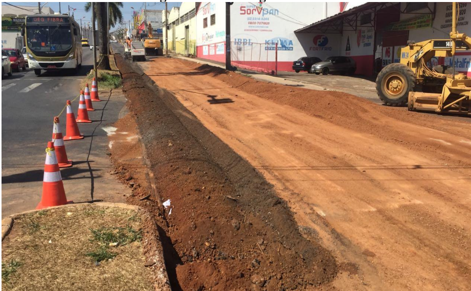
Figura 15 – Reciclagem da base
