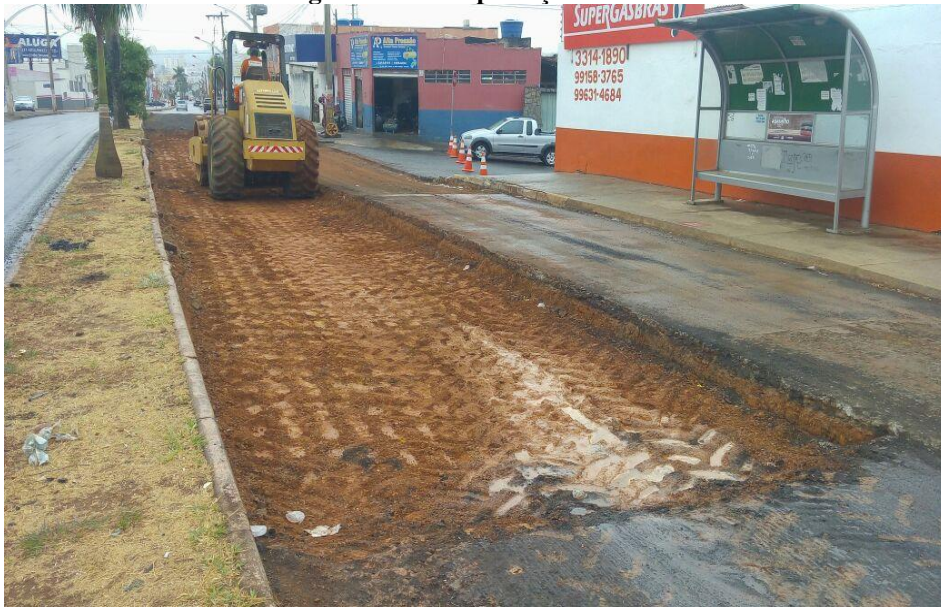
Figura 16 – Compactação da base
