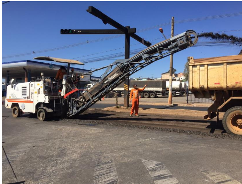
Figura 12 – Fresagem do pavimento
