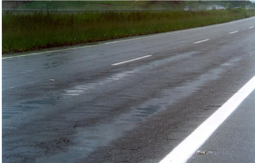
Figura 4 – Afundamento por consolidação na trilha da roda
