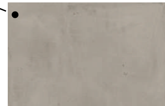
Piso em placas de concreto aparente na cor natural
