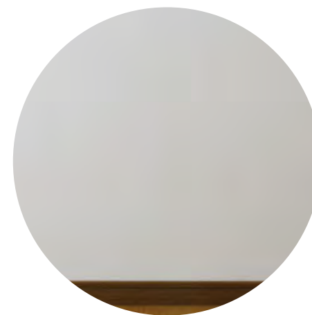
Parede alvenaria com acabamento em tinta acrílica cor branca
