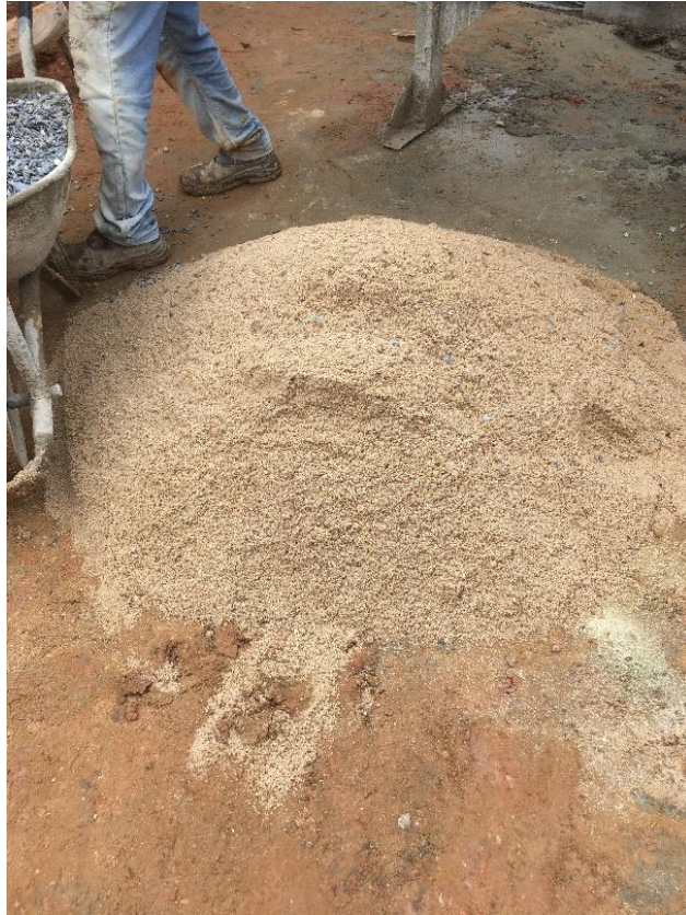
Figura 25 – Areia utilizada no traço do concreto
