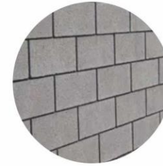
Blocos de concreto
