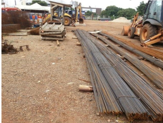
Figura 25 - Armazenamento de vergalhões.
