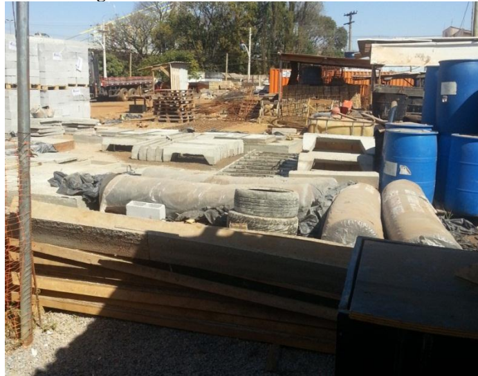
Figura 51 - Armazenamento de materiais.
