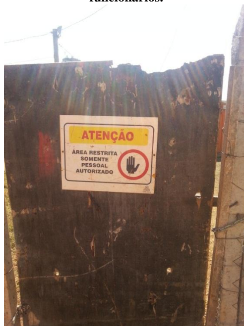
Figura 42 - Portão de entrada/saída de funcionários.
