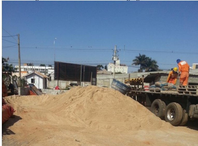
Figura 20 - Armazenamento de agregado miúdo.
