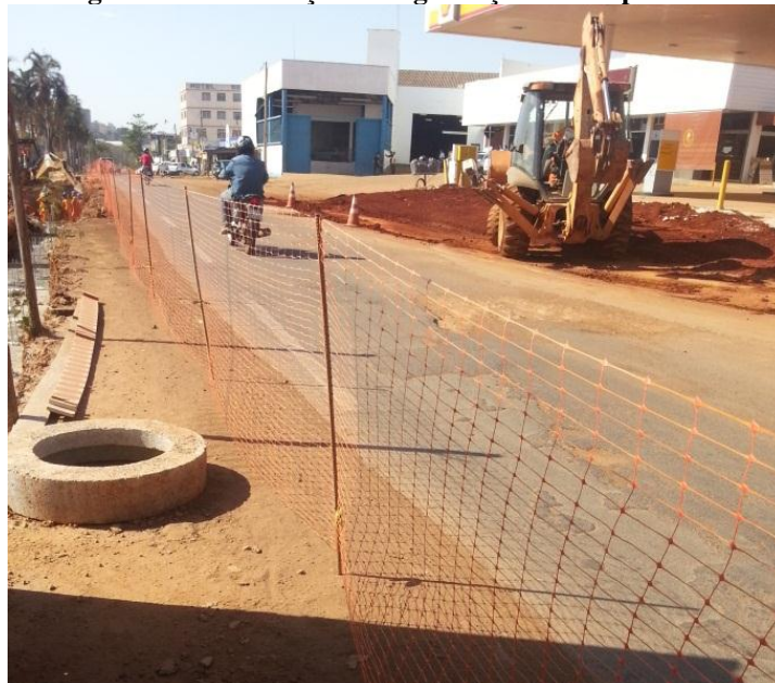
Figura 44 - Sinalização de segurança em vias públicas.
