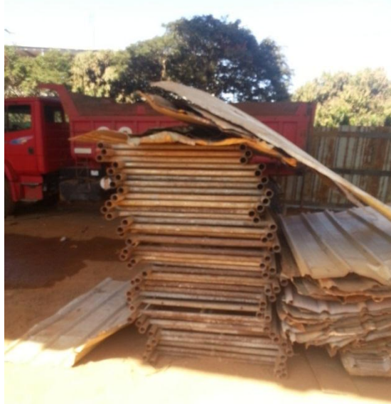
Figura 24 - Elementos dos andaimes.
