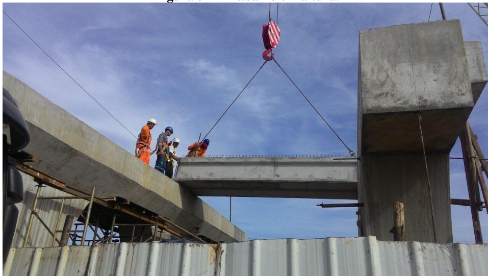
Figura 34 - Trabalho em altura.
