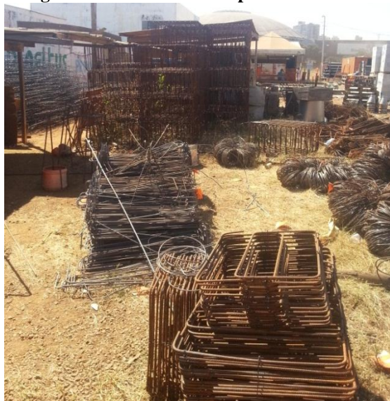
Figura 26 - Estribos dos capitéis das estacas.
