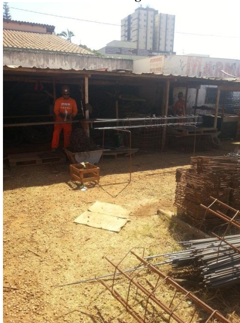
Figura 27 - Bancada para dobragem e corte de vergalhões.
