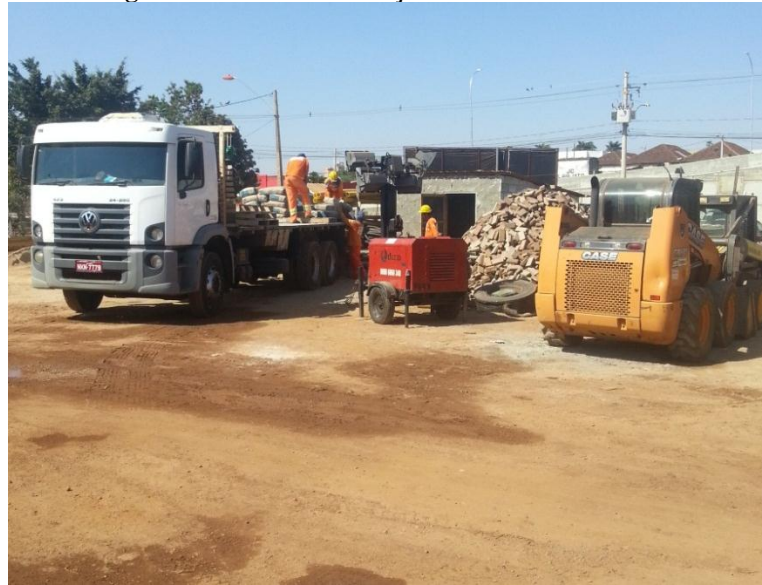
Figura 49 - Via de circulação no canteiro de obras.
