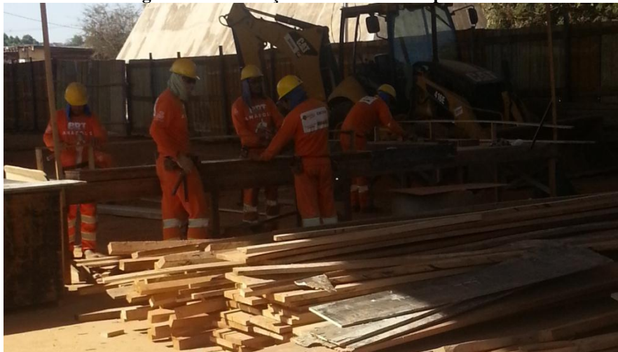
Figura 48 - Utilização dos EPI's na carpintaria.
