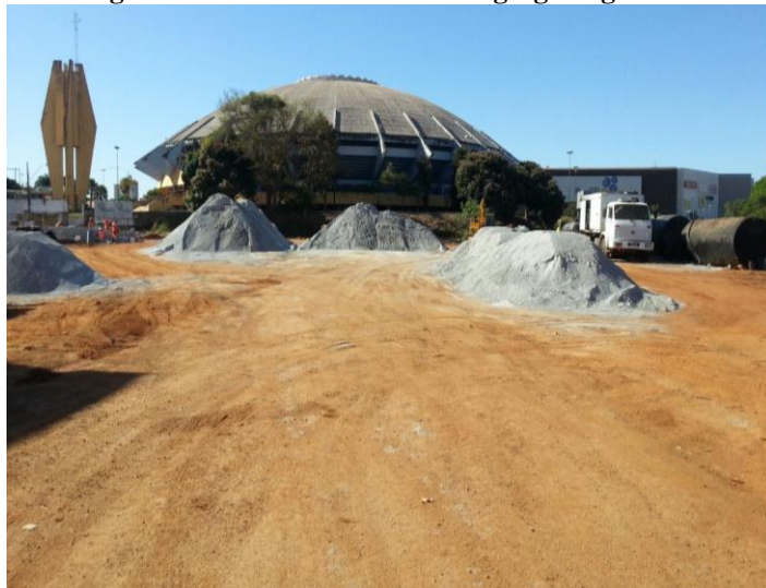
Figura 19 - Armazenamento de agregado graúdo.
