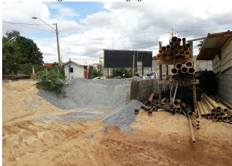
Figura 21 - Baias de agregados e tubos.
