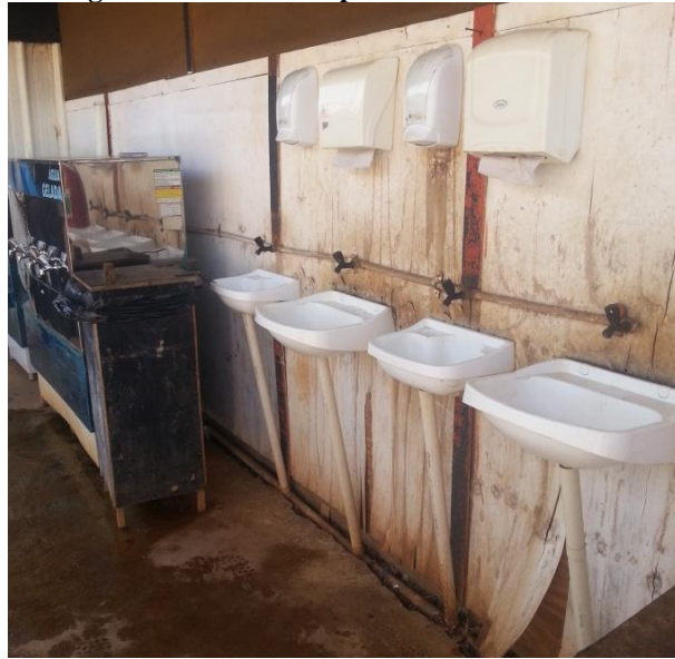
Figura 8 - Lavatórios próximos ao refeitório.
