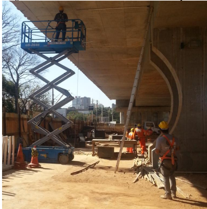
Figura 33 - Trabalhadores utilizando EPI's contra quedas.
