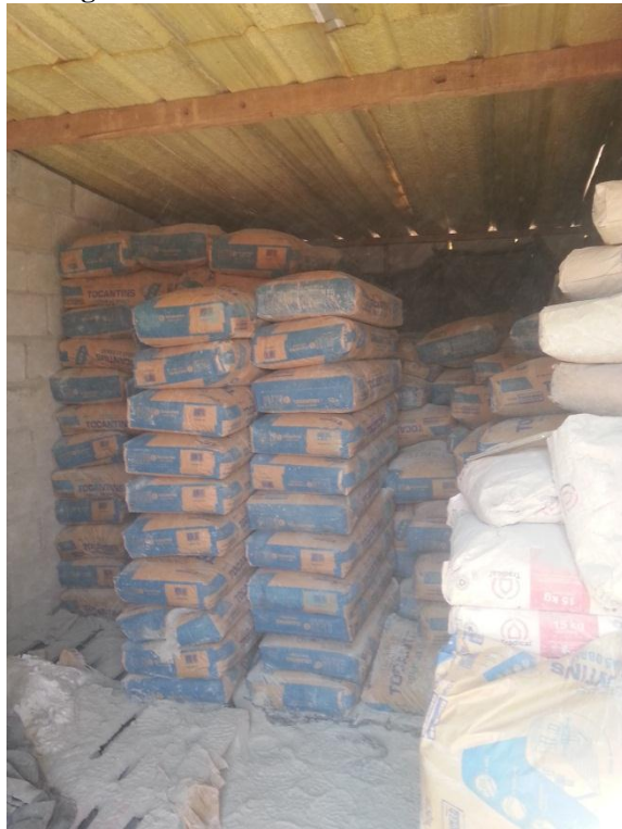
Figura 18 - Armazenamento cal e cimento.
