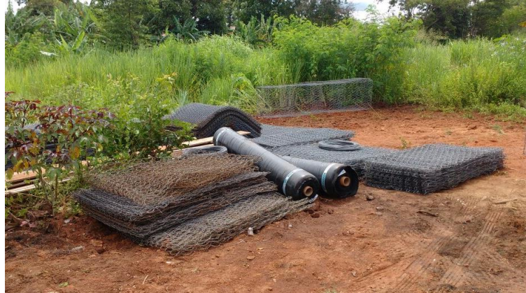
Imagem 30 - Armazenamento de telas de gabiões, arames, manta geotextil e madeiras.
