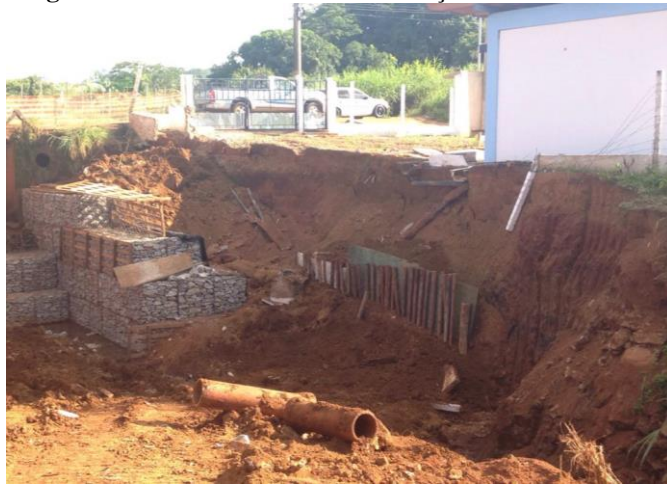
Imagem 57 - Desmoronamento e contenção de madeira.
