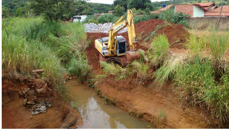
Imagem 32 - Processo de abertura do acesso para início da obra.
