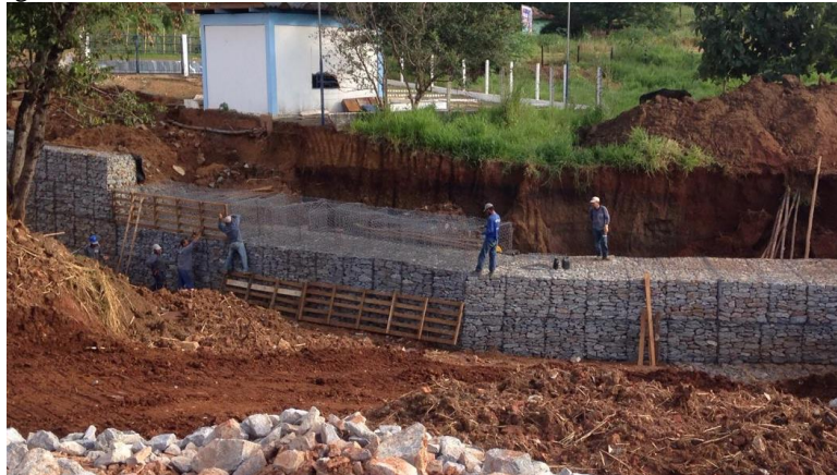
Imagem 45 - Amarração de caixas ao nível inferior e fixação de gabaritos.
