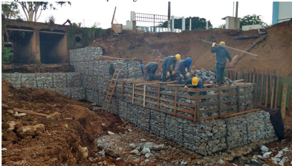
Imagem 44 - Detalhe da utilização dos gabaritos de madeira.
