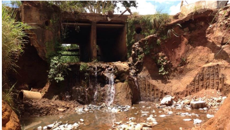
Imagem 34 - Cortes feitos na margem para o correto posicionamento da estrutura.
