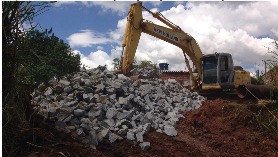
Imagem 29 - Armazenamento de pedras para o preenchimento de gabões
