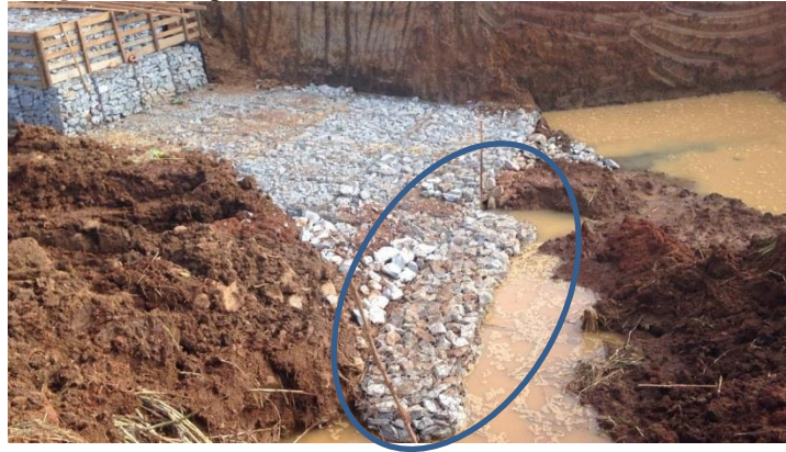
Imagem 54 - Dispersor de Velocidade (travessa).
