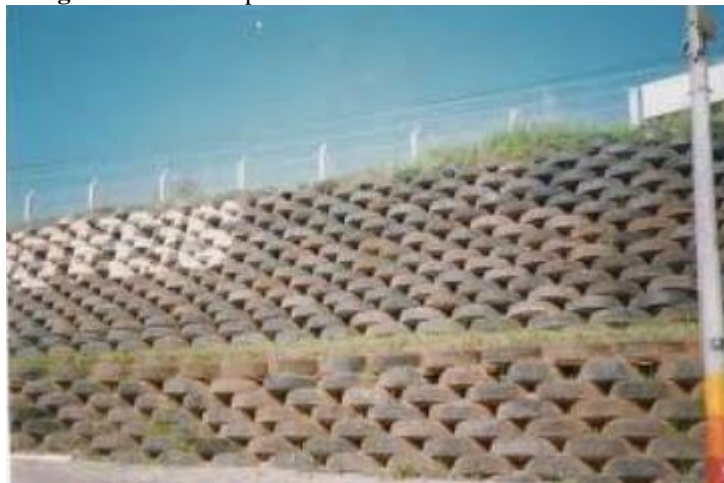
Imagem 7 - Muro de pneus
