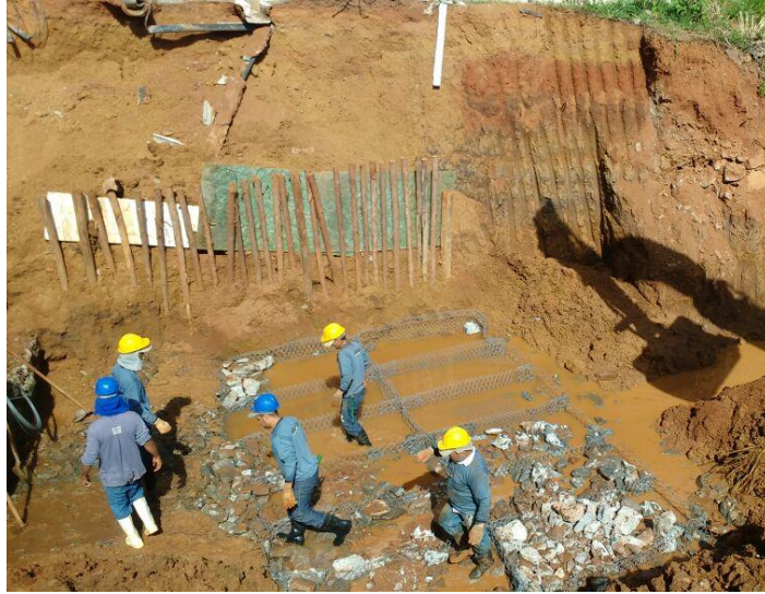
Imagem 41 - Processo de montagem do gabião tipo reno® (preenchimento com pedra marroada).
