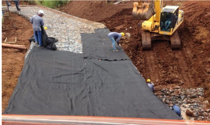
Imagem 50 - Cobertura do colchão reno® com manta geotêxtil.
