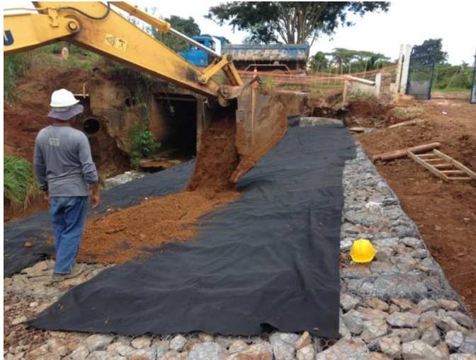
Imagem 51 - Disposição da terra com auxílio de escavadeira hidráulica.
