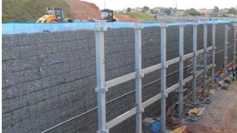
Imagem 18 - Muro de contenção em solo reforçado concluído, Arena Corinthians (SP).
