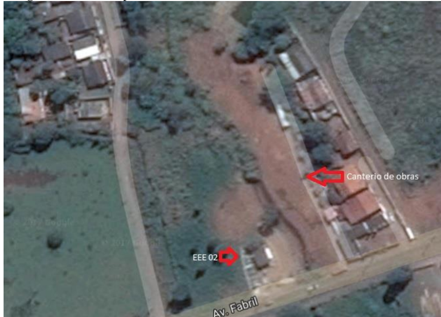
Imagem 28 - Vista superior do local do canteiro de obras em referência a EEE02.
