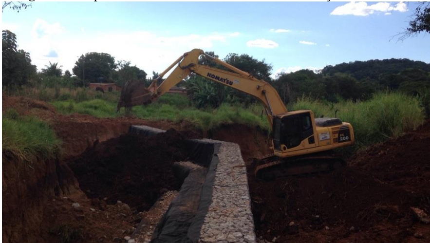
Imagem 47 - Depositando a terra atrás da estrutura de contenção.
