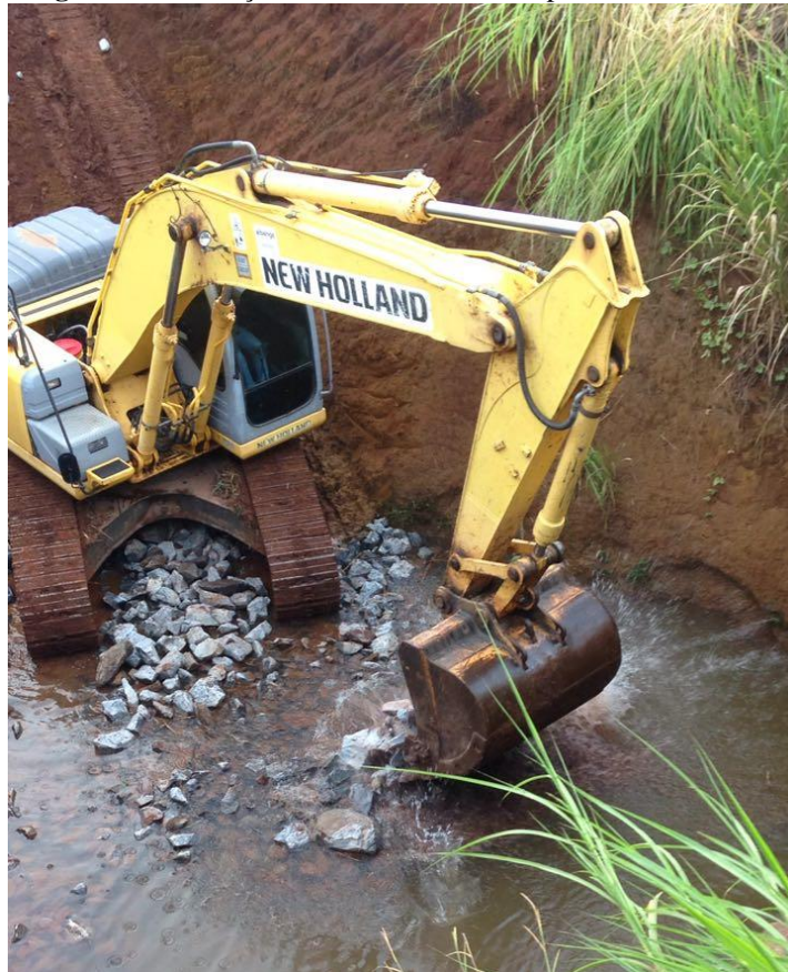
Imagem 36 - Execução do enrocamento com pedras marroadas.
