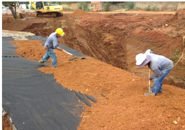
Imagem 52 - Espalhamento da terra com auxílio de ferramentas manuais.
