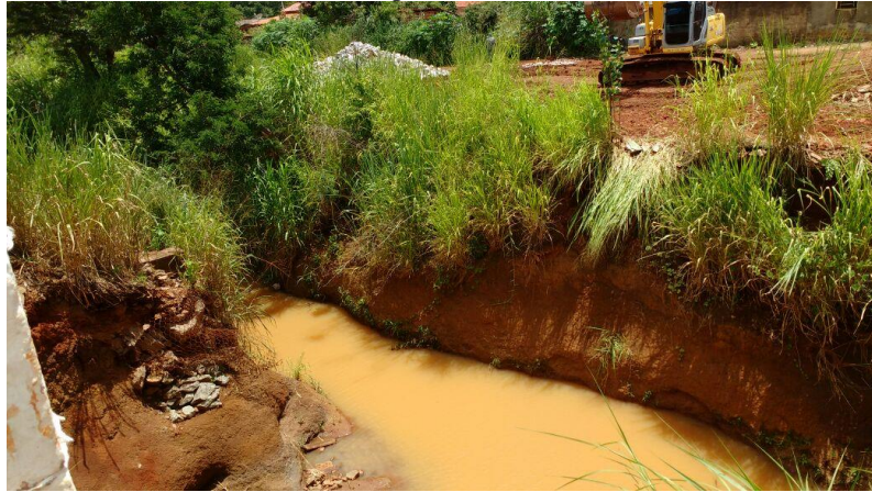
Imagem 27 - Canteiro sendo limpo com escavadeira hidráulica.
