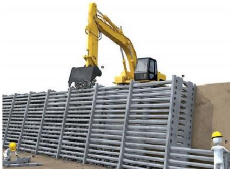
Imagem 5 - Muro de “Crib Wall”
