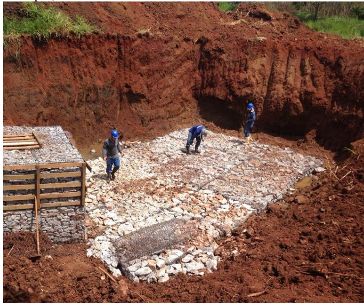
Imagem 42 - Processo construtivo do gabião tipo reno® ( fechamento de tampas).
