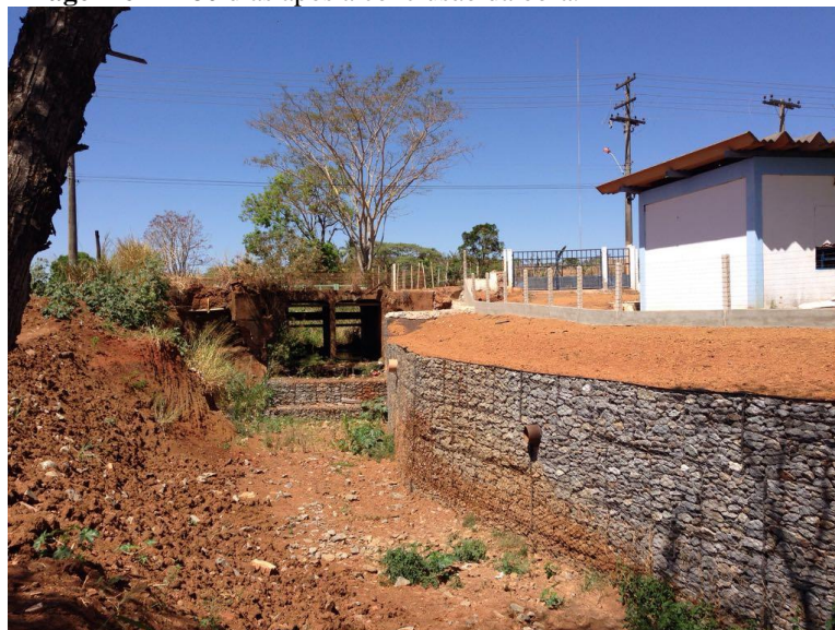
Imagem 62 - 180 dias após a conclusão da obra.
