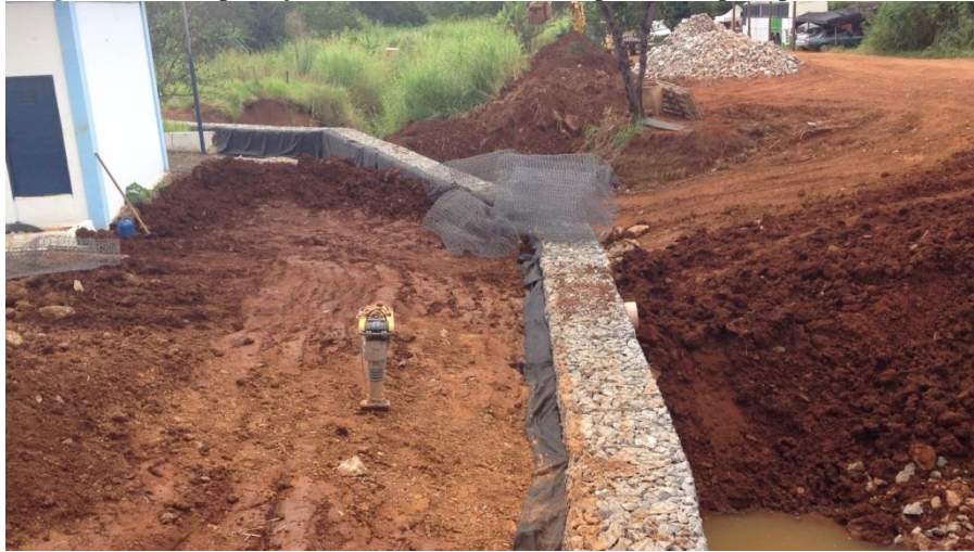
Imagem 48 - Compactação do solo usando do compactador tipo sapo.
