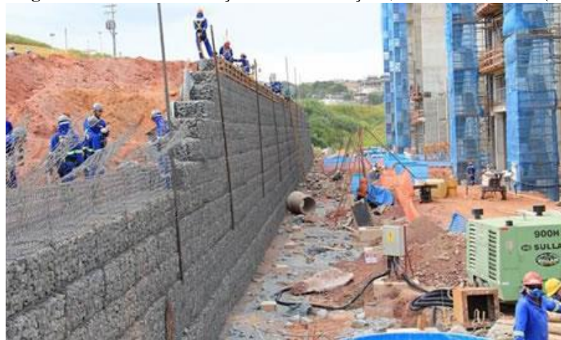
Imagem 17 - Muro de contenção em solo reforçado, Arena Corinthians (SP).
