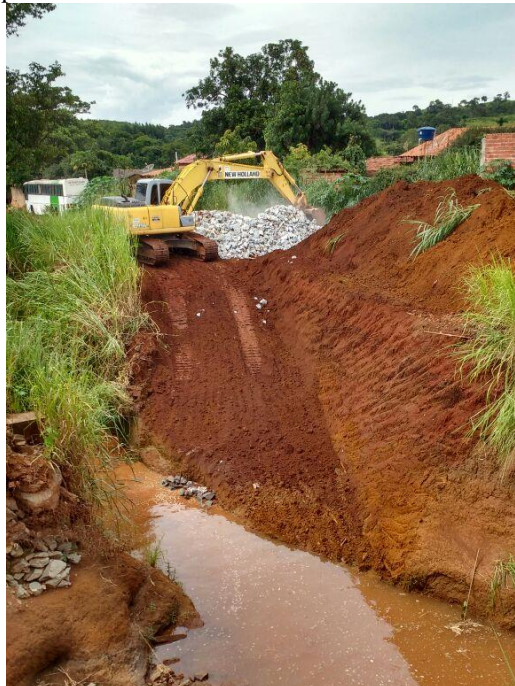
Imagem 33 - Processo de abertura do acesso para início da obra.
