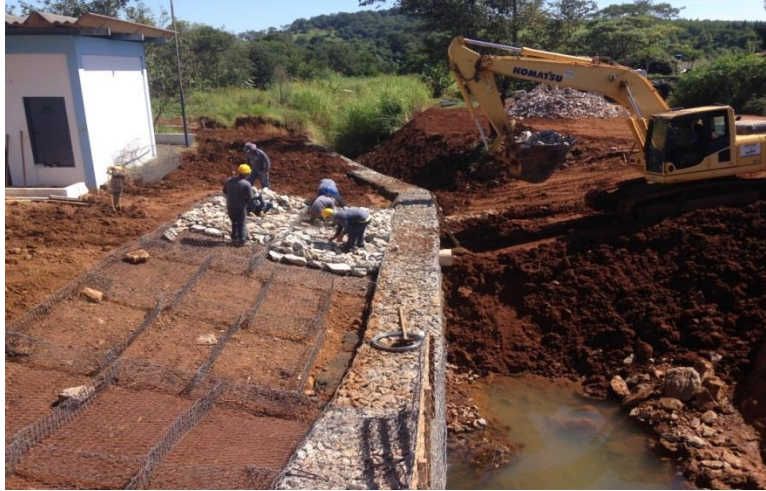
Imagem 49 - Preenchimento do gabião tipo colchão reno®.
