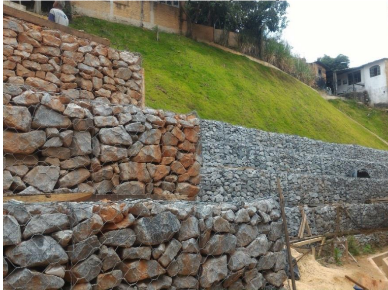
Imagem 12 - Estrutura de contenção em gabião tipo caixa
