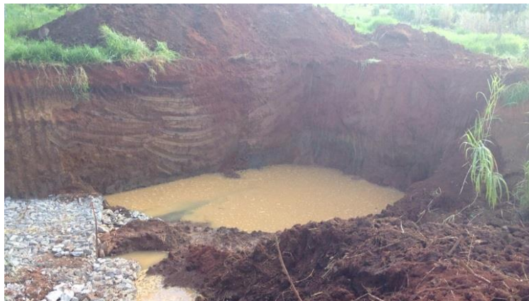
Imagem 35 - Cortes feitos na margem para o correto posicionamento da estrutura.
