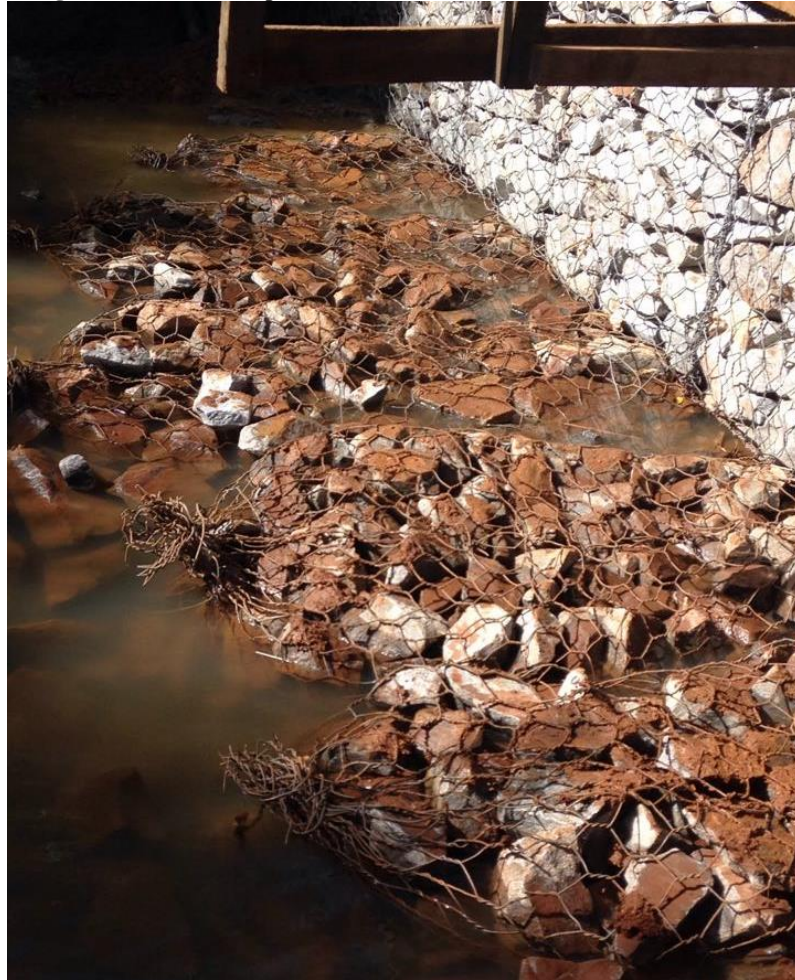
Imagem 39 - Gabiões tipo saco montados em seus devidos lugares.
