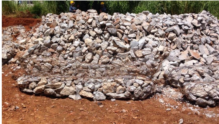
Imagem 38 - Gabiões tipo saco montados no canteiro de obras.
