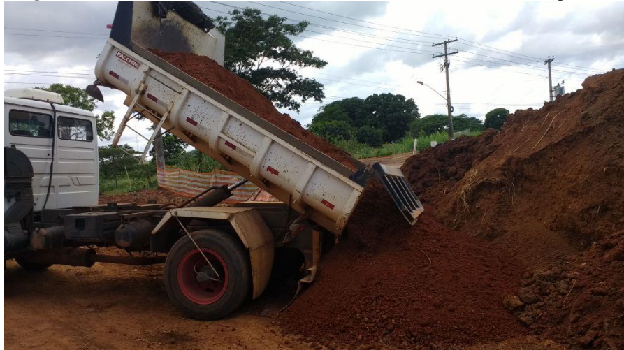
Imagem 31 - Armazenamento de solo utilizado no reaterro e em outras etapas.
