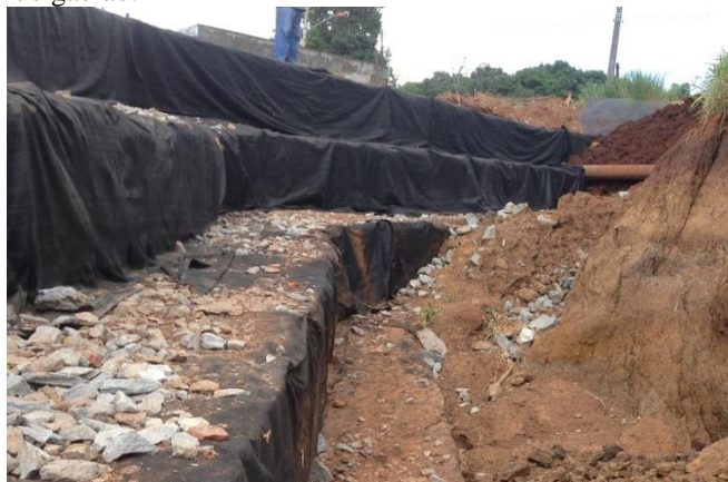
Imagem 46 - Aplicação da manta Geotêxtil na parte interna do gabião.
