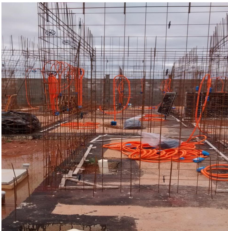
Figura 9 - Telas soldadas já posicionadas na laje, empreendimento Premiére Park.
