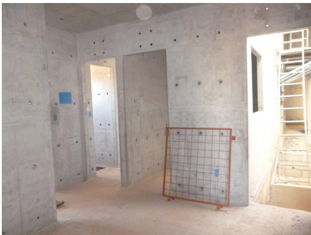
Figura 13 - Parede de concreto ainda sem revestimento, empreendimento Première Park.
