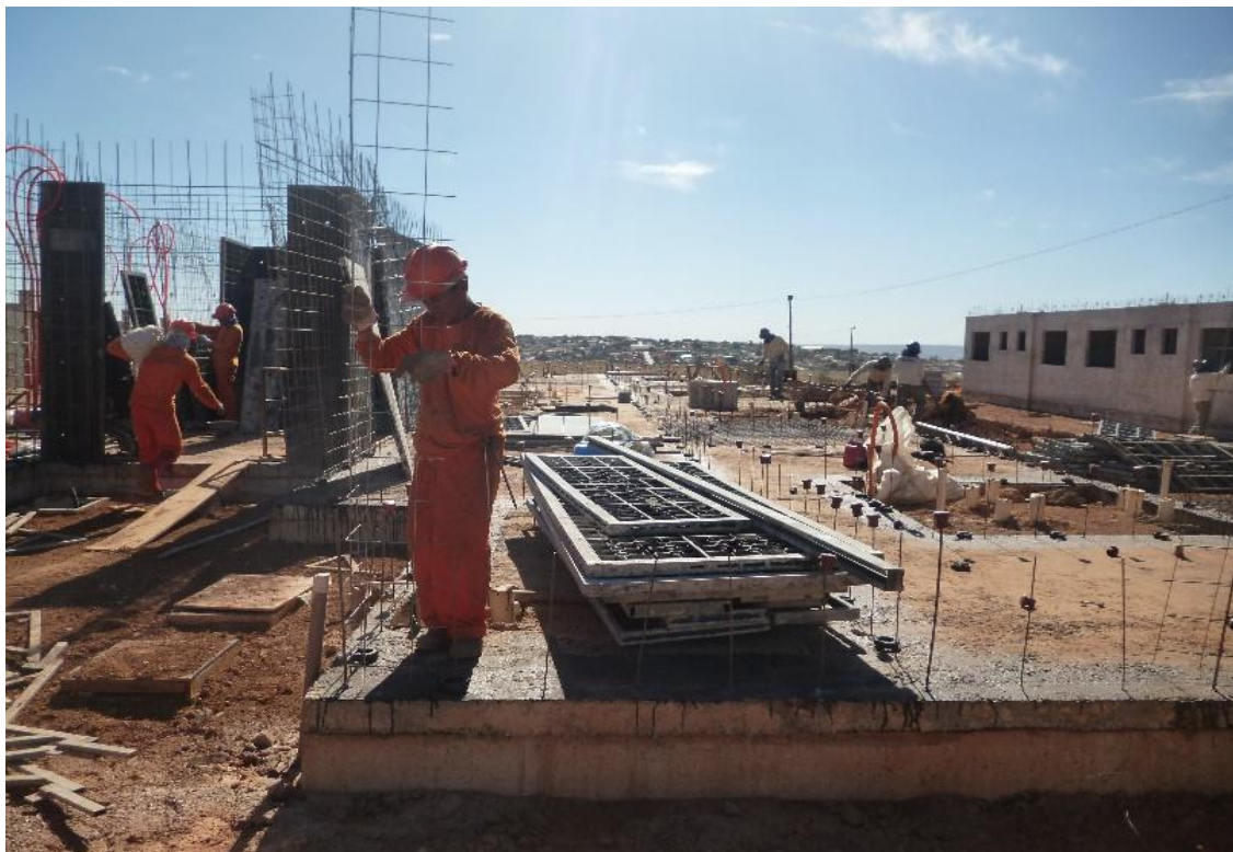
Figura 2 - Exemplo de radier estaqueado.
