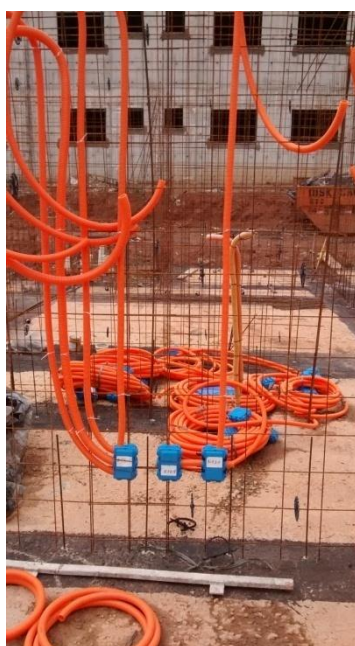
Figura 12 - Embutidos posicionados nas telas soldadas, empreendimento Première Park.
