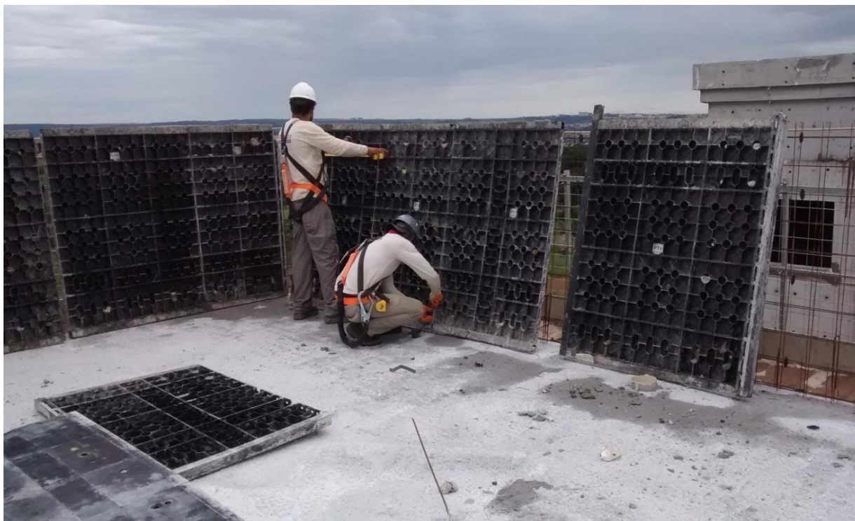
Figura 11 - Posicionamento das fôrmas plásticas, empreendimento Première Park.
