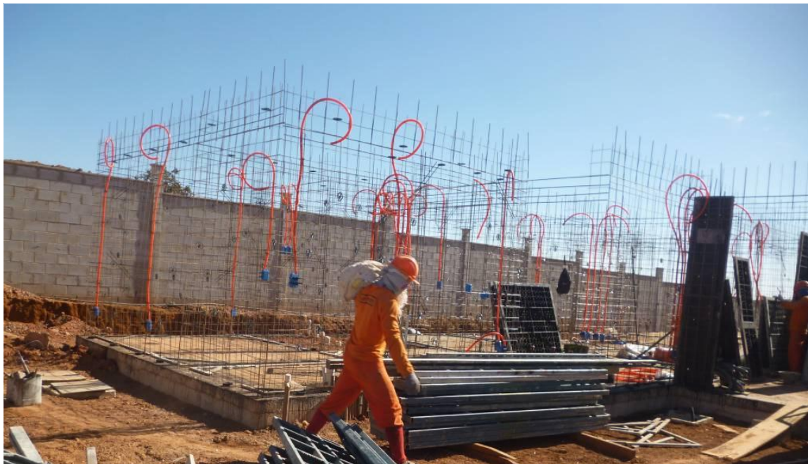
Figura 5 - Armadura dos blocos em execução, já com rede elétrica implantada, empreendimento Première Park.
