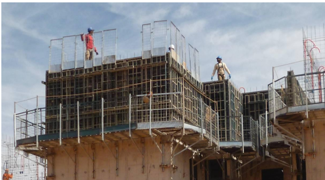
Figura 6 - Posicionamento e escoramento das fôrmas no empreendimento Première Park.
