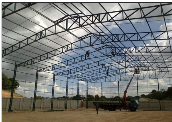
Figura 2 - Estrutura Metálica (Duque de Caxias - RJ)
