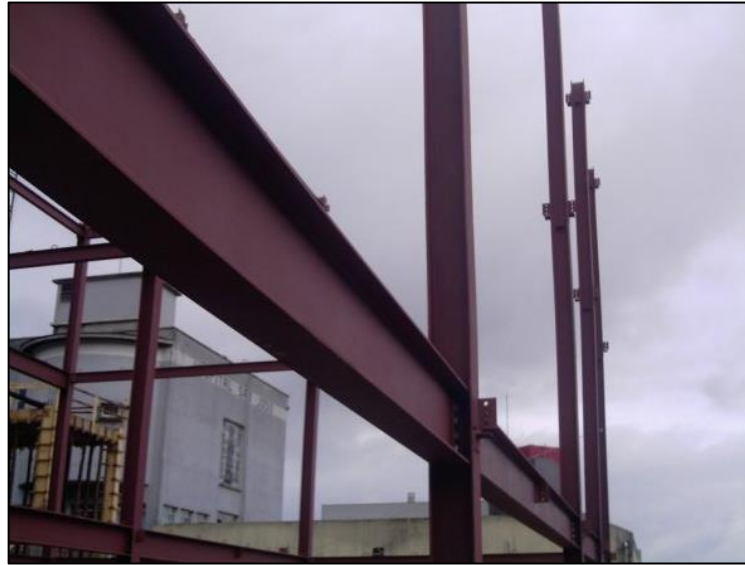
Figura 10 - Construção de Edifício com Vigas de Alma Cheia
