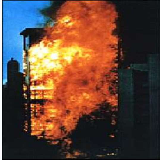
Figura 1 - Foto do incêndio do Edifício Andraus
