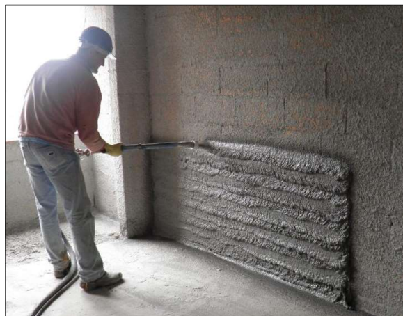
Figura 17 - Argamassa projetada
