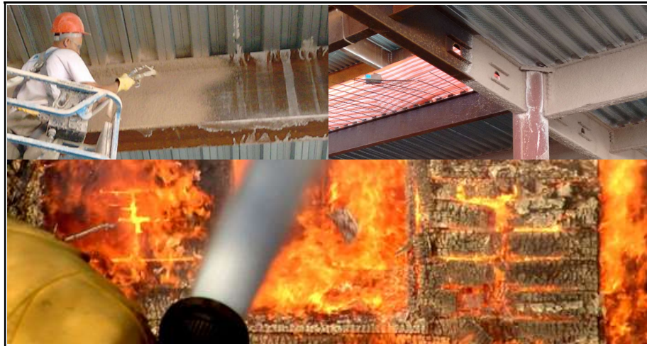
Figura 27 - Argamassa de proteção passiva – Produzida no Brasil
