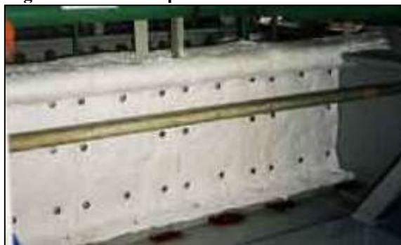
Figura 19 - Manta aplicada em estrutura metálica
