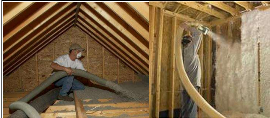
Figura 28 - Sistema Loose Fill Insulation
