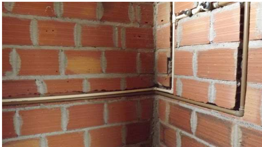
Figura 8 - Paredes rasgadas para receber eletrodutos
