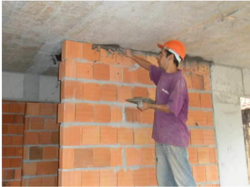
Figura 5 - Representação de encunhamento
