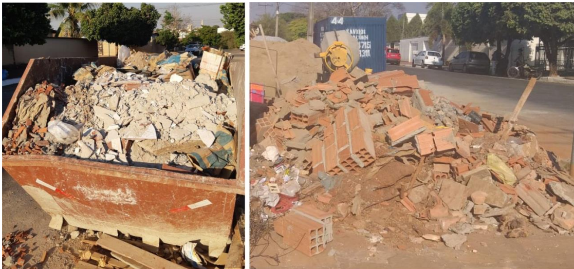
Figura 2 – Exemplo de caçamba estacionária e pilha, encontradas nas obras visitadas.
