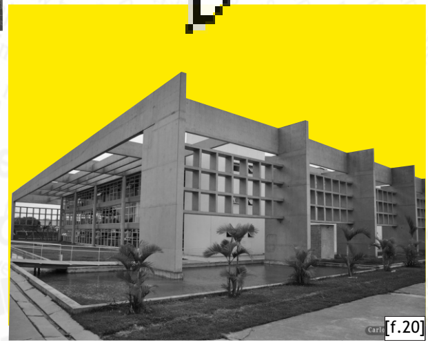
Biblioteca Parque Villa Lobos SP - Área externa
