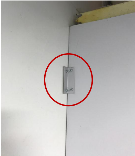
Figura 15: Processos de execução da sala limpa, montagem de painéis
