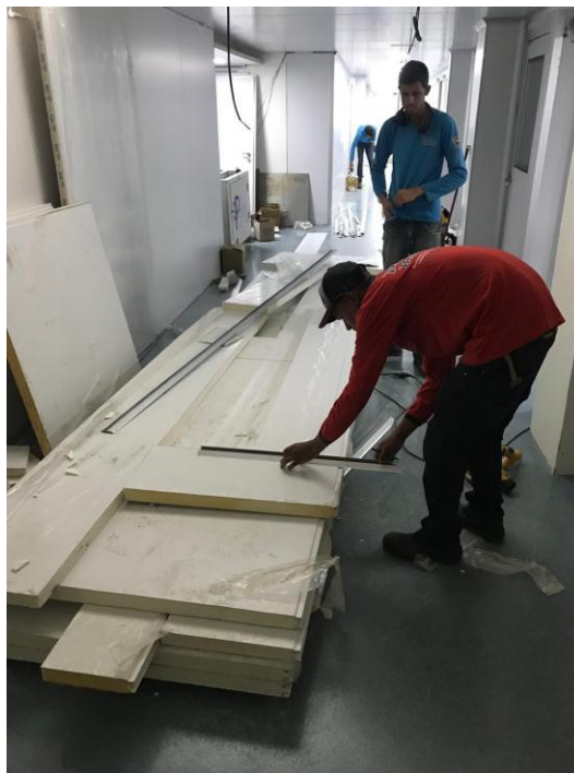
Figura 9: Processos de execução da sala limpa, montagem de painéis
