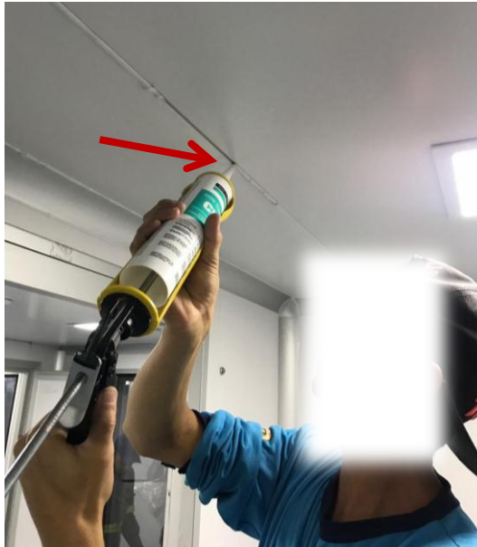
Figura 16: Processos de execução da sala limpa, montagem de painéis
