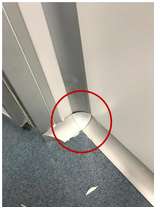
Figura 15: Processos de execução da sala limpa, montagem de painéis
