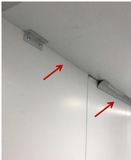
Figura 14: Processos de execução da sala limpa, montagem de painéis
