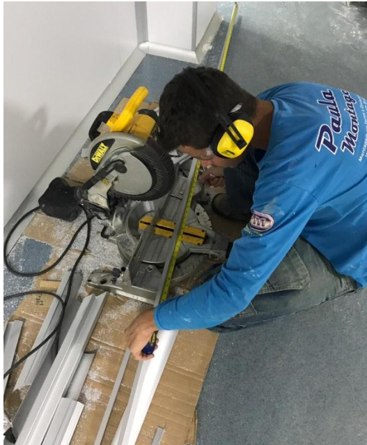
Figura 100: Processos de execução da sala limpa, montagem de painéis
