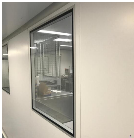
Figura 14: Processos de execução da sala limpa, montagem de painéis
