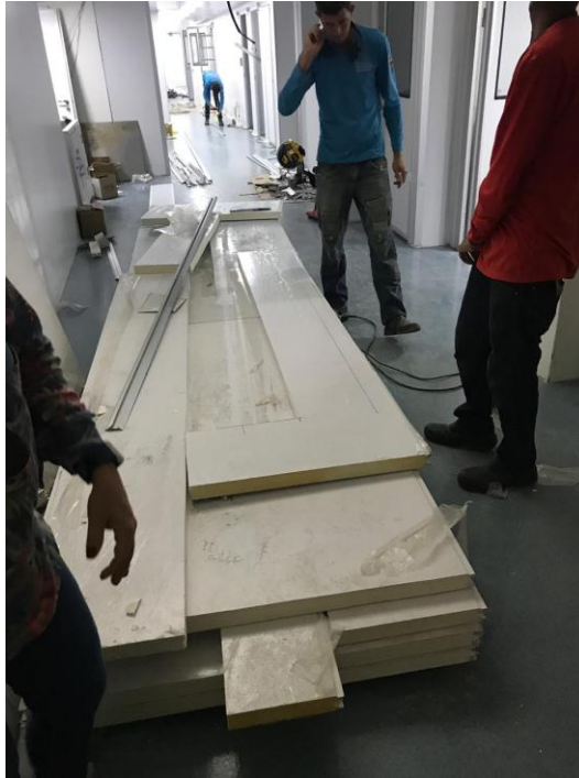
Figura 8: Processos de execução da sala limpa, montagem de painéis
