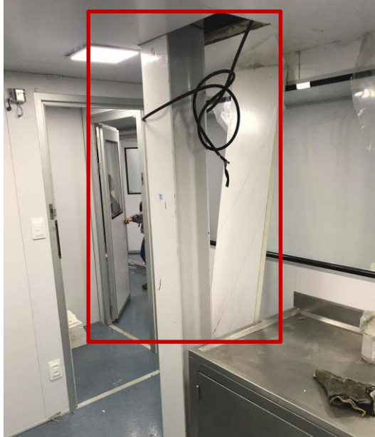
Figura 13: Processos de execução da sala limpa, montagem de painéis
