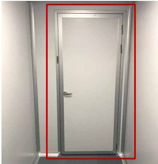
Figura 27: Processos de execução da sala limpa, montagem de painéis
