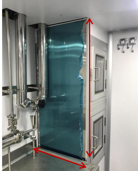
Figura 18: Processos de execução da sala limpa, montagem de painéis
