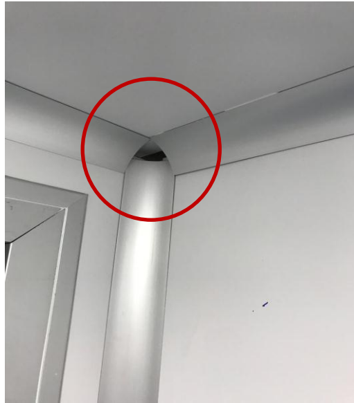
Figura 21: Processos de execução da sala limpa, montagem de painéis
