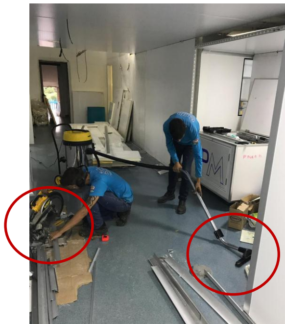
Figura 11: Processos de execução da sala limpa, montagem de painéis
