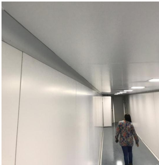
Figura 20: Processos de execução da sala limpa, montagem de painéis
