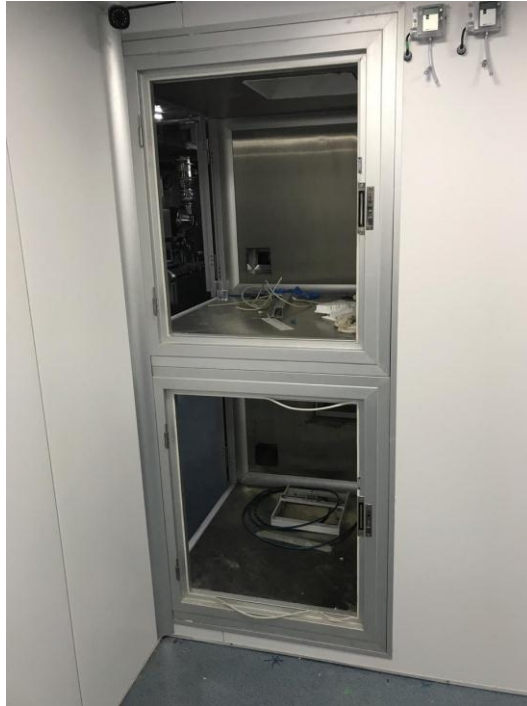
Figura 19: Processos de execução da sala limpa, montagem de painéis
