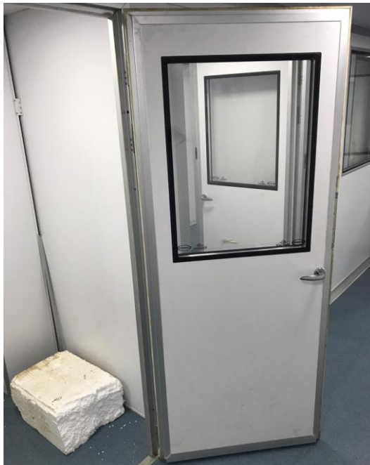
Figura 19: Processos de execução da sala limpa, montagem de painéis
