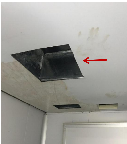
Figura 12: Processos de execução da sala limpa, montagem de painéis
