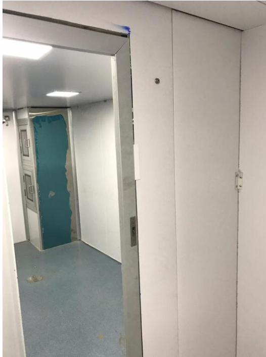
Figura 13: Processos de execução da sala limpa, montagem de painéis
