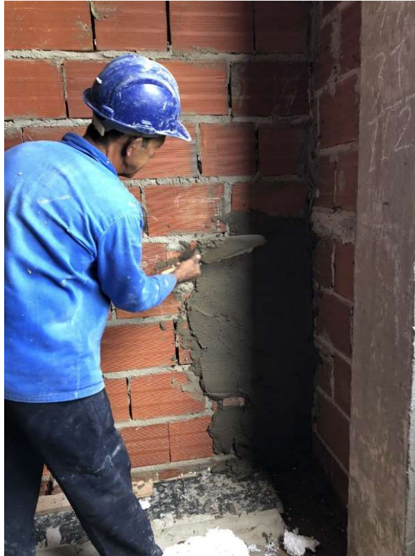
Figura 10 – Aplicação convencional da argamassa para emboço e reboco
