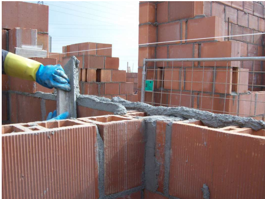
Figura 2 - Aplicação da argamassa em blocos cerâmicos
