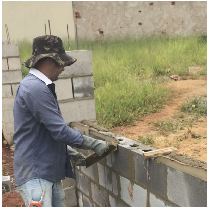
Figura 1 - Aplicação da argamassa em blocos de concreto
