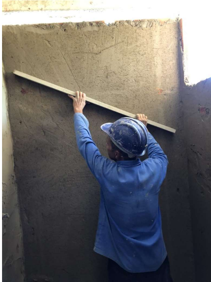
Figura 11 – Reboco sarrafeado
