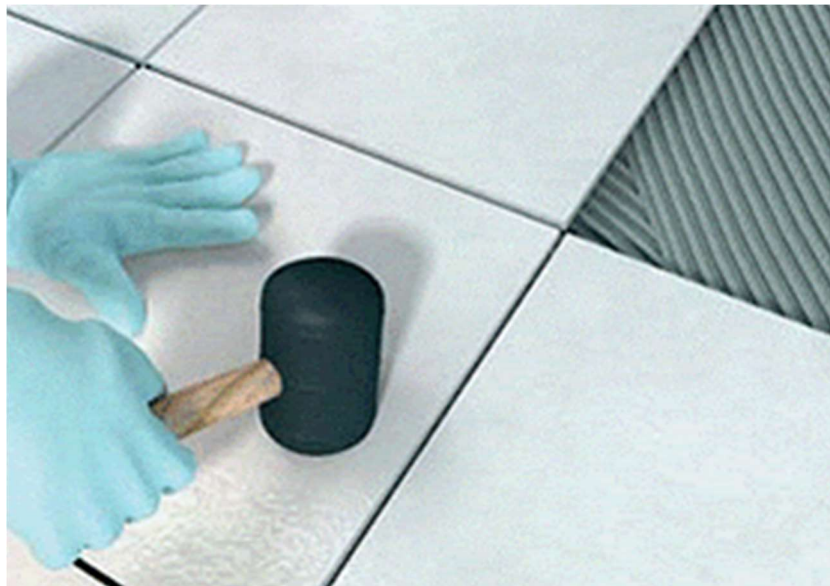
Figura 4 - Amassamento dos cordões com martelo de borracha
