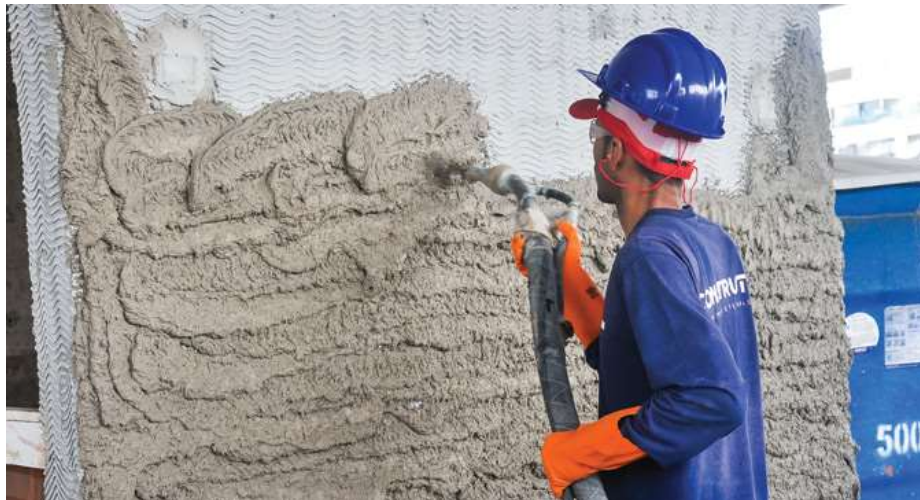
Figura 15 – Aplicação de argamassa por projetor com bomba
