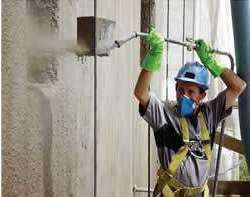
Figura 14 – Aplicação de argamassa por projetor de recipiente acoplado
