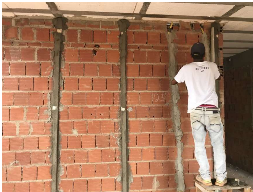
Figura 9 - Nivelamento das mestras
