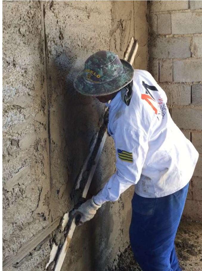
Figura 18 – Sarrafeamento da argamassa com régua “H”
