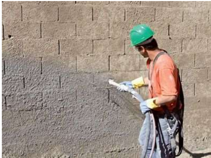
Figura 13 – Aplicação projetada do chapisco
