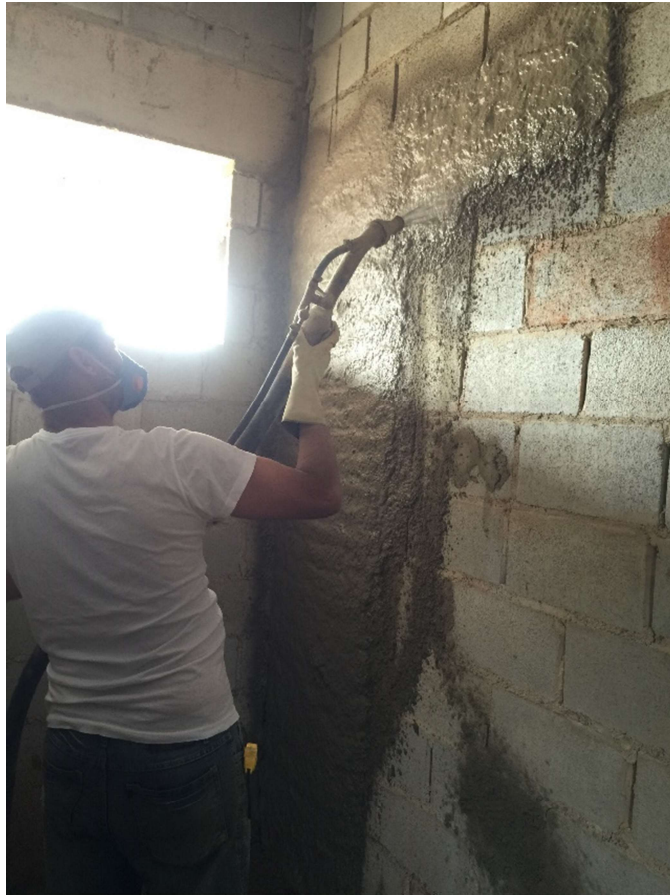
Figura 17 – Projeção da argamassa
