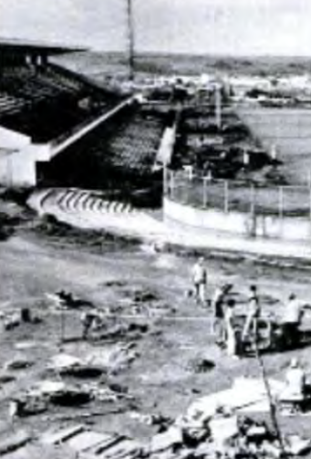
Em ritmo frenético, Anápolis trabalha 24 horas por dia para concluir o estádio.
