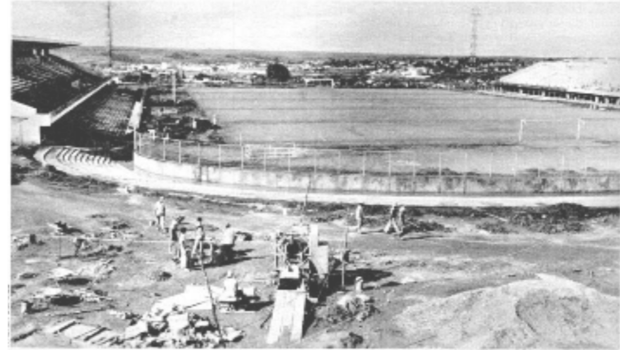
Em ritmo frenético, Anápolis trabalha 24 horas por dia para concluir o estádio.
