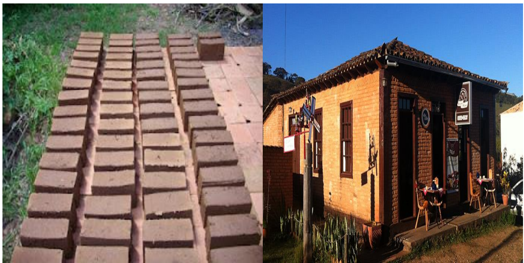
Figura 4 - Confeção e posterior construção realizada em adobe
