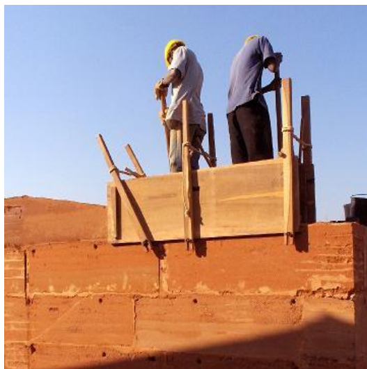
Figura 5 - Técnica de construção denominada Taipa de Pilão
