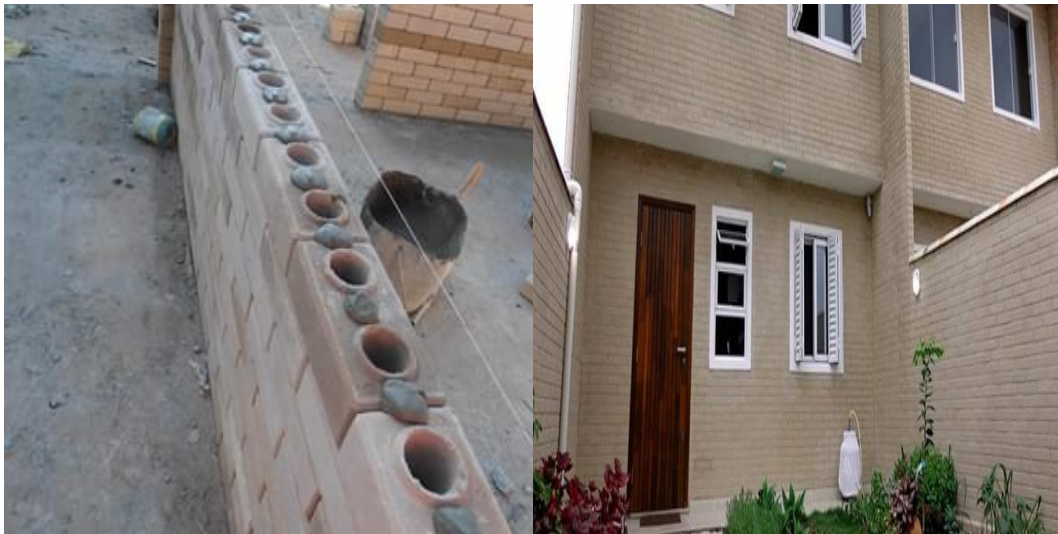
Figura 6 - Metodologia construtiva baseada em tijolos de terra compactada
