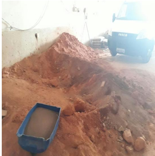
Figura 7 - Solo empregado na manufatura dos tijolos
