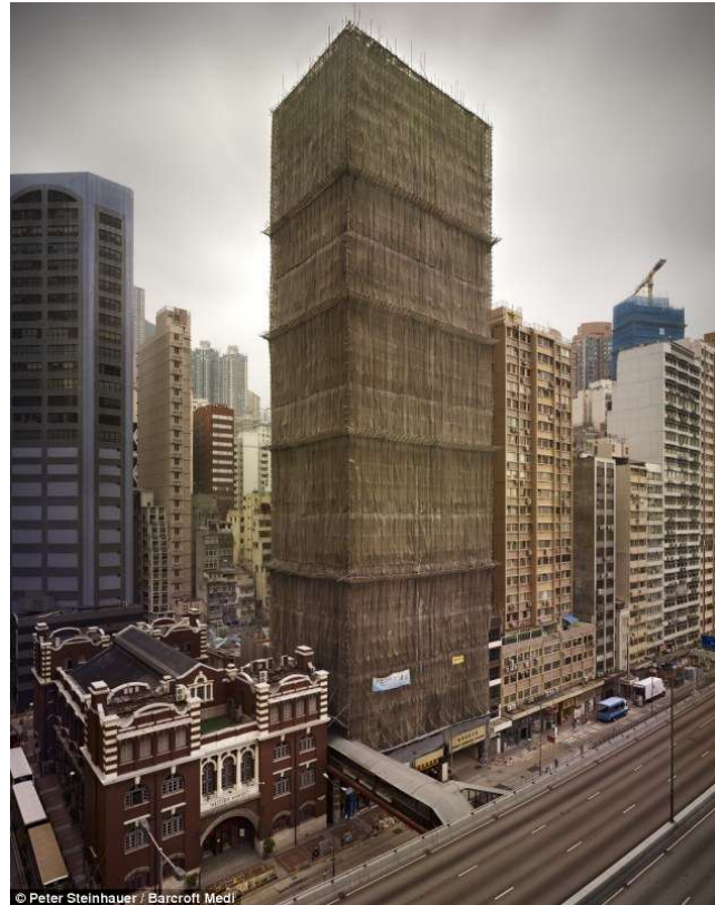
Figura 6 - Utilização do bambu em andaime em arranha-céu em Hong Kong
