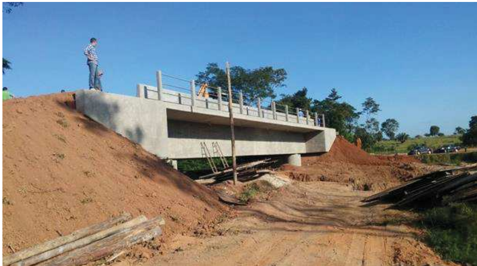
Figura 8 - Ponte de concreto.
