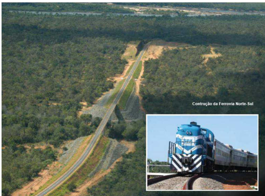
Figura 20 - Construção da ferrovia Norte - Sul.
