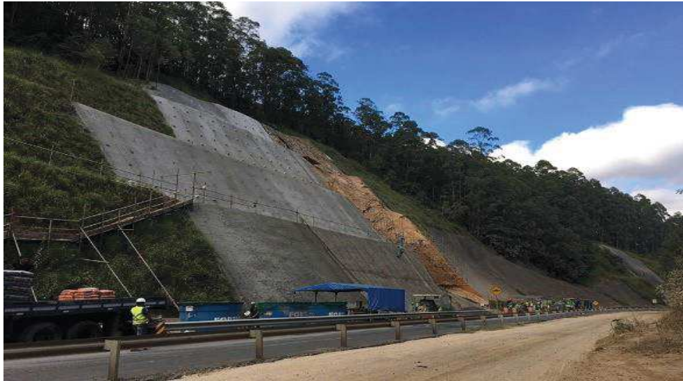
Figura 15 - Contenção de deslizamento de terra.
