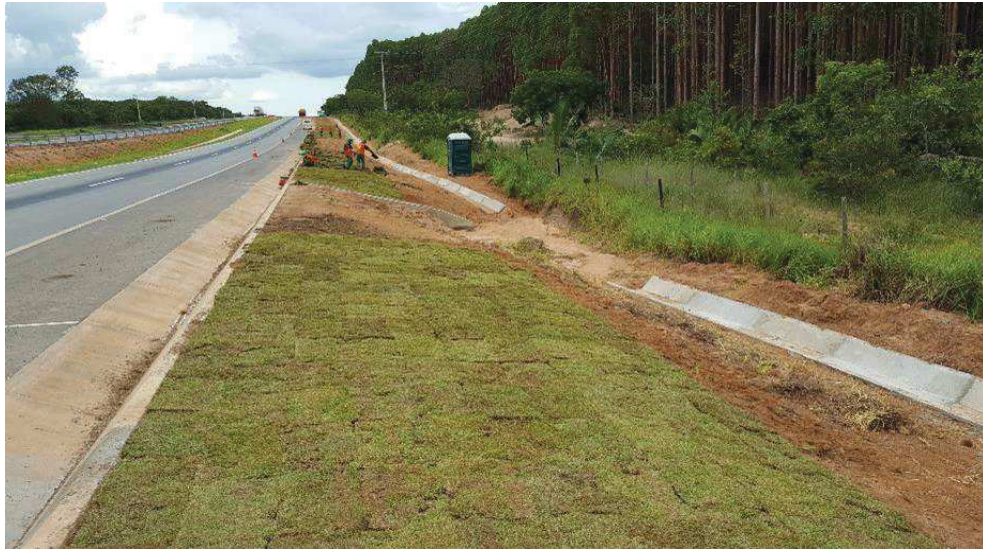
Figura 9 - Drenagem nas rodovias.
