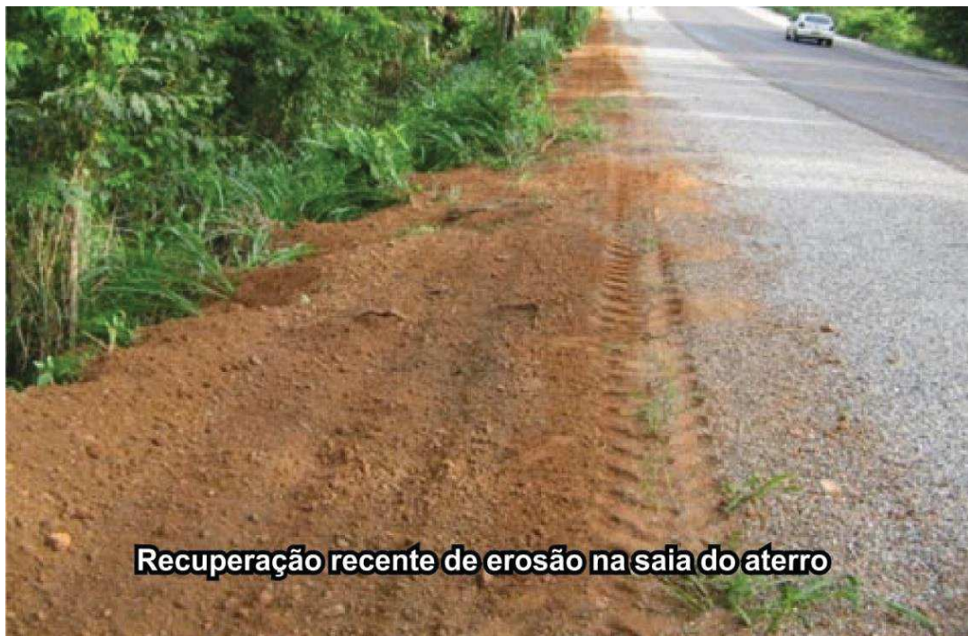
Figura 32 - Recuperação recente de erosão.
