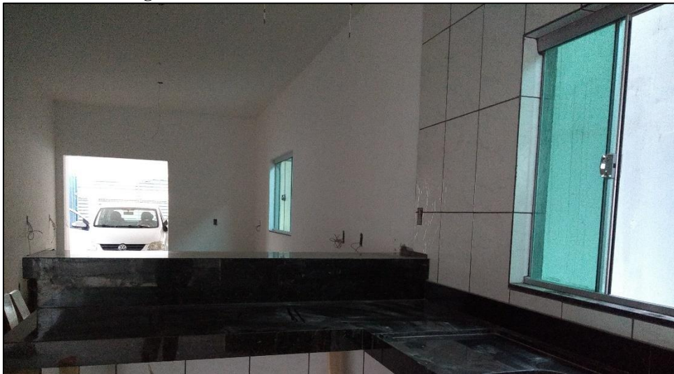
Figura 41 - Acabamento interno de uma obra em EPS
