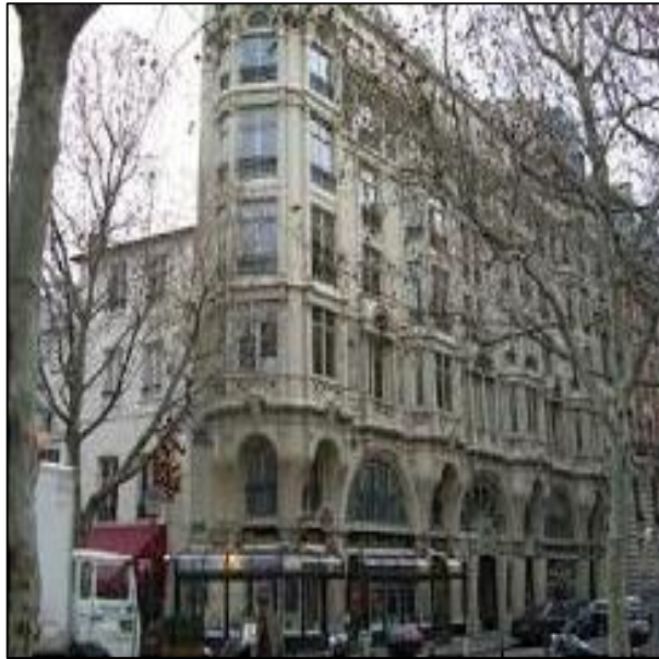
Figura 7 - Primeiro prédio em concreto armado, construído por François Hennebique
