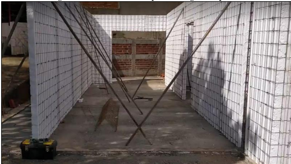
Figura 35 - Escoras utilizadas para montagem dos painéis
