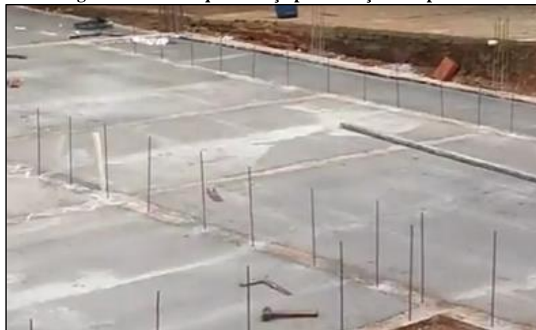
Figura 34 - Arranques de aço para fixação das paredes
