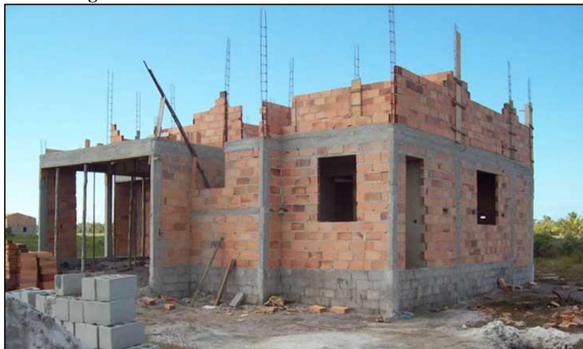
Figura 5 - Método construtivo de alvenaria convencional
