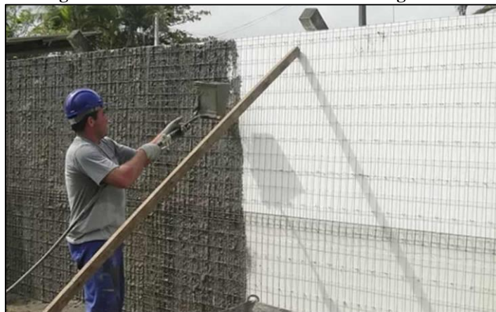
Figura 39 - Processo de revestimento com argamassa
