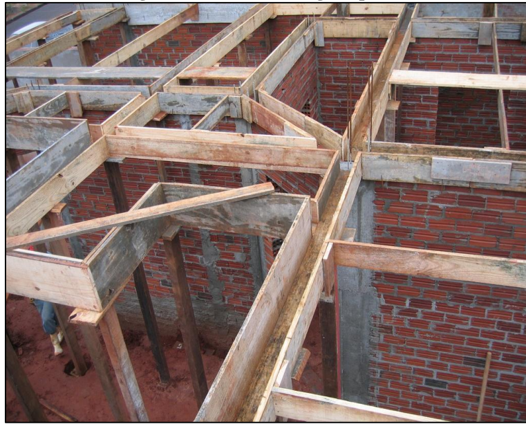
Figura 14 - Fôrmas de vigas e pilares
