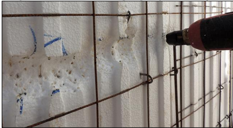
Figura 36 - Processo de abertura para passagem de tubulações
