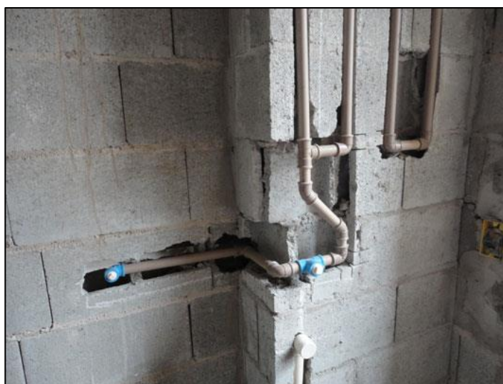
Figura 28 - Representação de shaft no plano da alvenaria.
