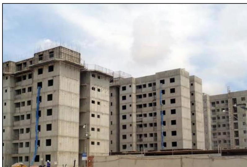
Figura 1 - Edifícios construído pelo método construtivo parede de concreto.
