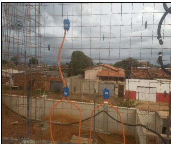
Figura 6 – Espaçadores de tela e eletrodutos fixos na malha.
