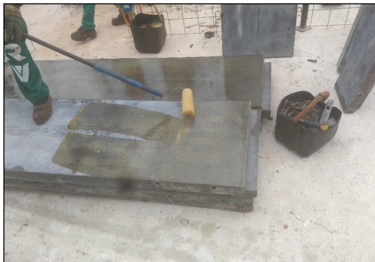
Figura 9 – Aplicação do desmoldante nas placas.
