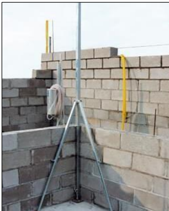
Figura 21 - Modelo de escantilhão de canto graduado.
