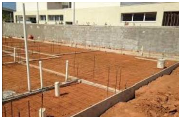
Figura 16 – Terreno preparado para início da estrutura.
