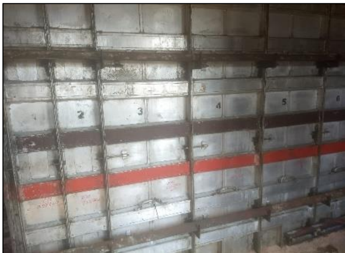
Figura 8 – Placas numeradas para facilitar montagem.
