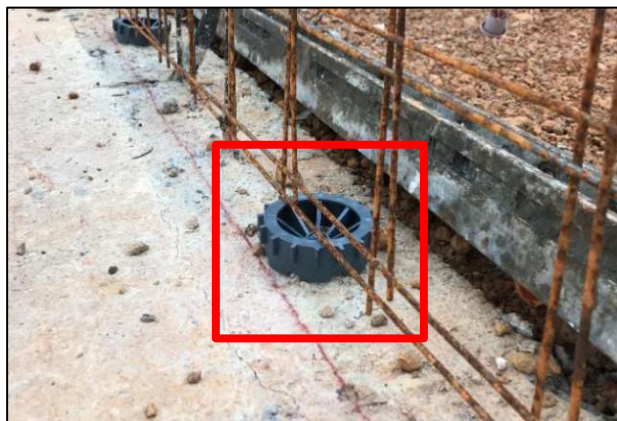
Figura 3 – Colocação dos distanciadores e marcação.
