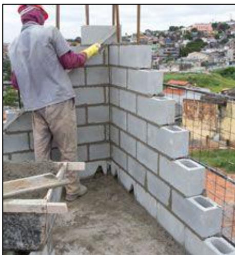
Figura 27 - Assentamento pelos cantos, tipo “castelo”.
