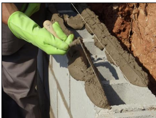
Figura 19 - Aplicação de argamassa com colher de pedreiro
