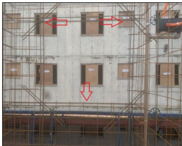
Figura 4 – Tela soldada e reforços de janela.
