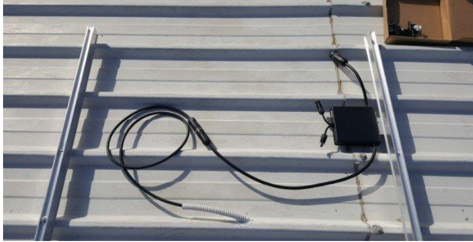
Figura 35 - Montagem dos trilhos de alumínio
