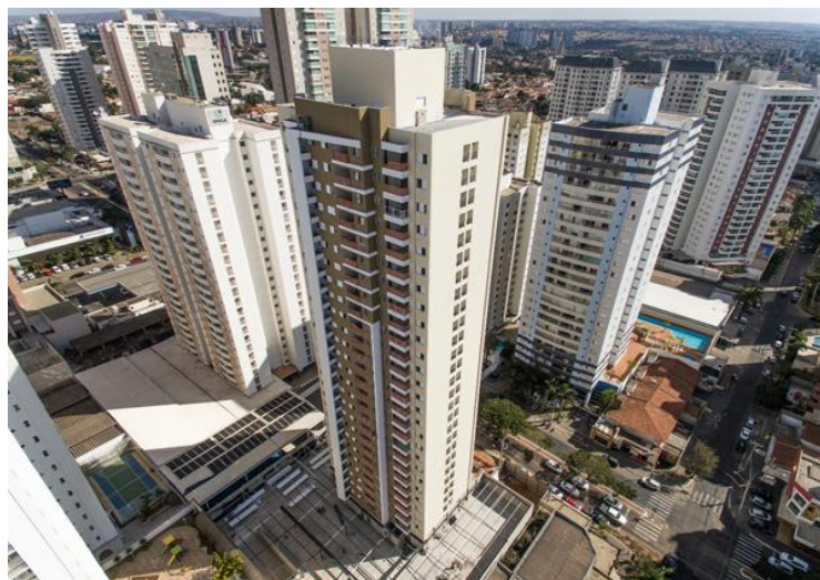
Figura 19 - Cobertura do Edifício
