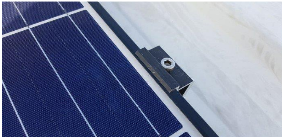
Figura 36 - Fixação dos painéis a estrutura.
