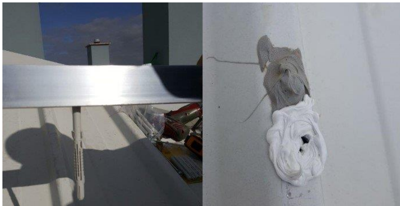
Figura 34 - Fixação dos suportes e impermeabilização do furo no telhado
