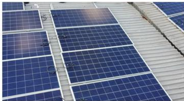
Figura 23: Telhado da associação.
