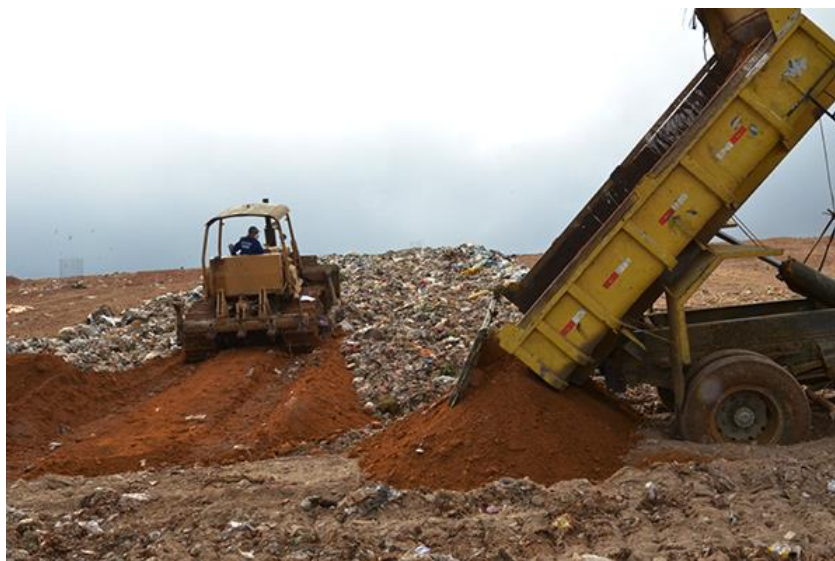
Figura 11 – Cobertura diária de terra
