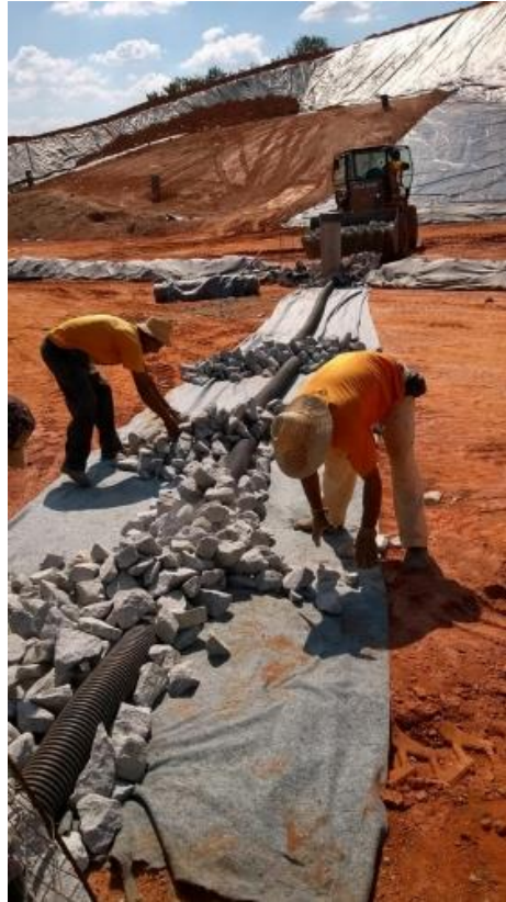
Figura 23 – Modelo de drenos de lixiviados
