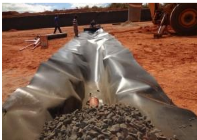
Figura 9 – Execução de drenos
