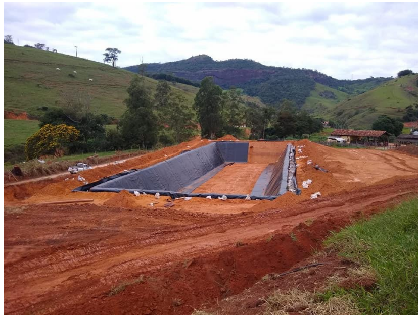
Figura 22 – Exemplo de ancoragem da manta
