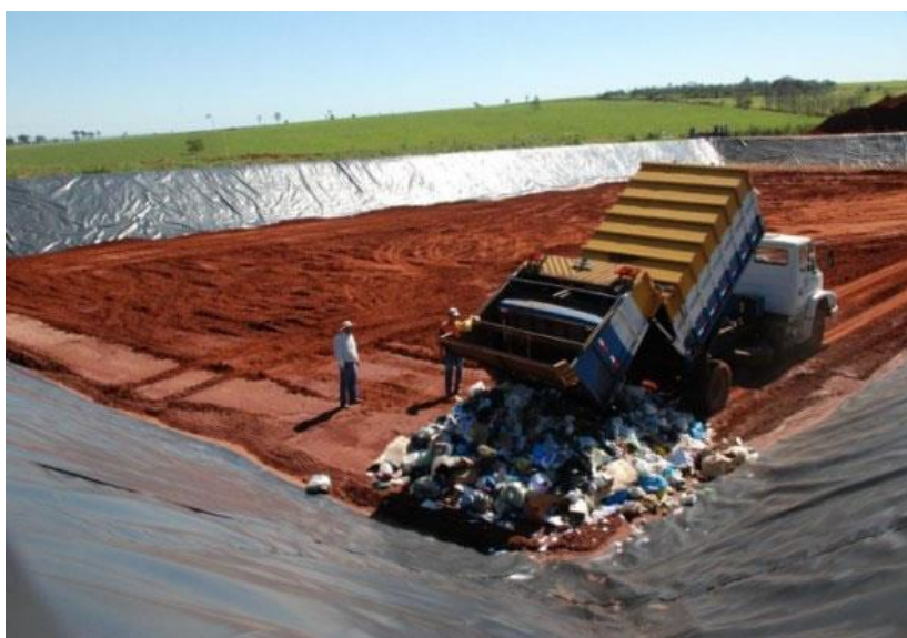
Figura 7 – Início de utilização de aterro sanitário de pequeno porte
