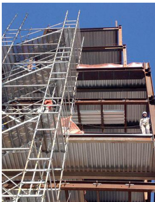
Figura 16 - Steel deck em edifício de múltiplos andares
