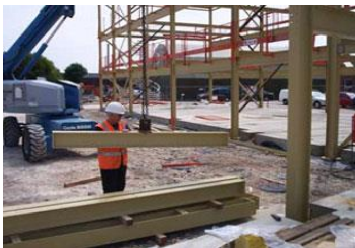
Figura 4 - Técnica de içamento ideal pelo centro de gravidade da peça.
