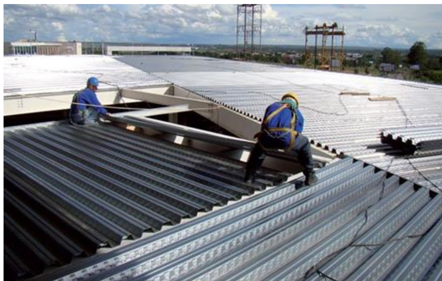
Figura 18 - Painéis posicionados e alinhados
