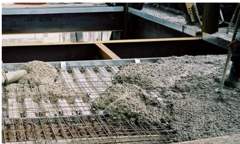
Figura 22 - Concretagem da laje
