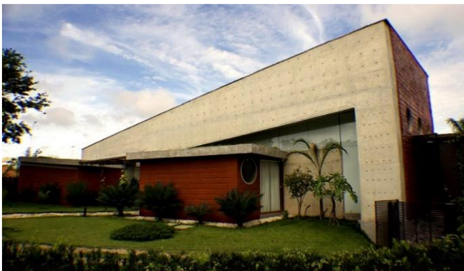
Figura 1 – Casa com medidas sustentáveis em Goiânia-GO
