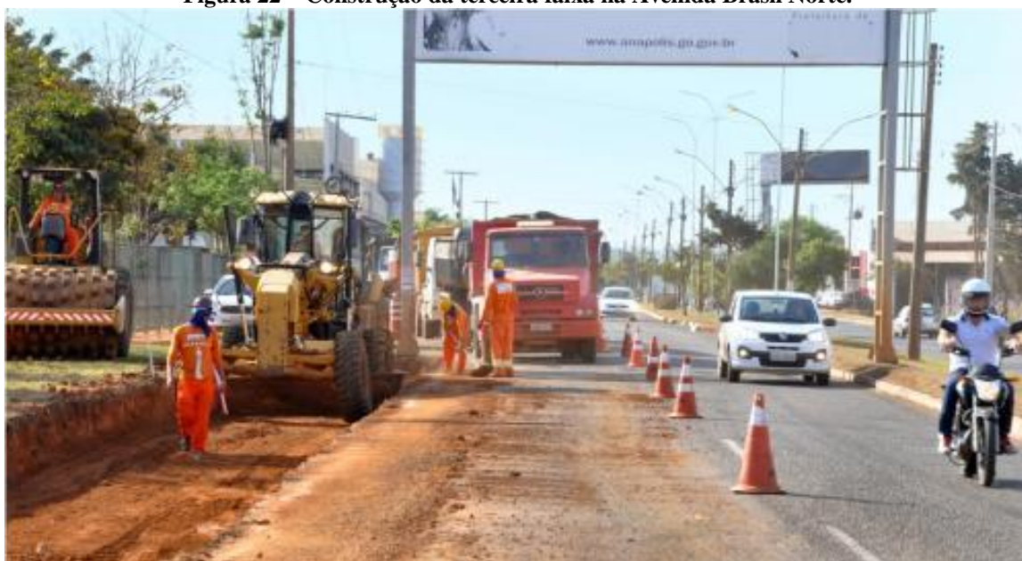
Figura 22 – Construção da terceira faixa na Avenida Brasil Norte.
