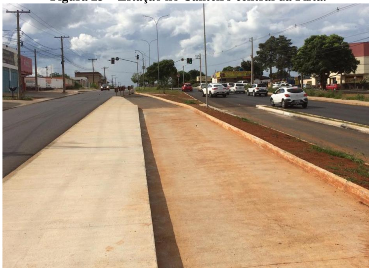
Figura 23 – Estação no Canteiro central da Pista.
