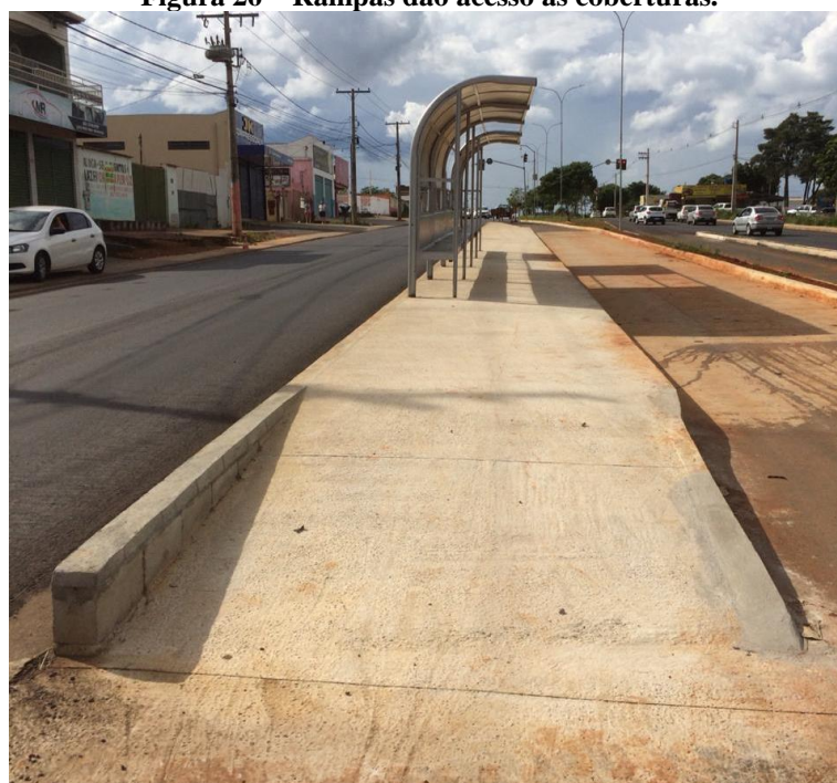
Figura 26 – Rampas dão acesso às coberturas.
