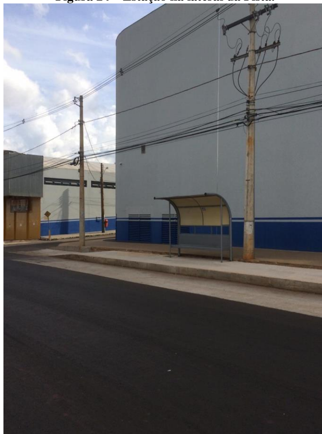
Figura 24 – Estação na lateral da Pista.
