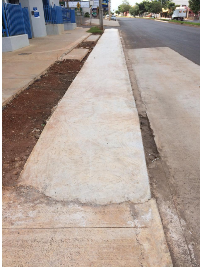
Figura 34 – Revitalização das calçadas.
