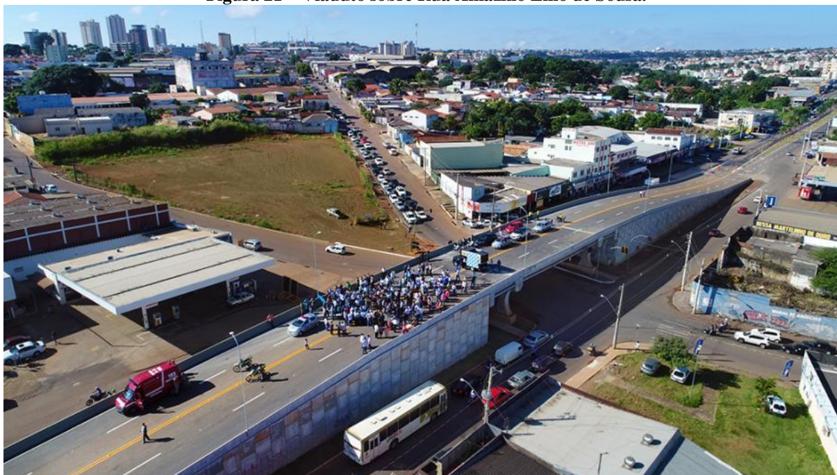
Figura 21 – Viaduto sobre Rua Amazílio Lino de Sousa.
