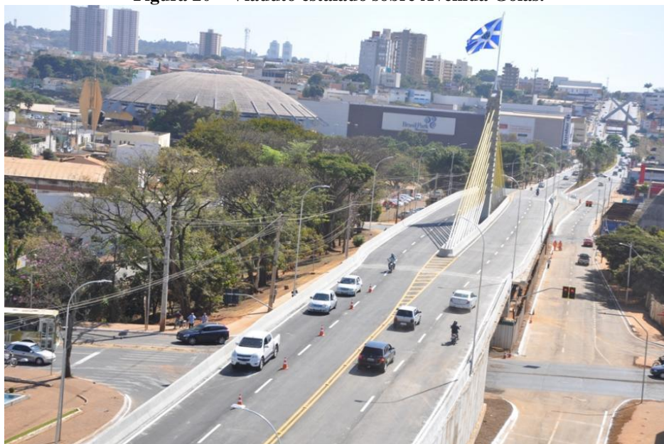
Figura 20 – Viaduto estaiado sobre Avenida Goiás.
