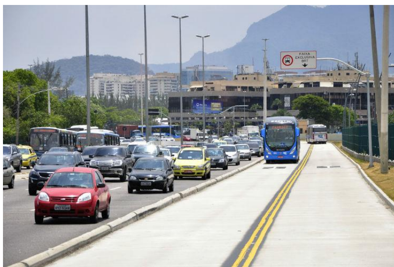
Figura 6 – Segregação de faixas no BRT
