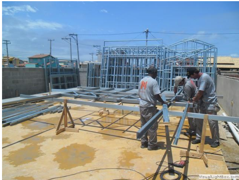
Figura 8 - Montagem do LSF no canteiro da obra
