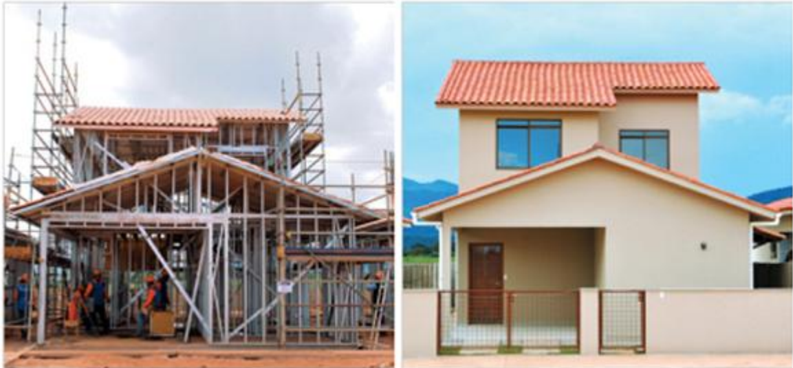
Figura 3 - Casa construída em LSF
