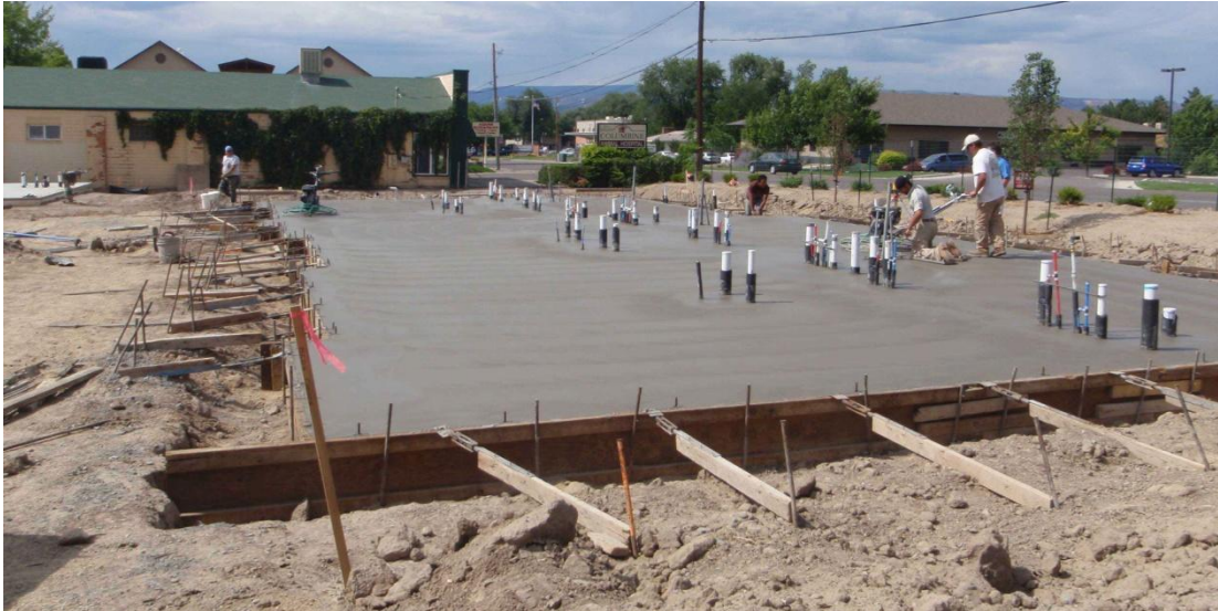
Figura 5 - Fundação tipo radier
