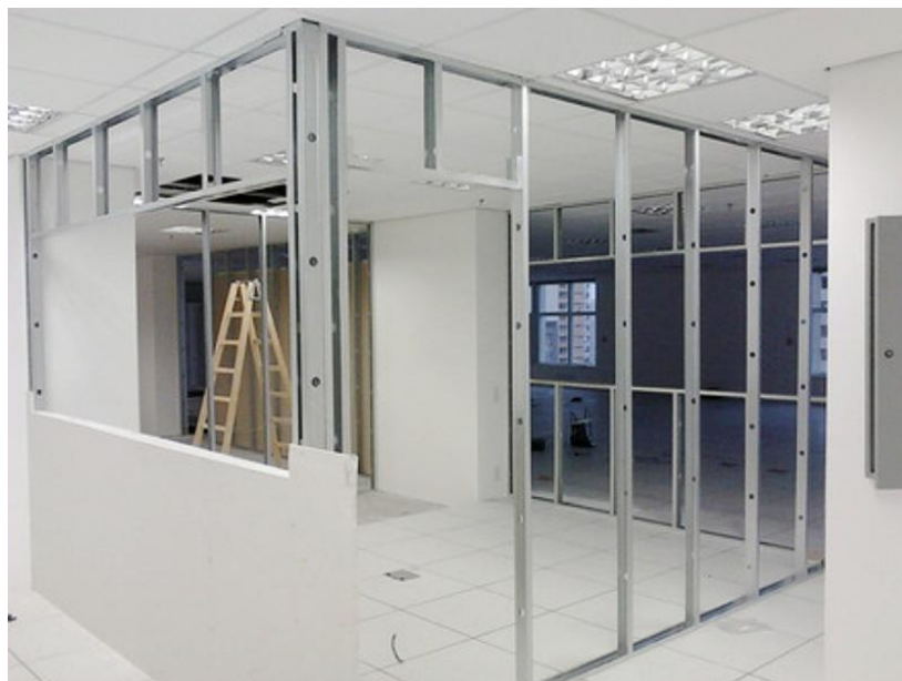
Figura 19 - Painel não estrutural
