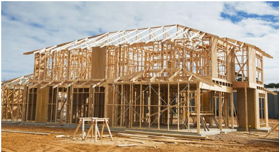
Figura 2 - Estrutura de uma edificação em Wood Frame
