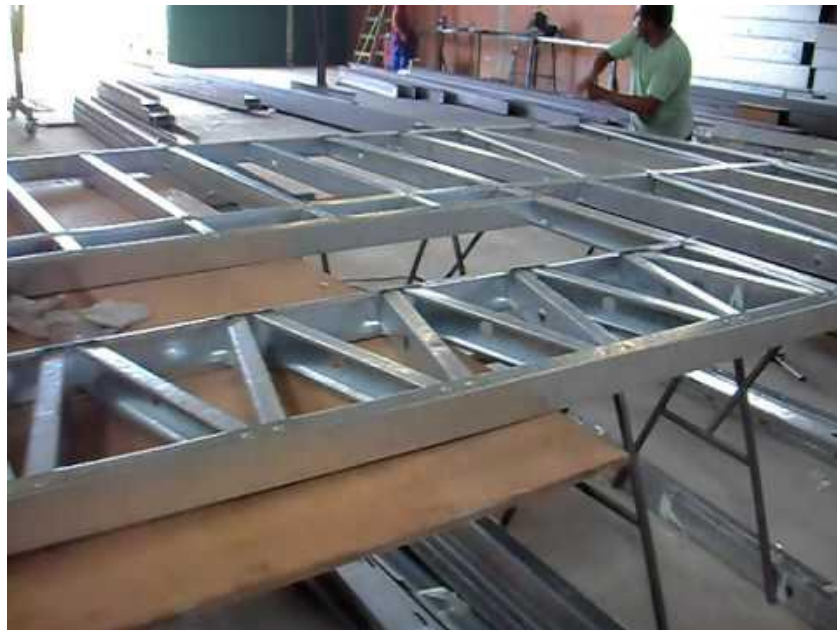
Figura 9 - Montagem prévia dos painéis de LSF
