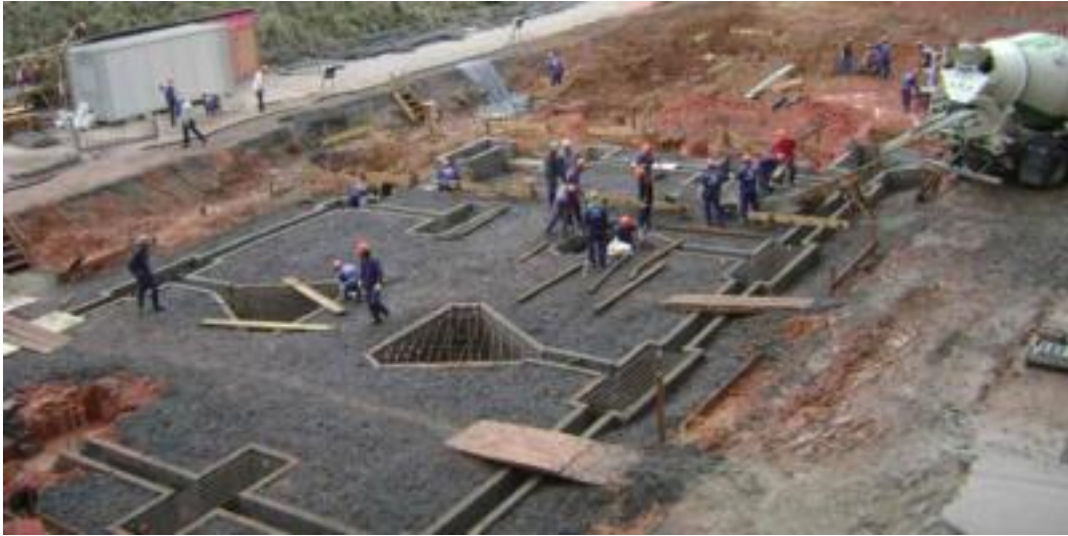
Figura 6 - Fundação tipo sapata corrida
