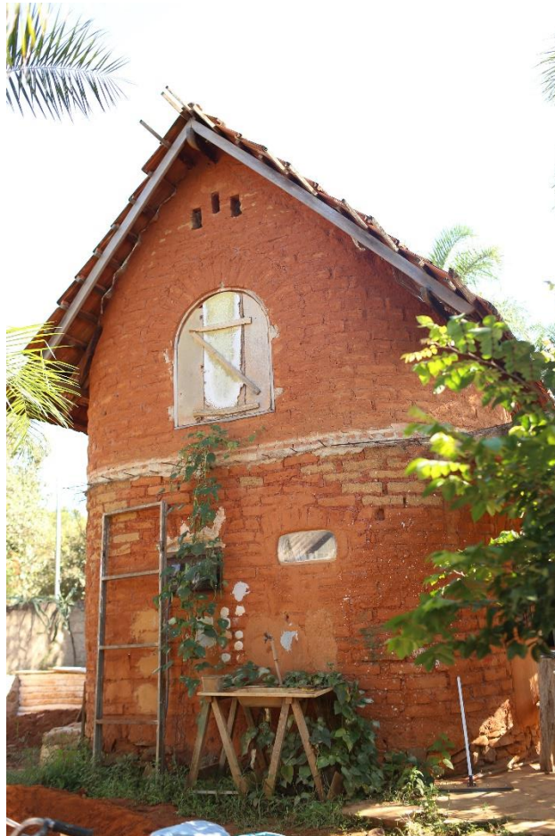
Figura 10 - Casa no Distrito de Olhos d' Água de adobe.
