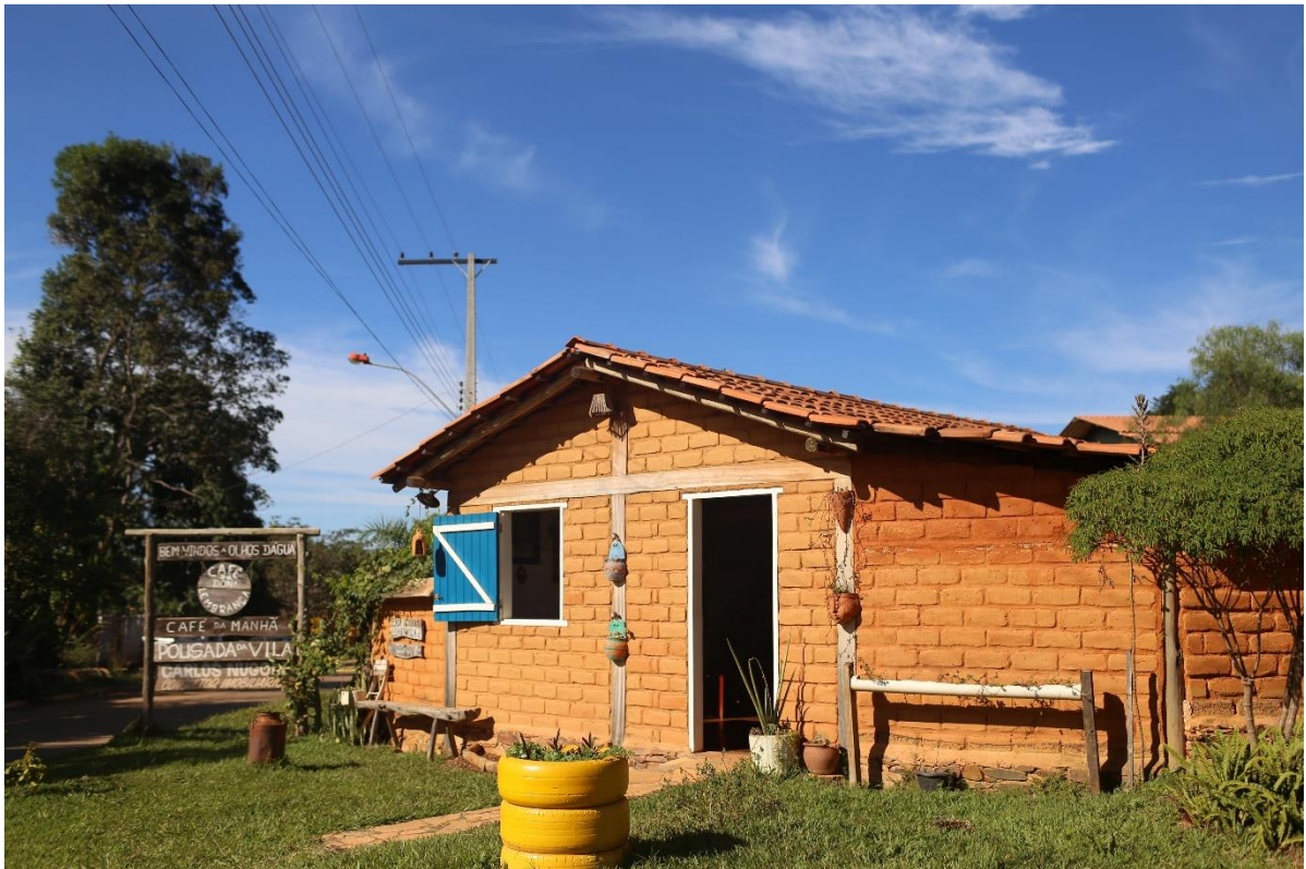
Figura 9 - Casa construída com base em adobe.
