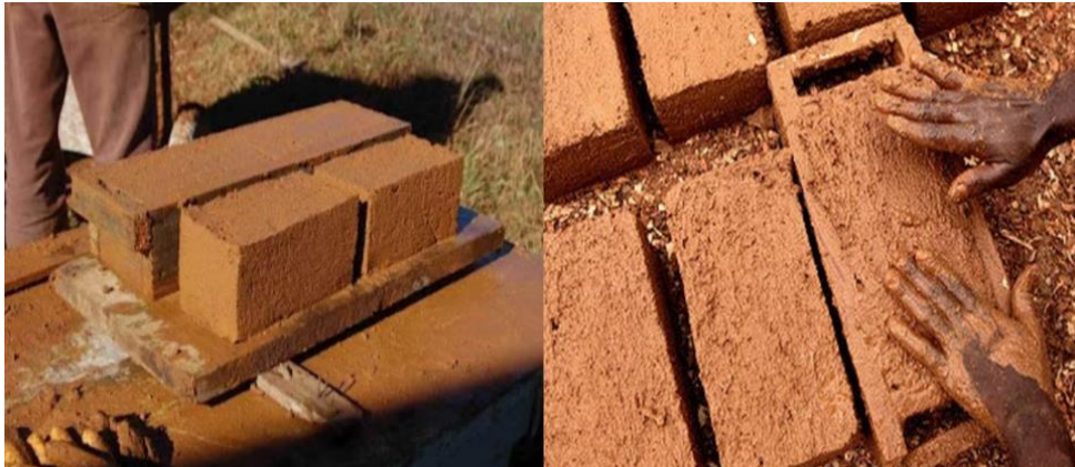
Figura 8 - Blocos de Adobe sendo moldados.
