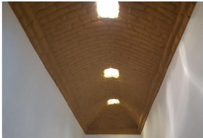
Figura 12 - Teto com iluminação natural.
