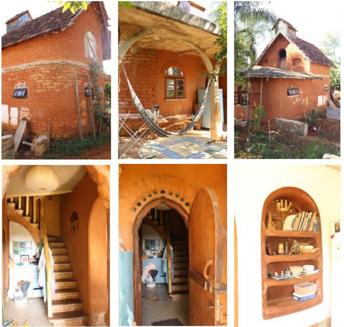
Figura 11 - Habitação construída através da Bioconstrução.
