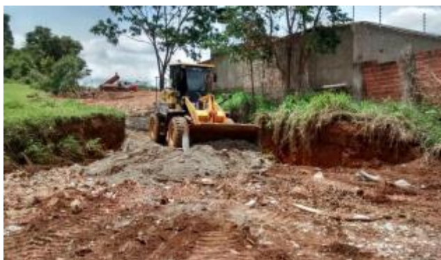
Figura 16- Retirada dos sedimentos soltos no solo.
