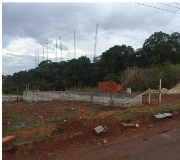
Figura 26- Construções feitas após a contenção da Erosão no Residencial Geovane Braga.
