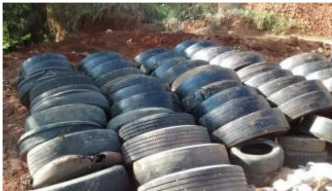
Figura 20- Utilização de pneus no auxílio a prevenção de movimento de terra.
