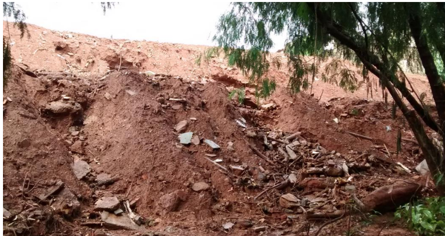
Figura 14- Foto da Erosão no Residencial Geovane Braga em 2015.
