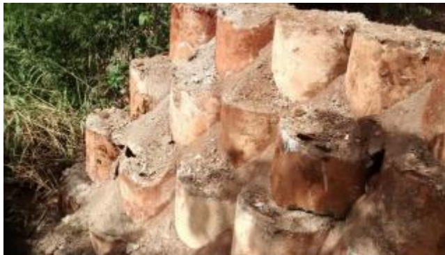
Figura 19- Construção de paliçadas com manilhas de esgoto que estavam inutilizáveis no município de Anápolis.
