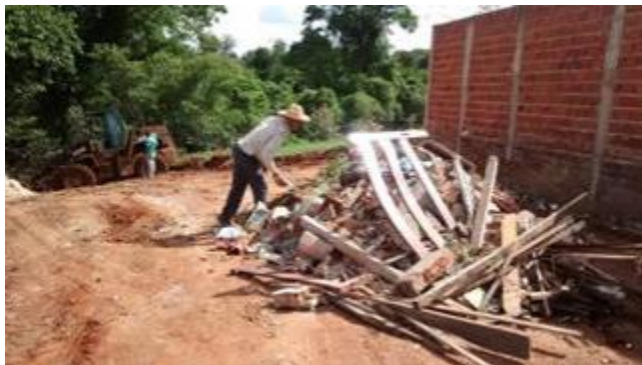
Figura 17- Retirada dos sedimentos soltos no solo.
