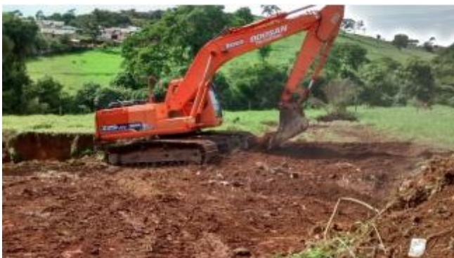
Figura 21- Utilização de maquinas para reconformação do solo.
