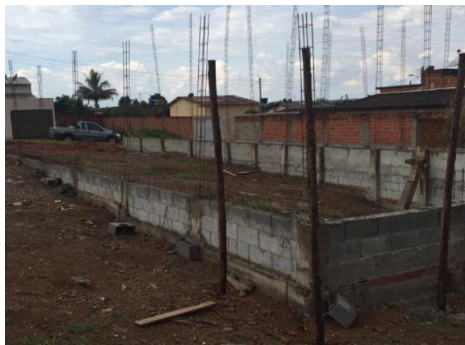
Figura 27- Construções feitas após a contenção da Erosão no Residencial Geovane Braga.
