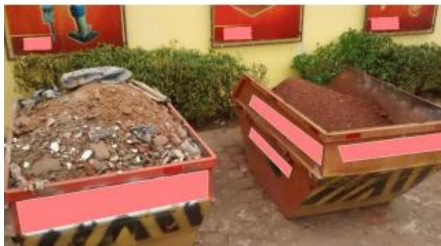
Figura 18- Retirada dos sedimentos soltos no solo.
