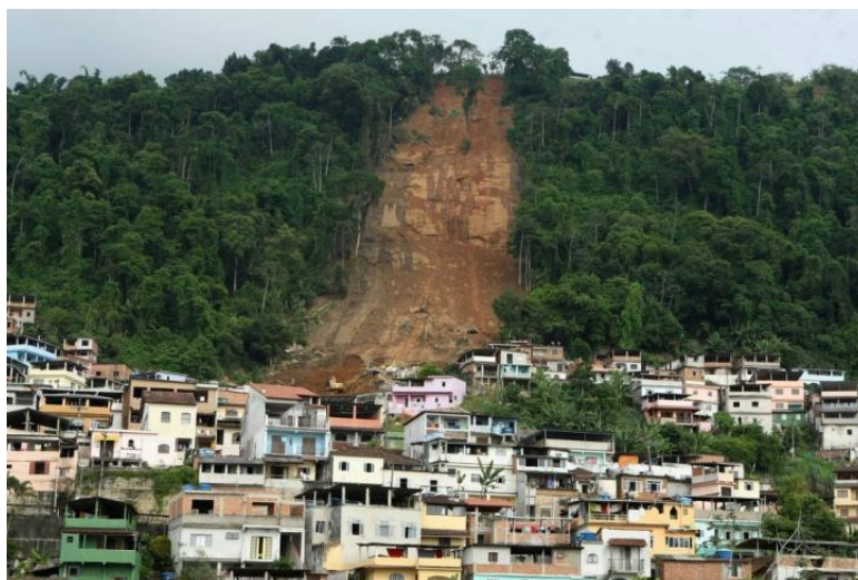
Figura 7- Foto no centro de Angra dos Reis, onde ocorreu um deslizamento em 2010.
