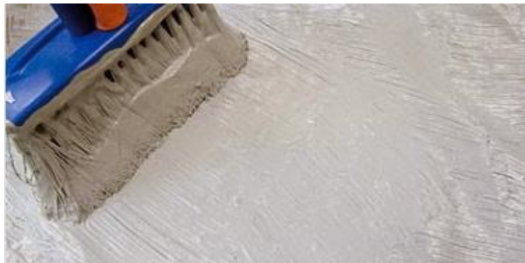
Figura 4 - Aplicação de argamassa polimérica
