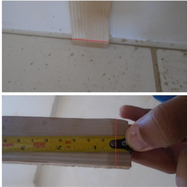
Figura 17 - Verificação da lâmina d'água
