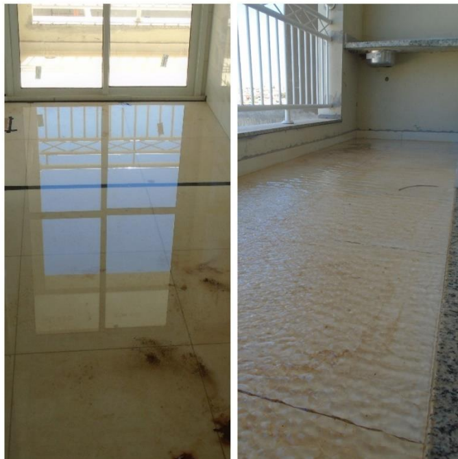
Figura 15 - Cozinha/área de serviço e varanda com lâmina d'água
