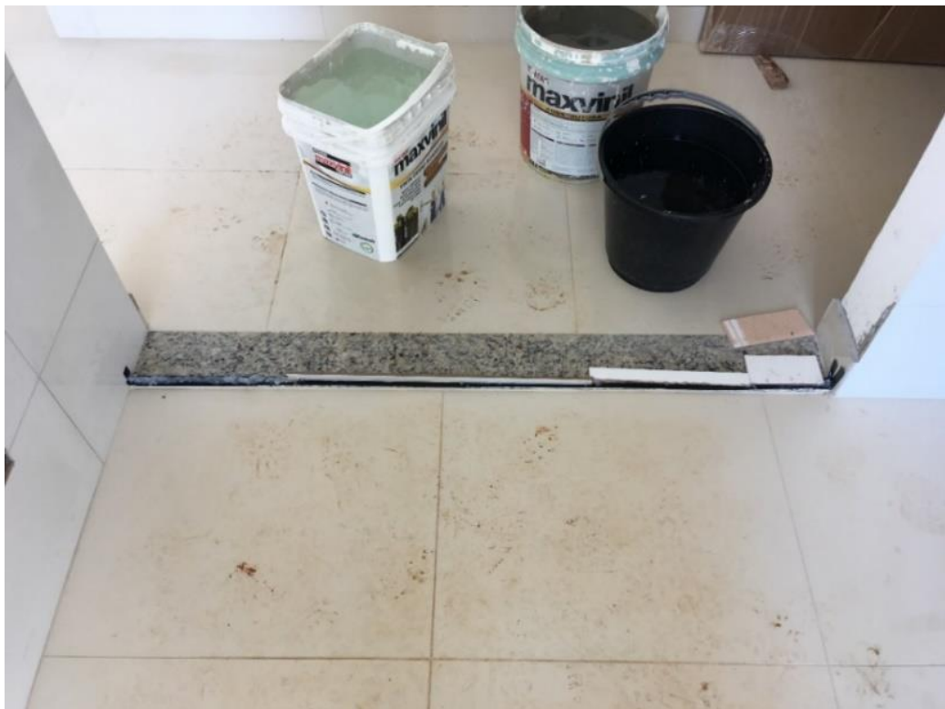
Figura 12 - Barreiras de vedação cozinha/entrada
