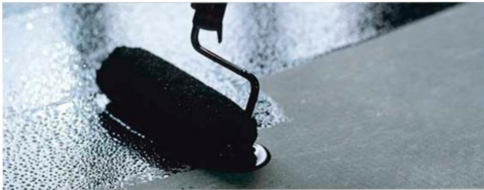
Figura 7 - Aplicação de membrana a frio
