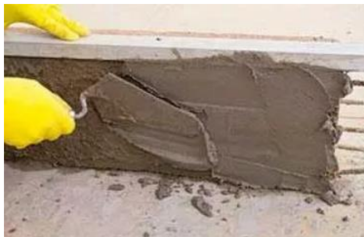
Figura 3 - Aplicação de argamassa impermeável
