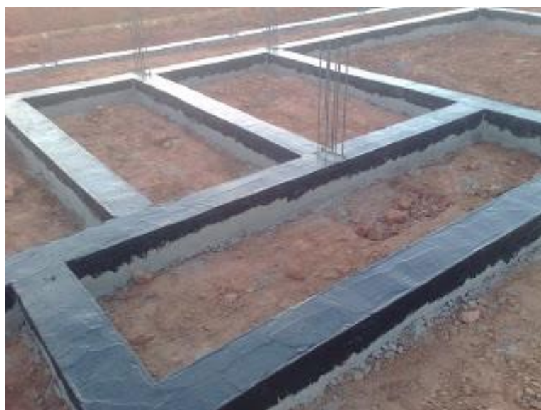
Figura 2 - Sistema de impermeabilização de fundação
