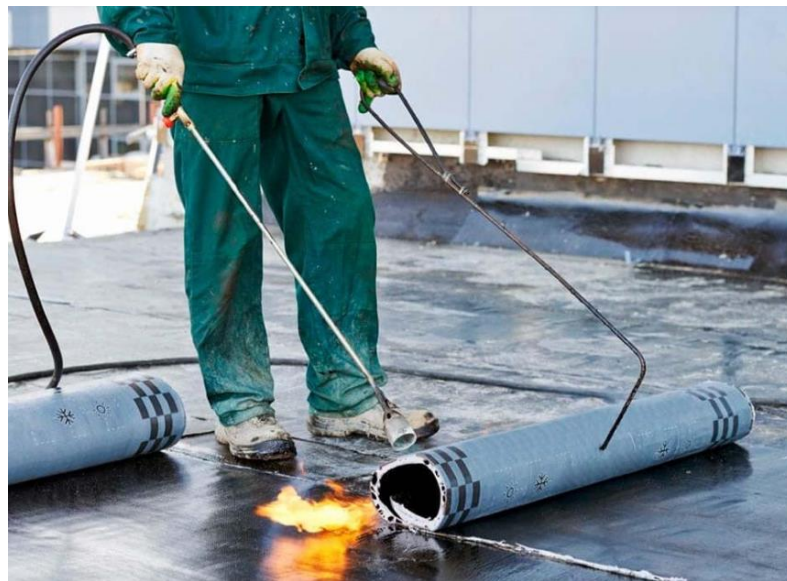
Figura 6 - Aplicação de membrana a quente
