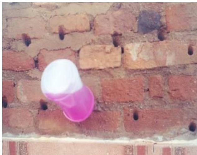
Figura 5 - Aplicação de cristalizante
