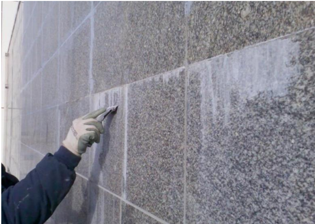
Figura 1- Eflorescência em sistemas de piso
