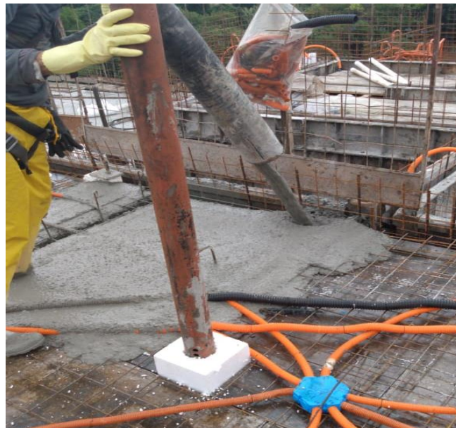
Figura 11 - Concretagem paredes de concreto
