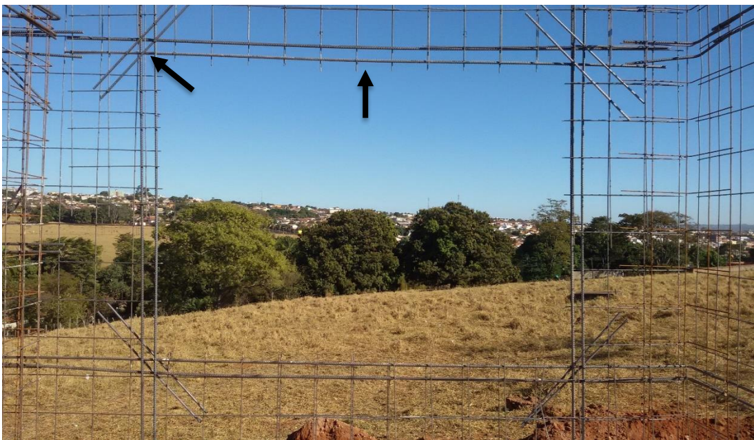
Figura 8 - Reforços estruturais
