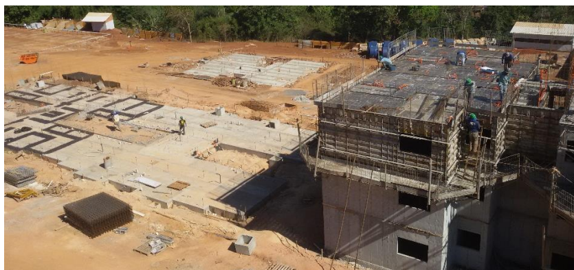
Figura 1 – Paredes de concreto
