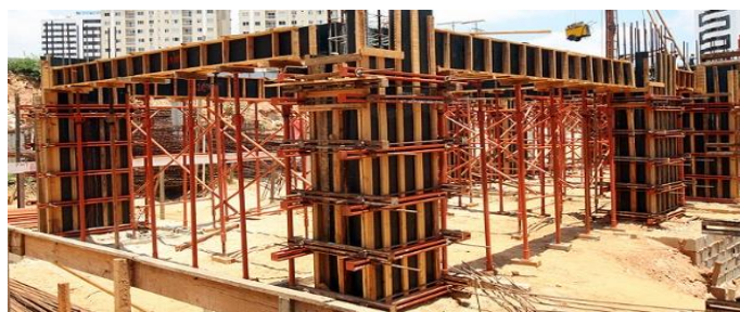
Figura 5 - Fôrmas de madeira
