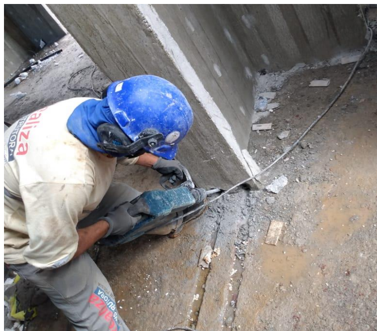
Figura 12 - Retrabalho paredes de concreto
