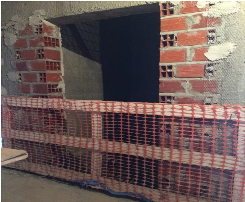
Figura 15: Sinalização de segurança 1, construtora “A”.
