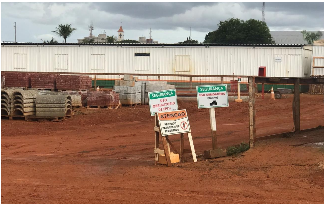
Figura 13: Sinalização de segurança 1, construtora “B”
