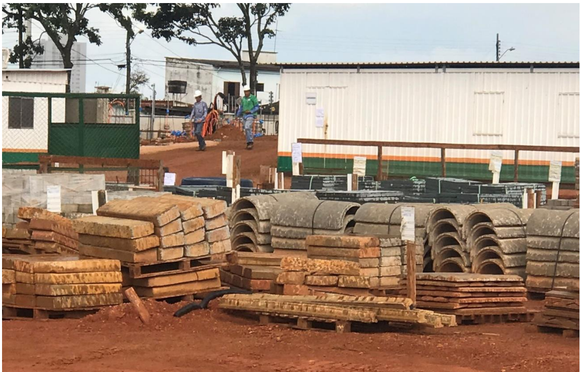
Figura 21: Separação de materiais 2, construtora “B”.
