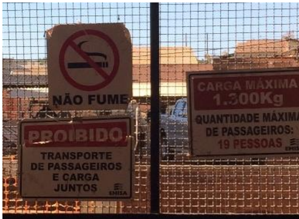
Figura 17: Sinalização de segurança em cremalheira, construtora “A”
