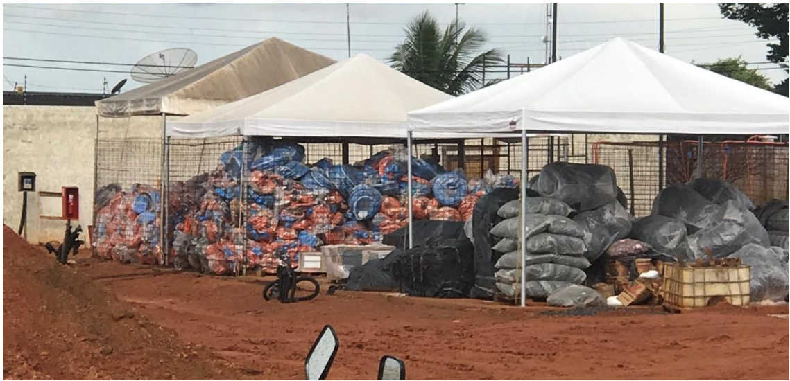
Figura 20: Separação de materiais 1, construtora “B”.
