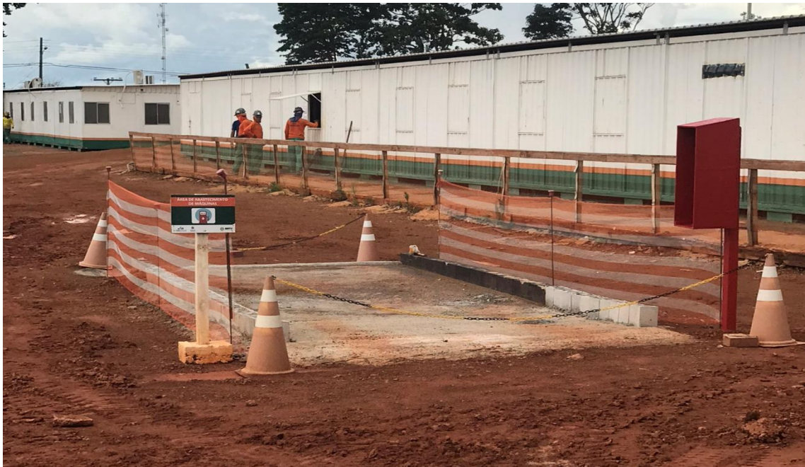
Figura 14: Sinalização de segurança 2, construtora “B”
