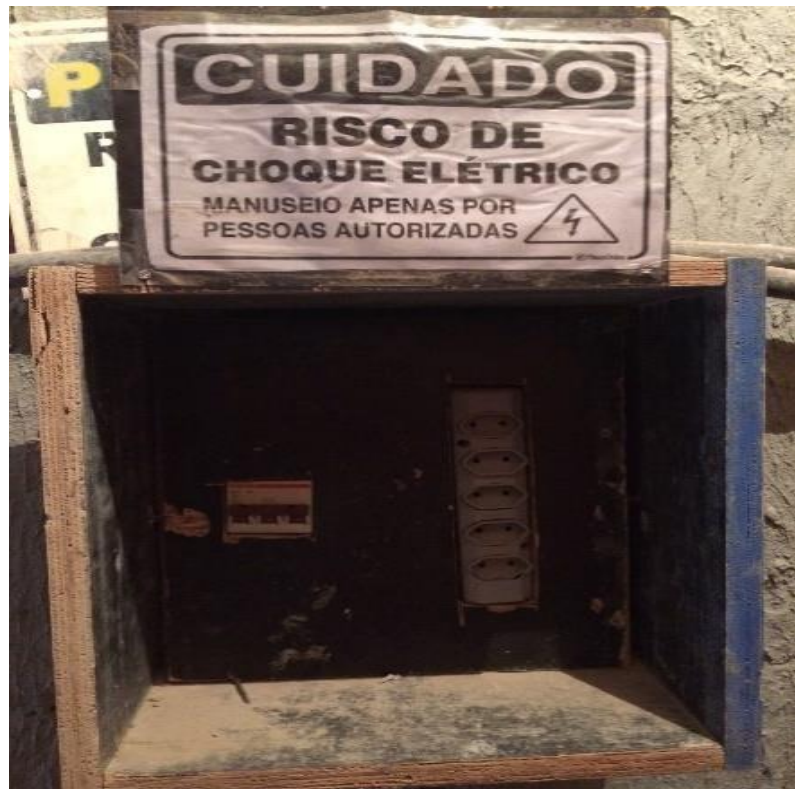
Figura 16: Sinalização de segurança 2, construtora “A”
