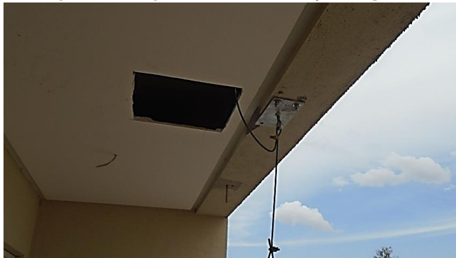
Figura 24 – Montagem do elemento de sustentação do corpo mole
