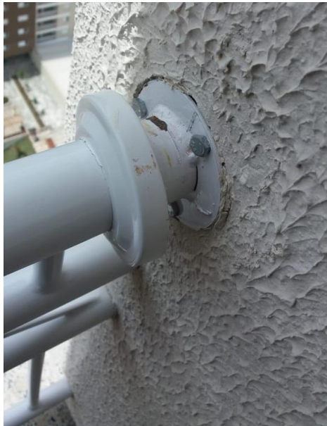
Figura 19 – Fixação dos parafusos no guarda-corpo
