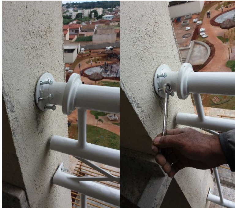
Figura 18 – Fixação do guarda-corpo
