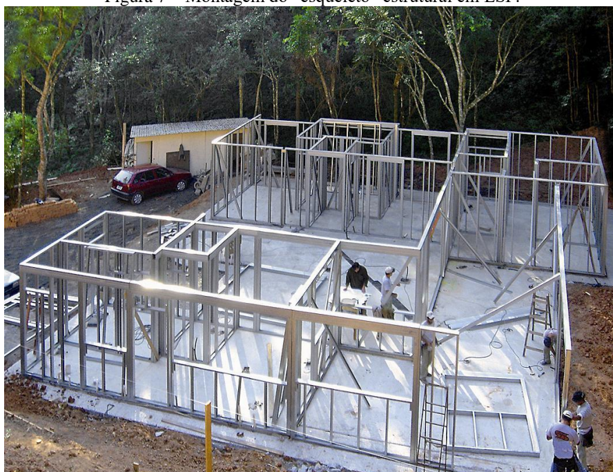
Figura 7 – Montagem do “esqueleto” estrutural em LSF.
