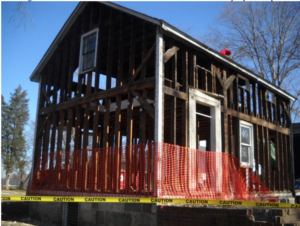
Figura 4 – Visão de toda estrutura com ótimo estado de conservação pelo tempo.
