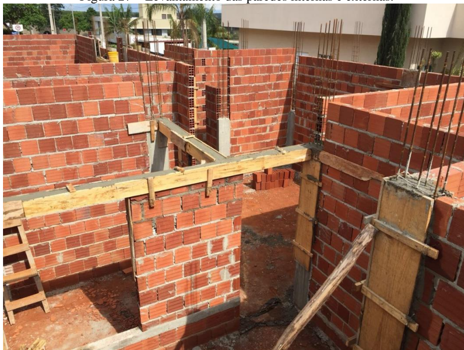
Figura 27 – Levantamento das paredes internas e externas.
