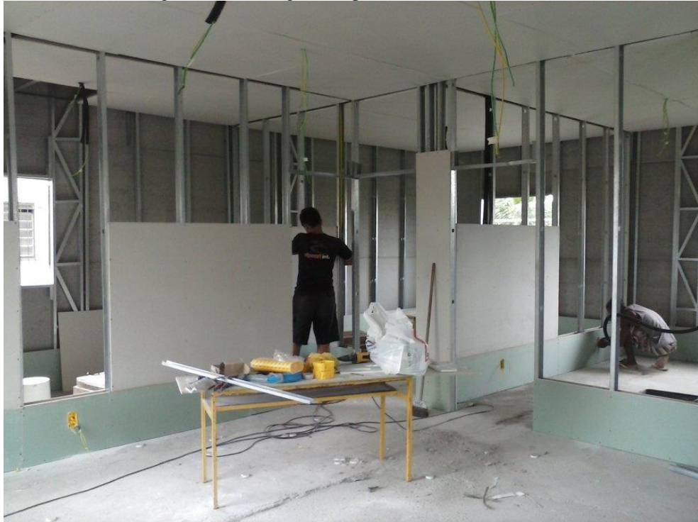
Figura 28 – Montagem das paredes internas e externas.
