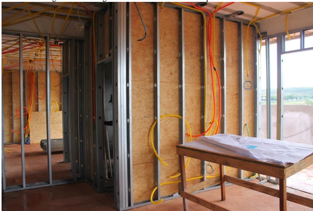
Figura 21 - Passagem dos conduítes elétricos na parede interna.
