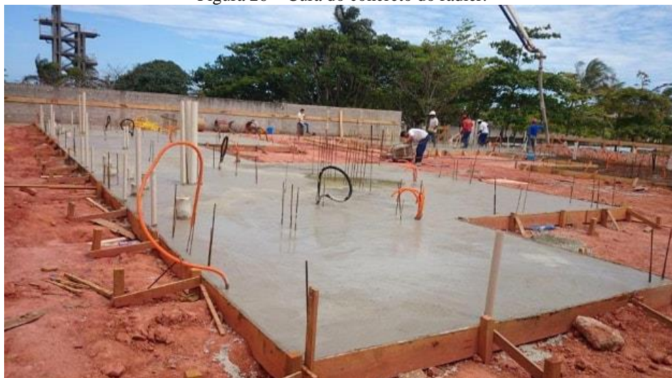
Figura 26 – Cura do concreto do radier.
