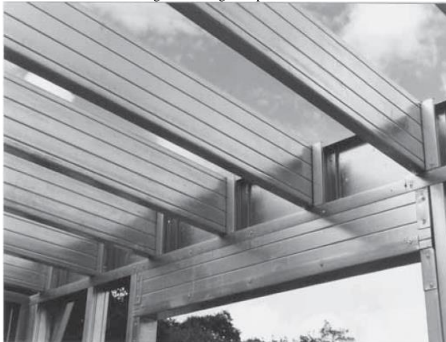
Figura 24 - Vigas de piso.
