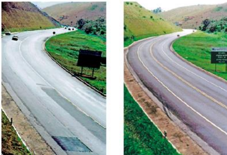
Figura 4 - Exemplo de aplicação de microrrevestimento asfáltico
