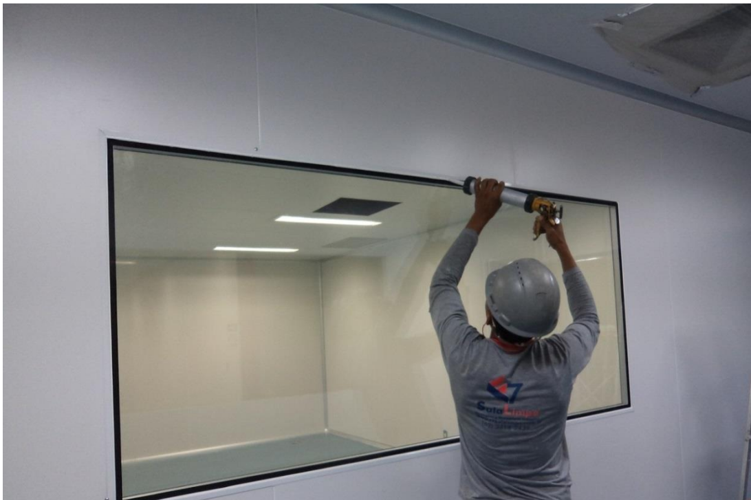
Figura 39 – Acabamento de silicone em visor
