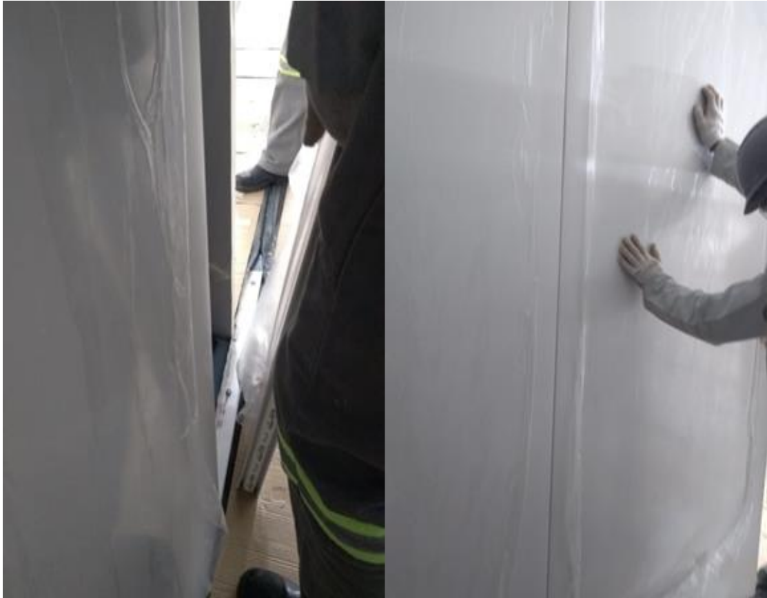
Figura 35 – Painel de divisória sendo encaixado
