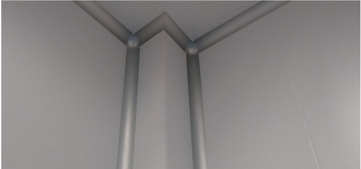
Figura 44 – Acabamento com perfil arredondado e concha arremate
