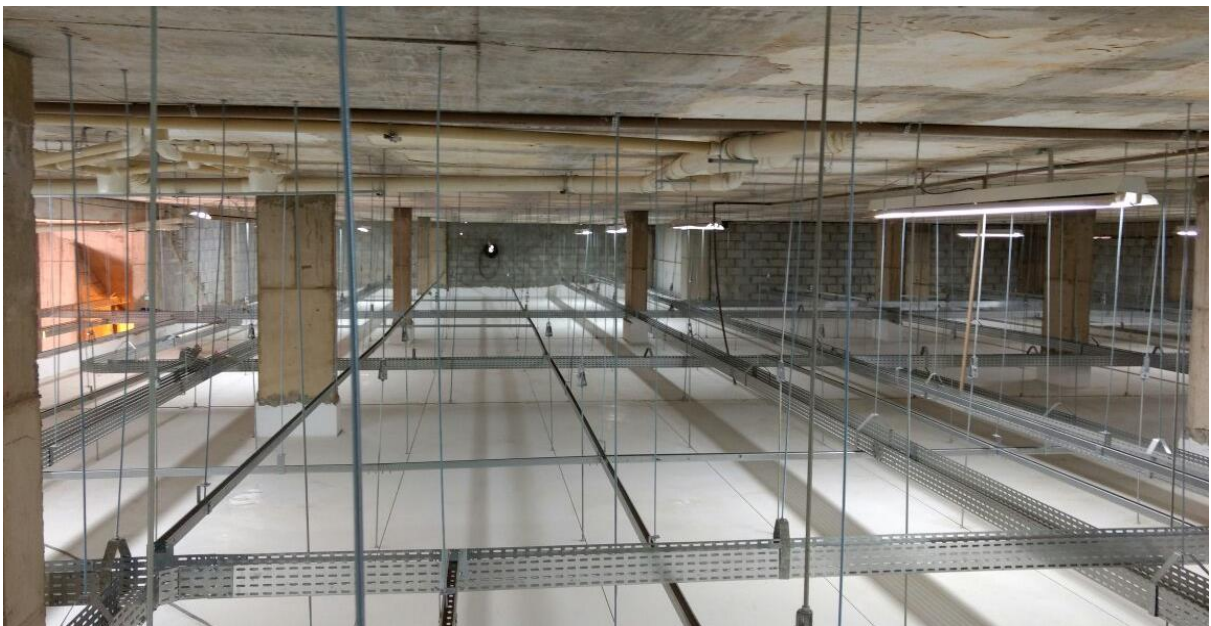
Figura 29 – Vista entre forro e laje
