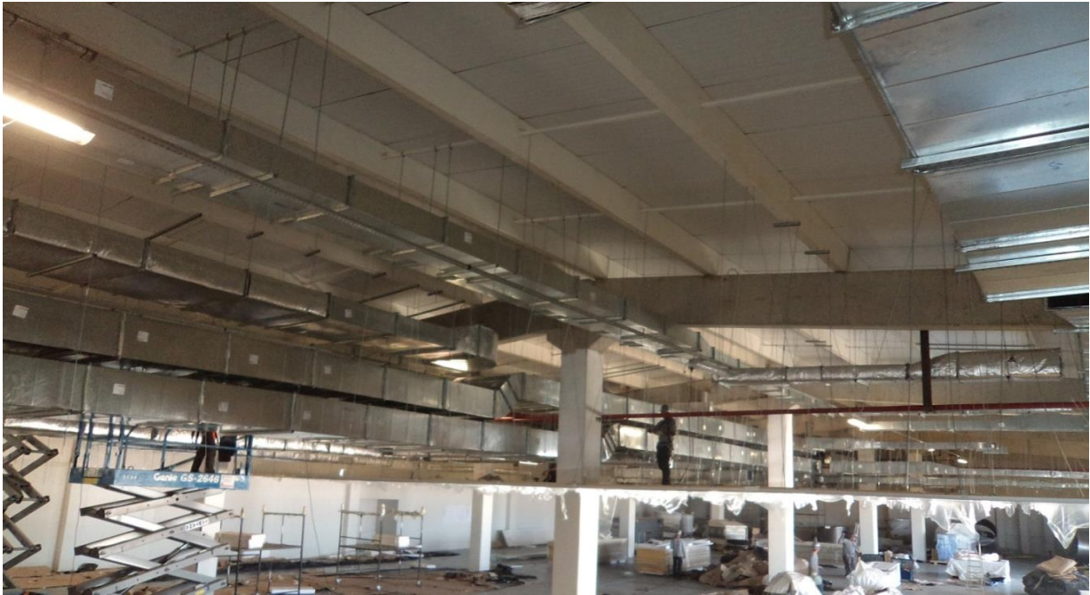
Figura 28 – Dutos de ar condicionado em fase de montagem
