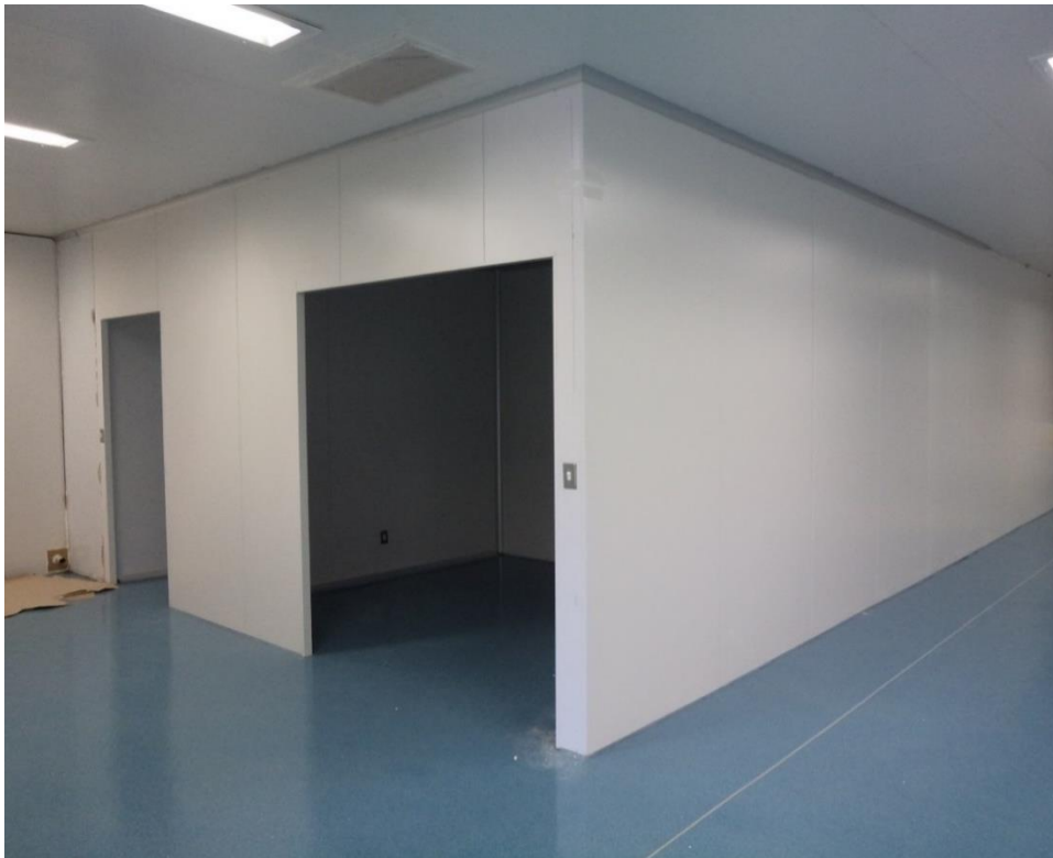
Figura 37 – Corte de vão para instalação de porta
