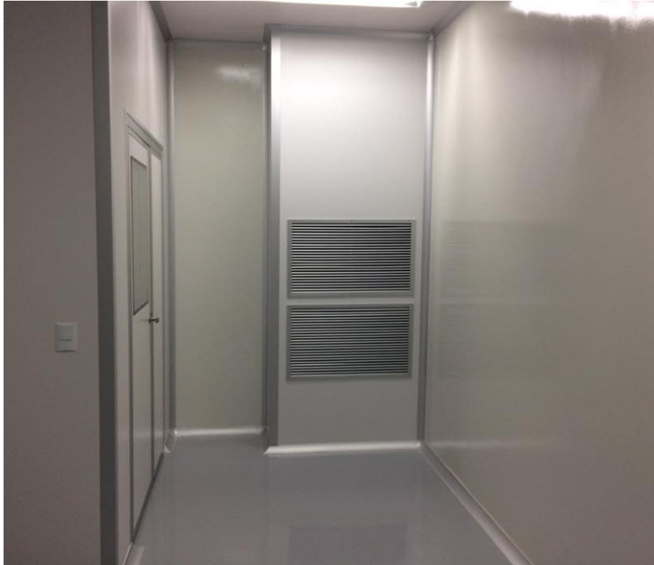
Figura 42 – Shaft de retorno de ar
