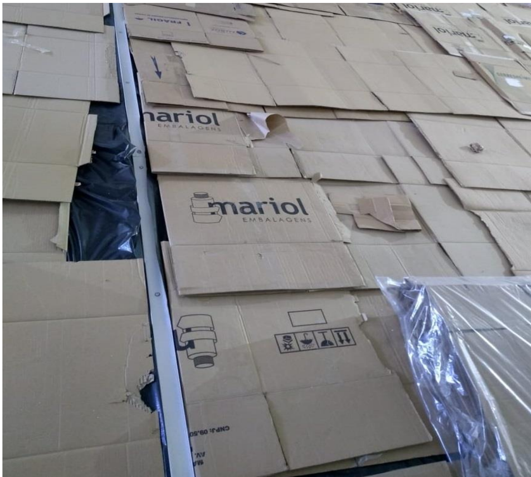
Figura 34 – Perfil guia instalado com isolamento de piso
