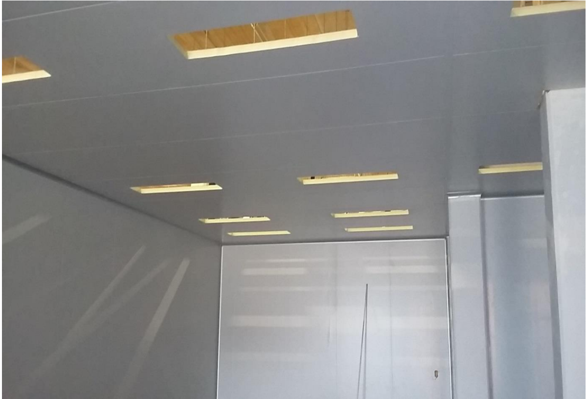
Figura 36 – Recorte de luminárias no forro
