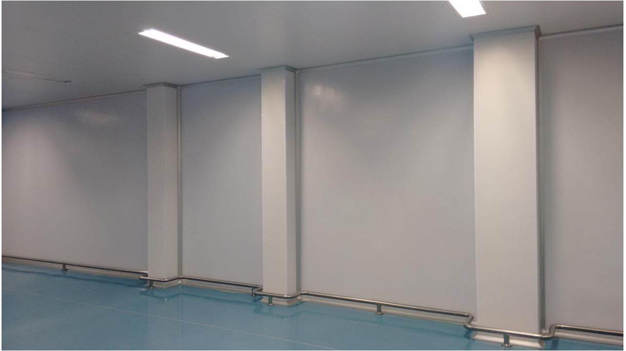
Figura 14 – Parede constituída com painéis isotérmicos
