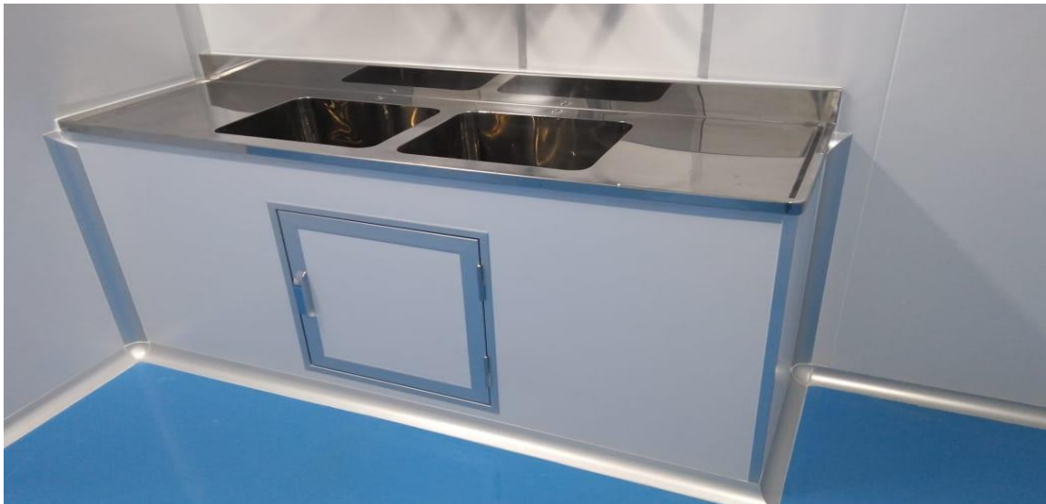
Figura 43 – Fechamento de pia com porta para manutenção de tubulação
