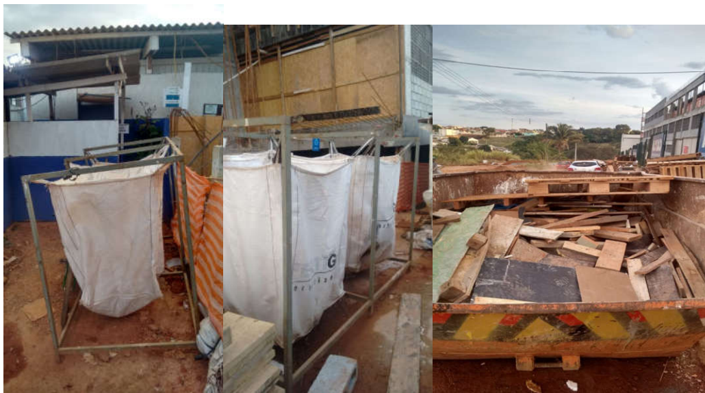
Figura 2: Coleta dos resíduos sólidos na obra.
