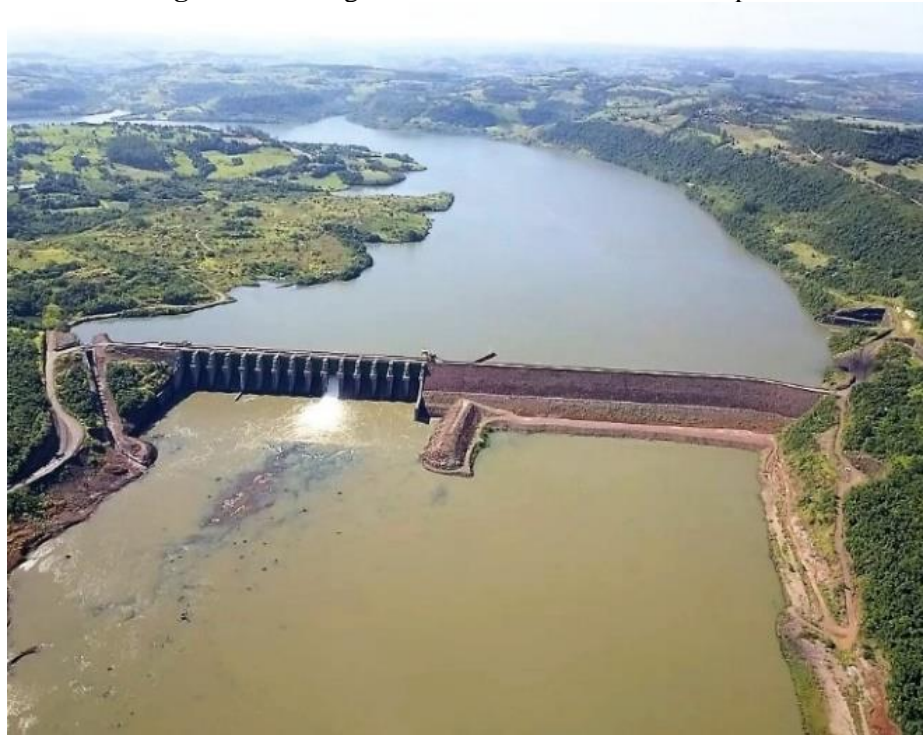
Figura 5 - Barragem de Enrocamento Foz de Chapecó
