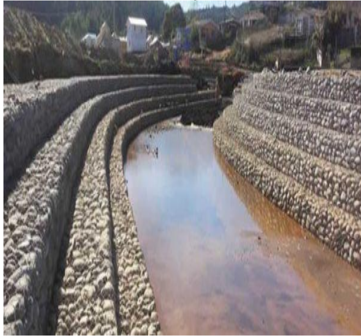
Figura 12 - Barragem de Gabião
