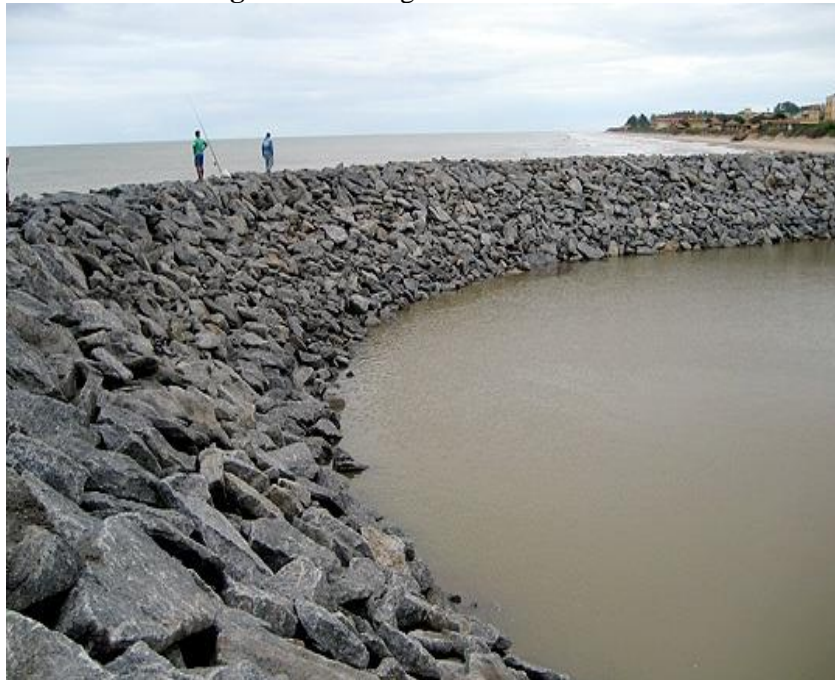
Figura 3 - Barragem de Enrocamento
