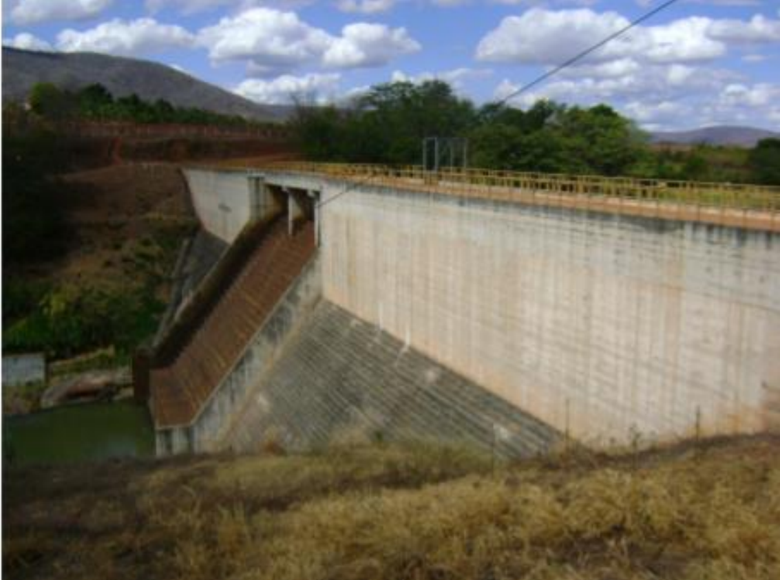
Figura 8 - Barragem de Caraíbas em Gravidade em CCR (Concreto Compactado com Rolo)
