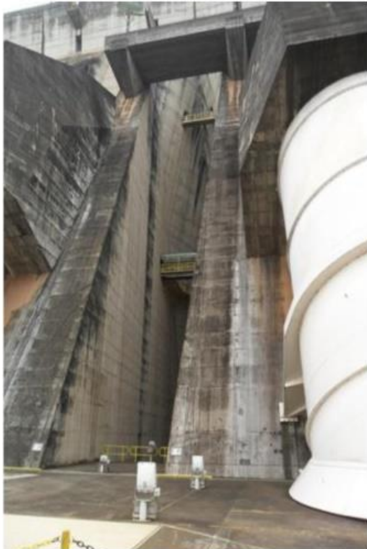
Figura 9 - Barragem em Gravidade Aliviada - UHE Itaipu Binacional, PR
