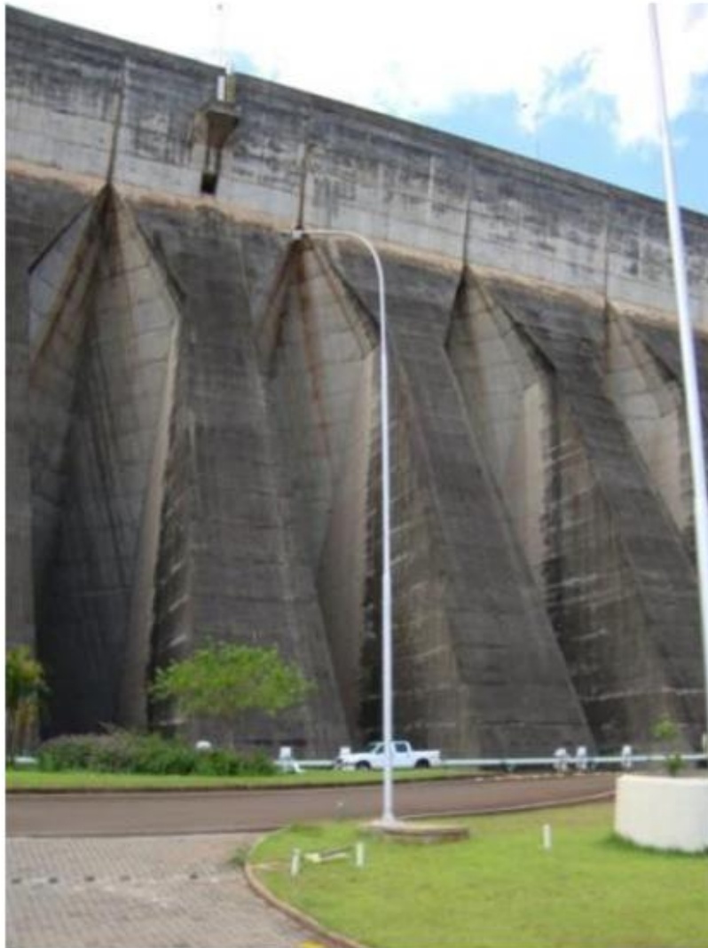
Figura 10 - Barragem construída com Contraforte - UHE Itaipu Binacional, PR
