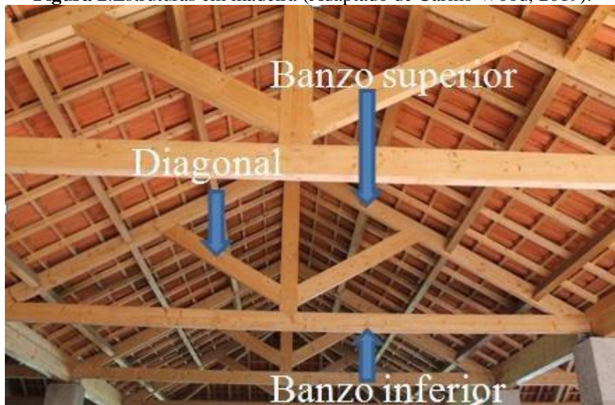
Figura 2. Estruturas em madeira (Adaptado de Carmo Wood, 2019).
