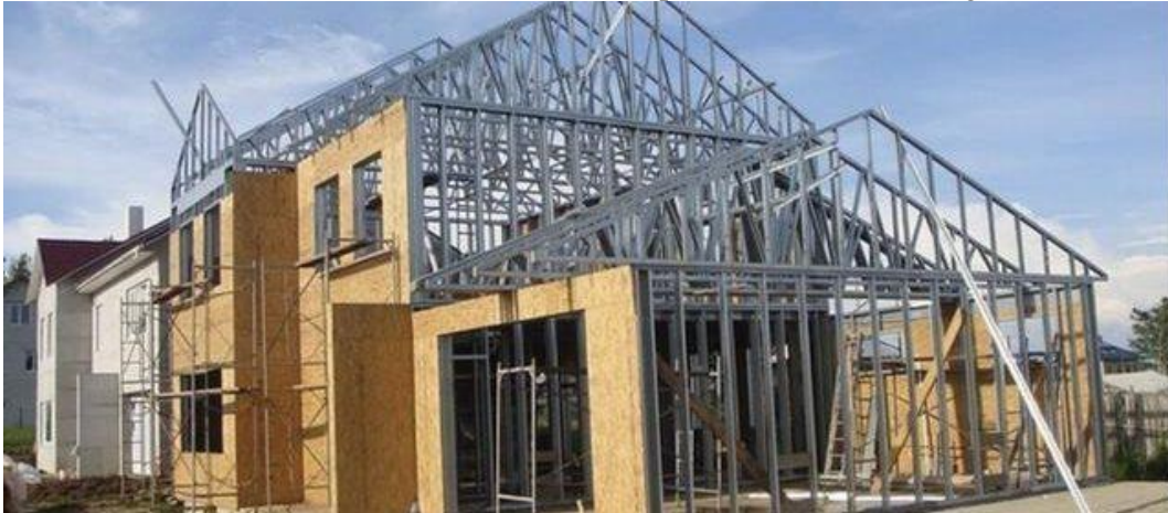
Figura 3. Steel Frame sendo utilizado em estruturas de parede e cobertura (Blog do Gesseiro, 2019).
