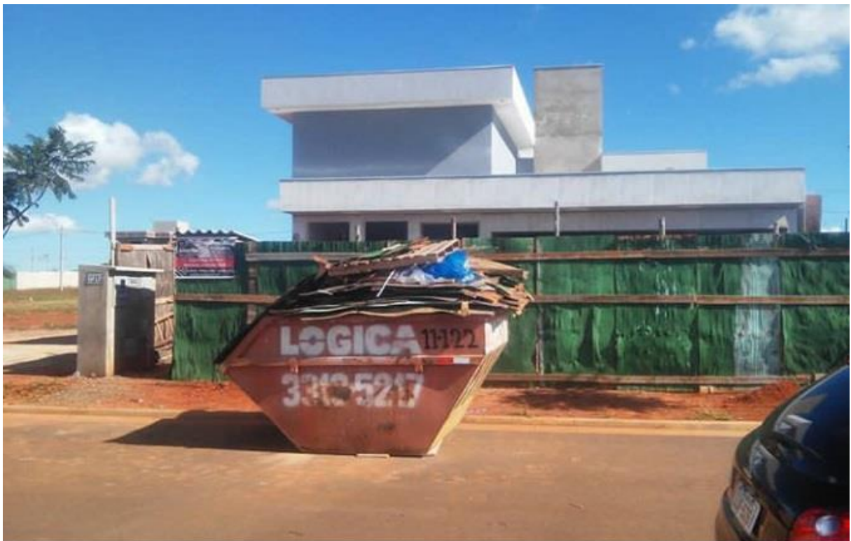
Figura 19: Resíduos sólidos em obra de pequeno porte
