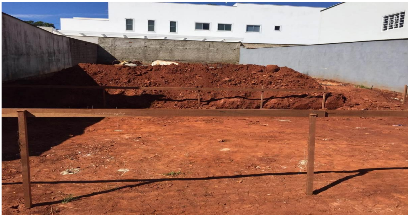
Figura 3 – Início de execução da fundação para a construção.
