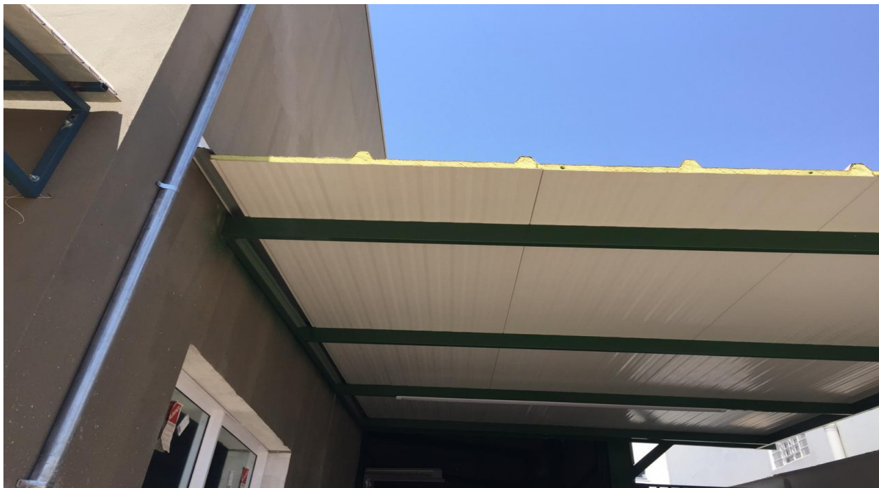
Figura 8 – Telhado já instalado na portaria.(Fase final da obra.)
