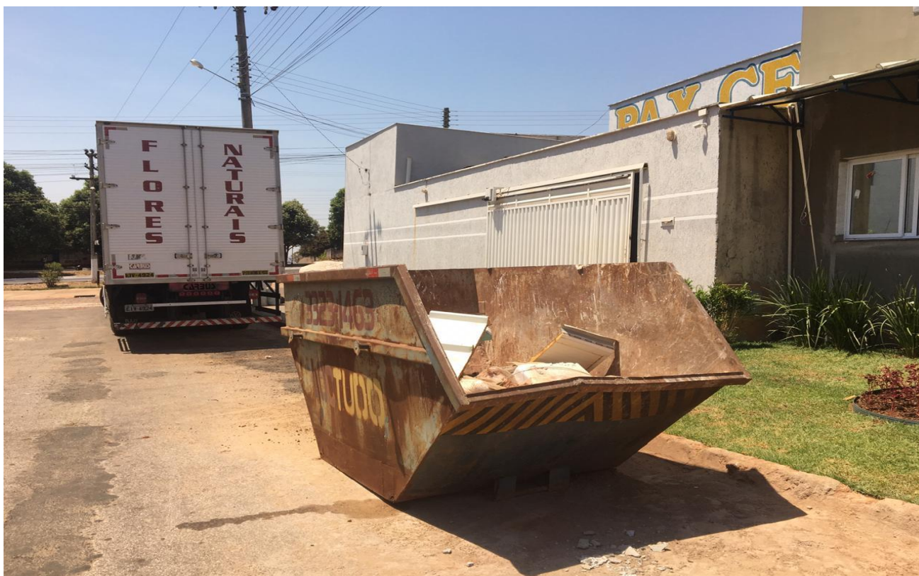
Figura 7 – Caçamba usada para o descarte correto das sobras.
