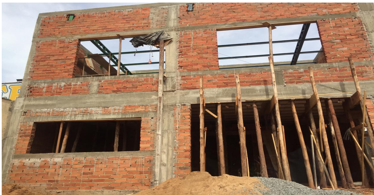
Figura 4 – Frente do imóvel. (Fase intermediária da obra.)
