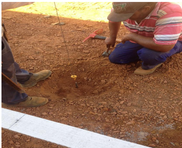
Figura 26: Verificação do prumo da marcação da estaca
