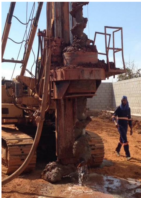
Figura 5: Início da perfuração
