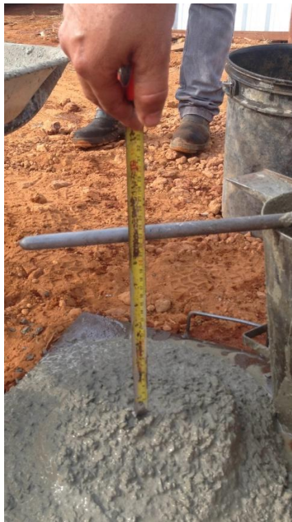
Figura 32: Verificação do Slump atingido
