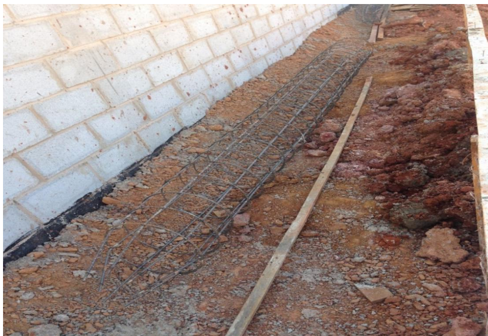
Figura 27: Armação da estaca no canteiro
