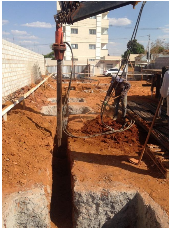
Figura 41: Perfuração da estaca circular de apoio
