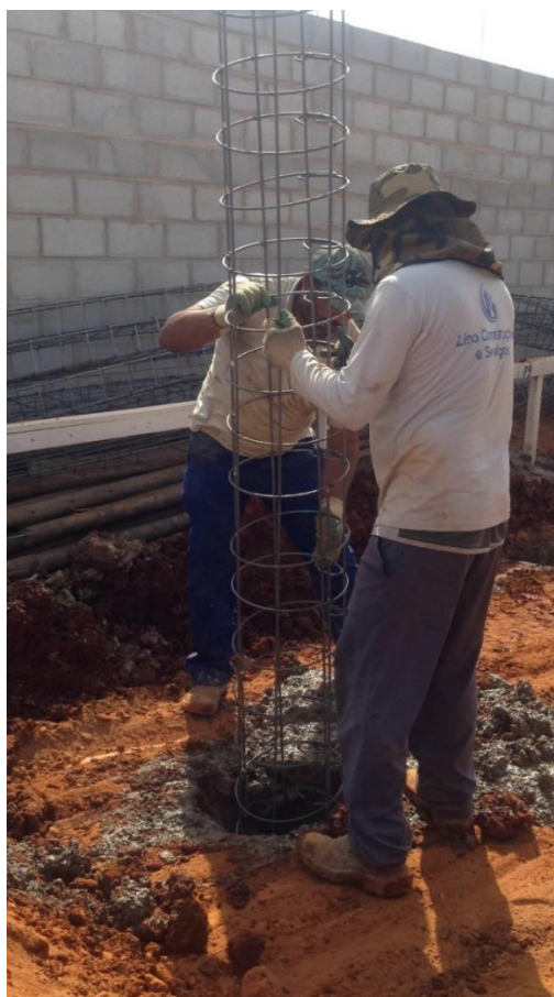
Figura 35: Colocação da armação da primeira estaca
