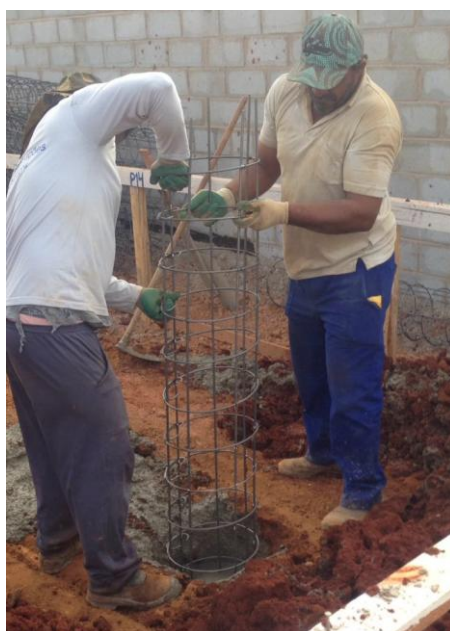
Figura 6: Colocação da armadura
