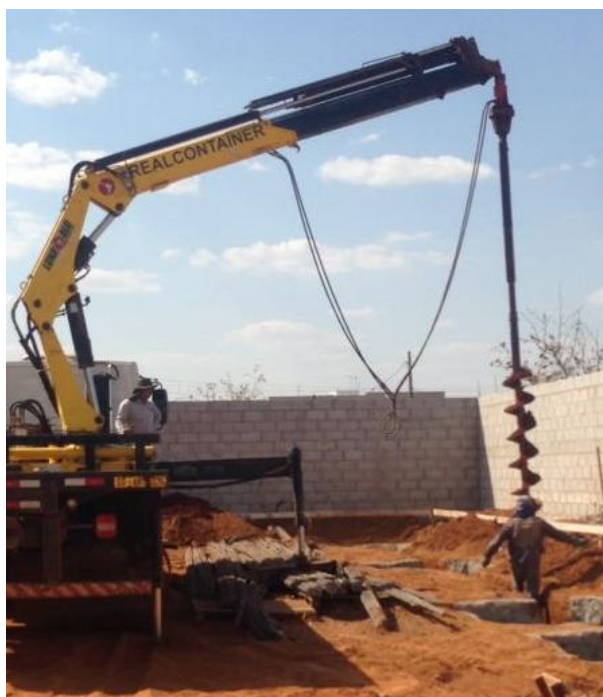
Figura 40: Verificação do prumo da estaca circular de apoio para perfuração
