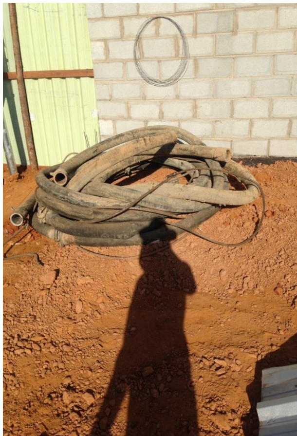
Figura 29: Mangotes utilizados para injeção de concreto após a perfuração
