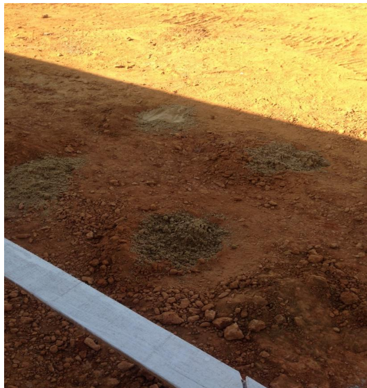
Figura 25: Marcação com areia nos pontos das estacas
