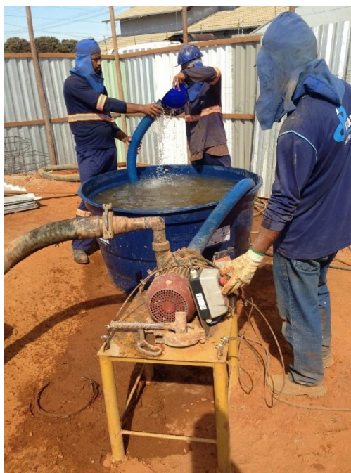
Figura 33: Limpeza dos mangotes da máquina perfuradora
