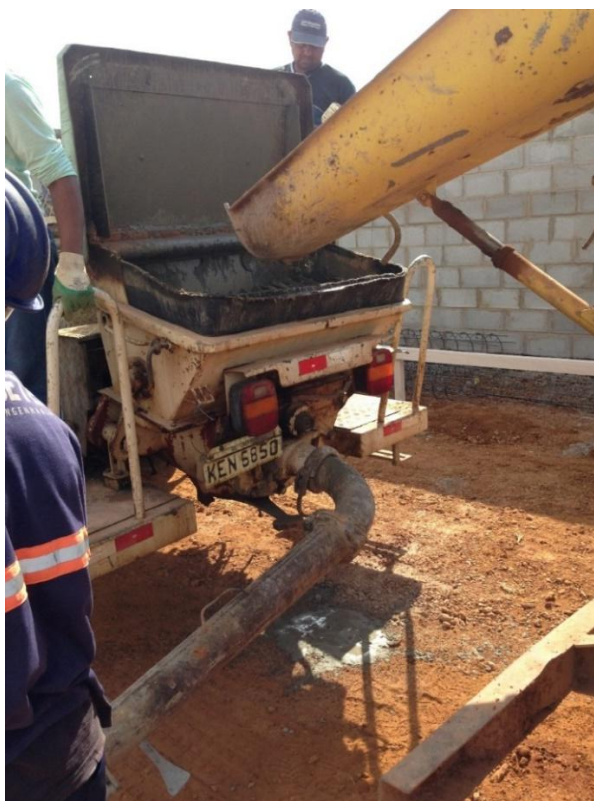
Figura 30: Concreto sendo despejado na bomba para lançamento
