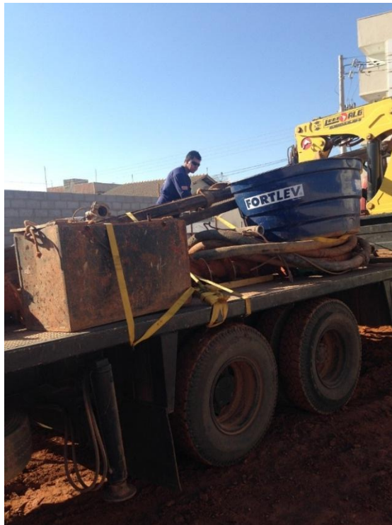
Figura 38: Retirada dos materiais de fundação do canteiro
