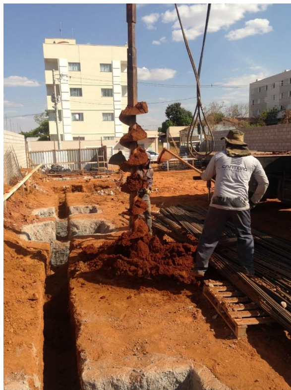
Figura 42: Retirada do solo escavado
