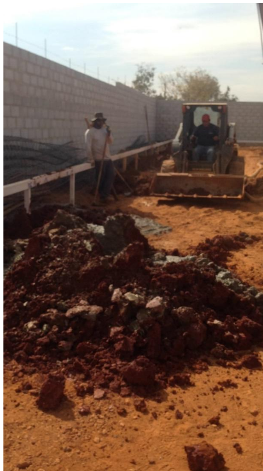
Figura 28: Bobcat fazendo a limpeza após a concretagem da estaca
