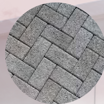
Blocos de concreto permeável
