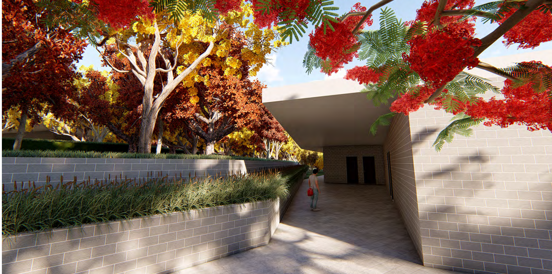
Acesso ao Edifício Educacional. Fonte: Autoral.
