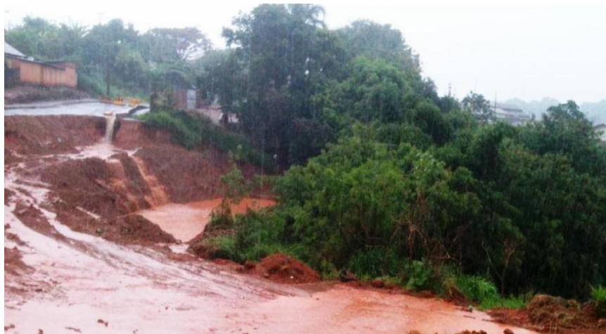
Figura 8: Deslizamento de terra em período chuvoso da Vila Formosa
