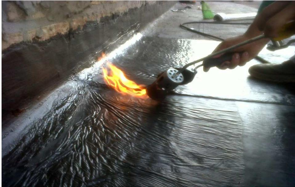
Fonte: Site Plastizil Tecnologia Construtiva (<http://www.plastizil.com/membrana-asfaltica-4-mm-normal-ormiflex-premium-p83>). Nota: manta asfáltica sendo aplicada com uso e maçarico.
