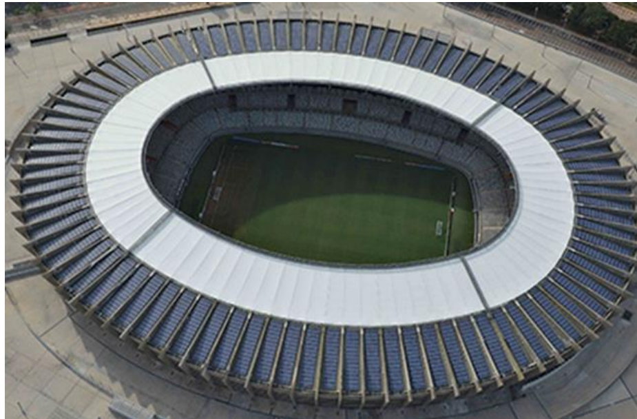
Figura 16 – Cobertura com painéis fotovoltaicos.
