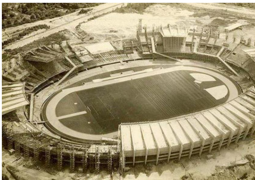
Figura 8 – Construção do Mineirão.
