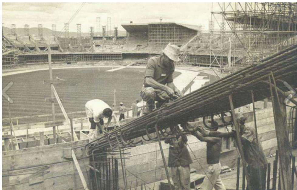
Figura 10 – Operários trabalhando na construção.
