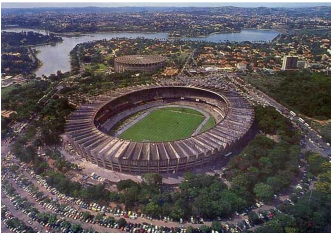
Figura 12 – Vista aérea do Estádio do Mineirão antes da reforma.
