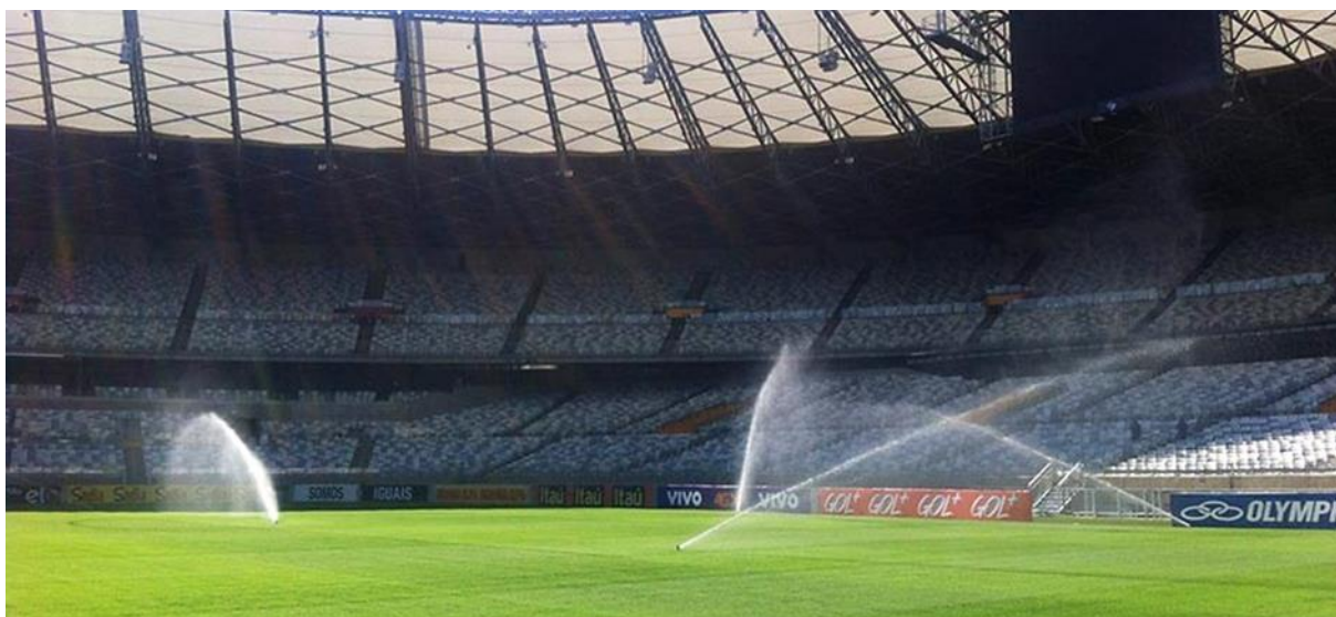
Figura 14 – Sistema de irrigação de água de reuso.
