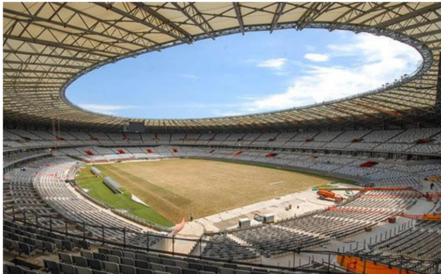
Figura 17 – Parte interna do estádio após reforma.
