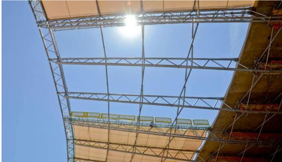
Figura 15 – Membranas utilizadas na cobertura.
