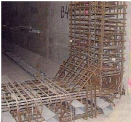
Figura 8 - Armaduras da ponte
