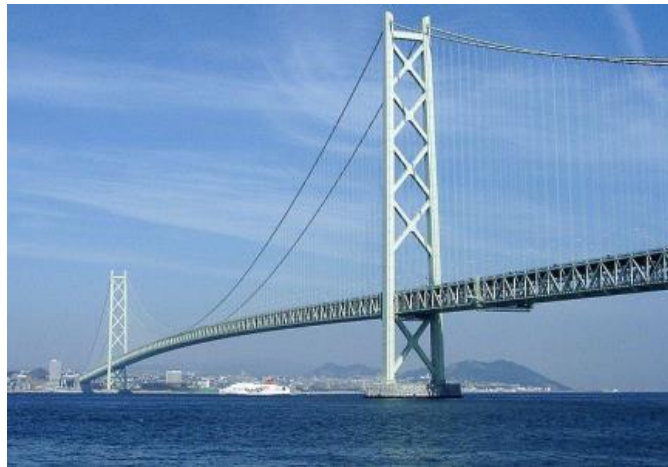
Figura 1 - Ponte Akashi-Kaikyo no Japão
