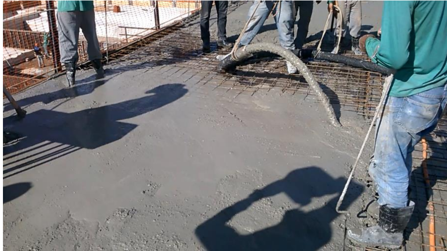
Figura 4 - Concretagem da laje do 1º pavimento tipo do Residencial Amsterdam
