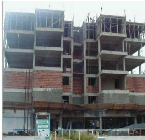
Figura 3 - Edifício Camila, em Goiânia
